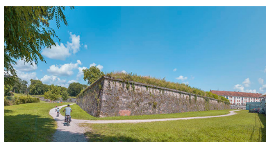
Le bastion du Moineau. Phot. Thierry Kuntz IVR26_20242100286NUC4A
