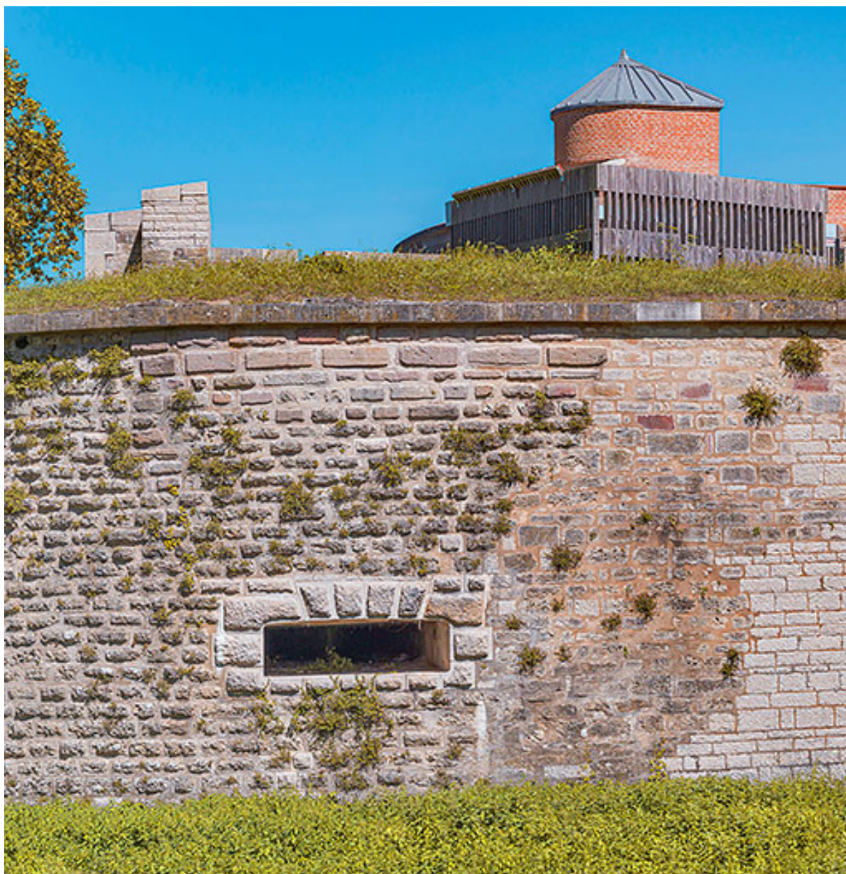
La tour basse des moulins du château.
