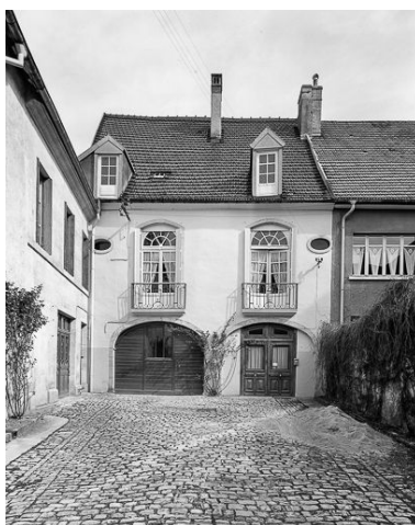
Maison (AE 105) 1 rue Pierre Vernier : vue générale. Phot. Yves Sancey IVR43_19772500034V
