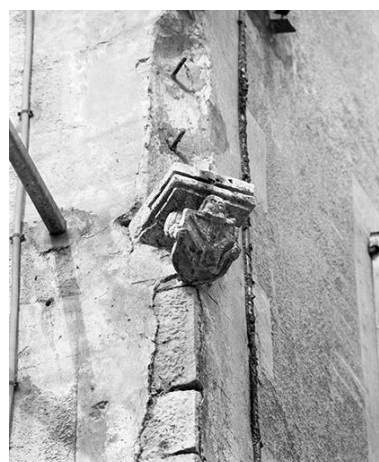
Maison 2 rue saint-Laurent : console à l'angle de la rue Saint- Laurent et de la place de la Fontaine. Phot. Yves Sancey IVR43_19772500081X
