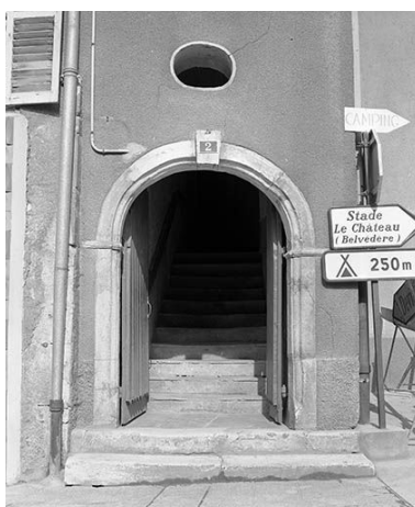
Maison 2 avenue du Président- Wilson : porte piétonne. Phot. Yves Sancey IVR43_19772500069X
