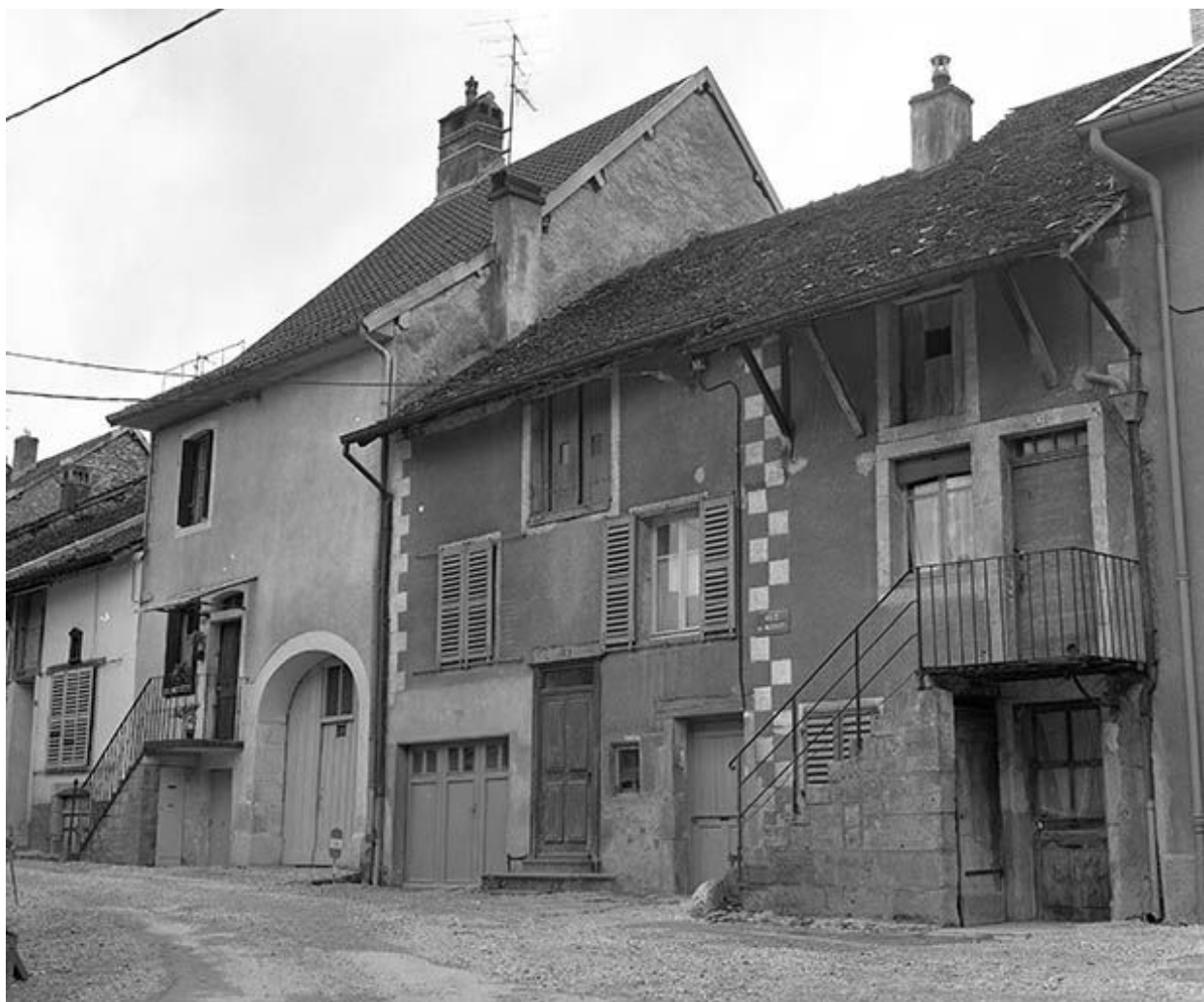
Maisons 13 à 17 rue des Martinets : vue générale.
