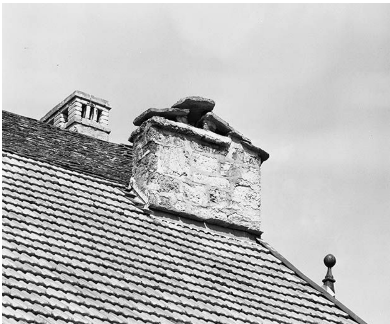
Détail d'une souche de cheminée.
