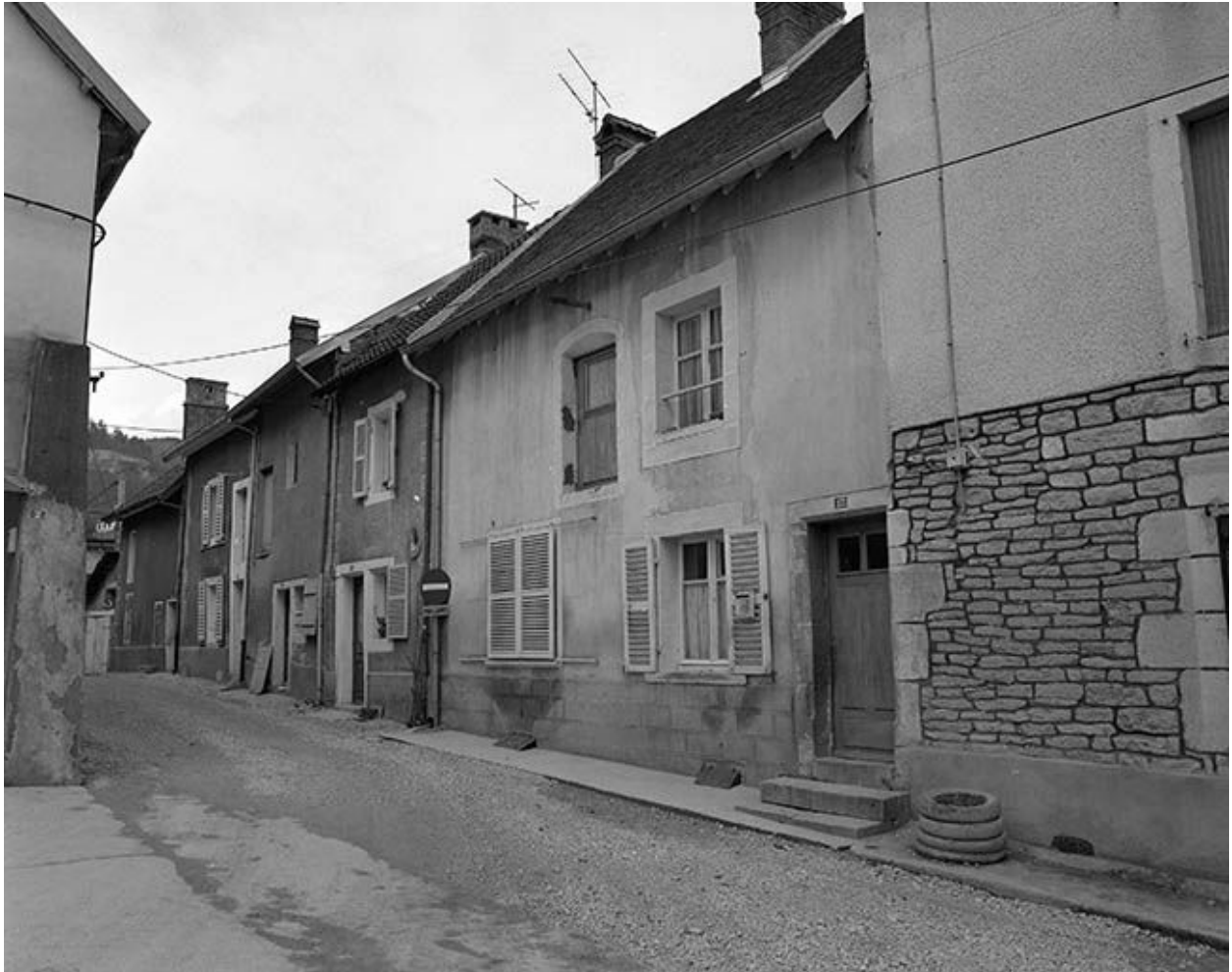
Maisons 12 à 14 rue des Martinets : vue générale.
