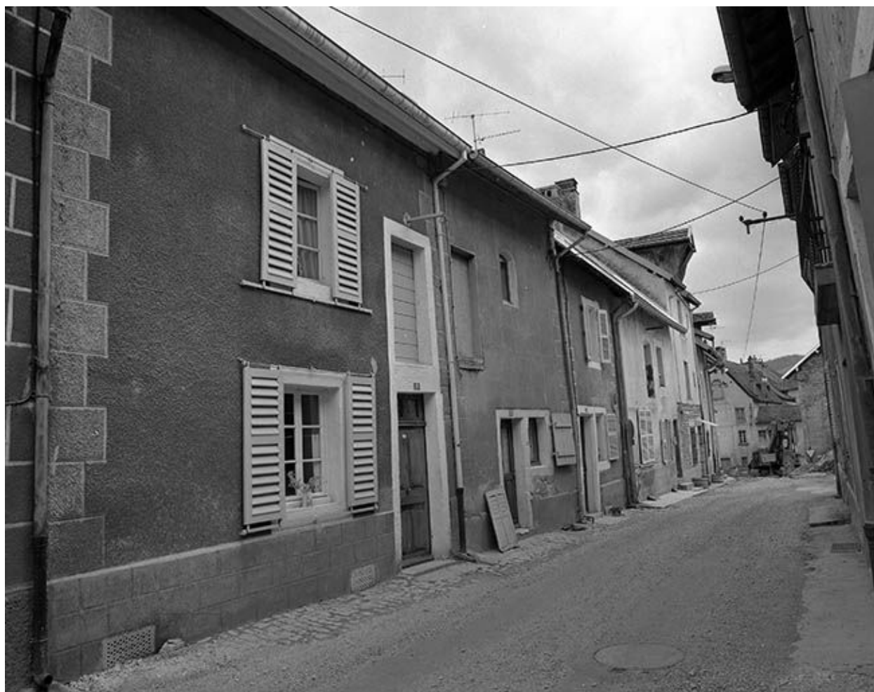
Maisons 14 à 15 rue des Martinets : vue générale.
