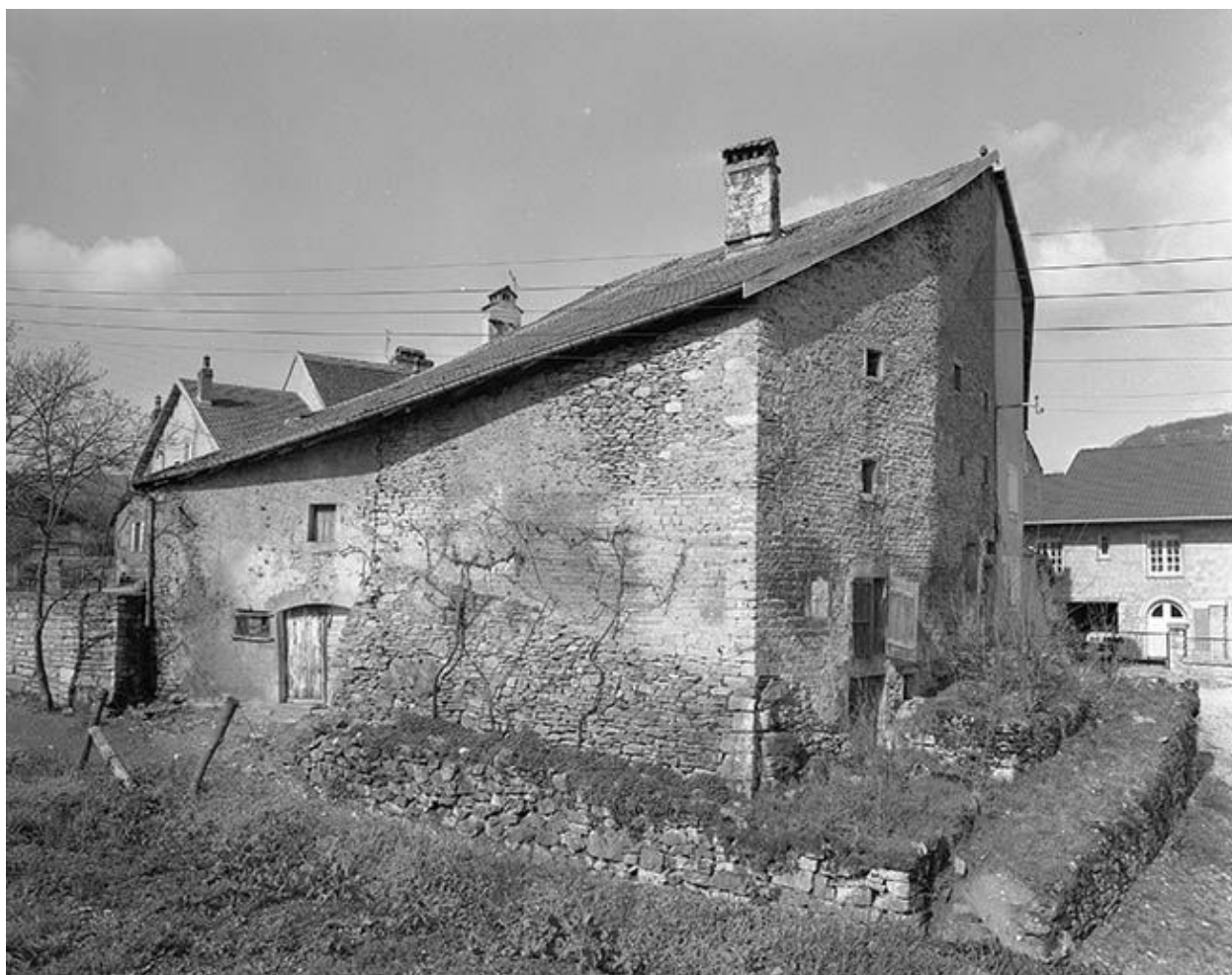
Maison 4 rue du Vieux-Seult : façade antérieure et façade latérale gauche.
