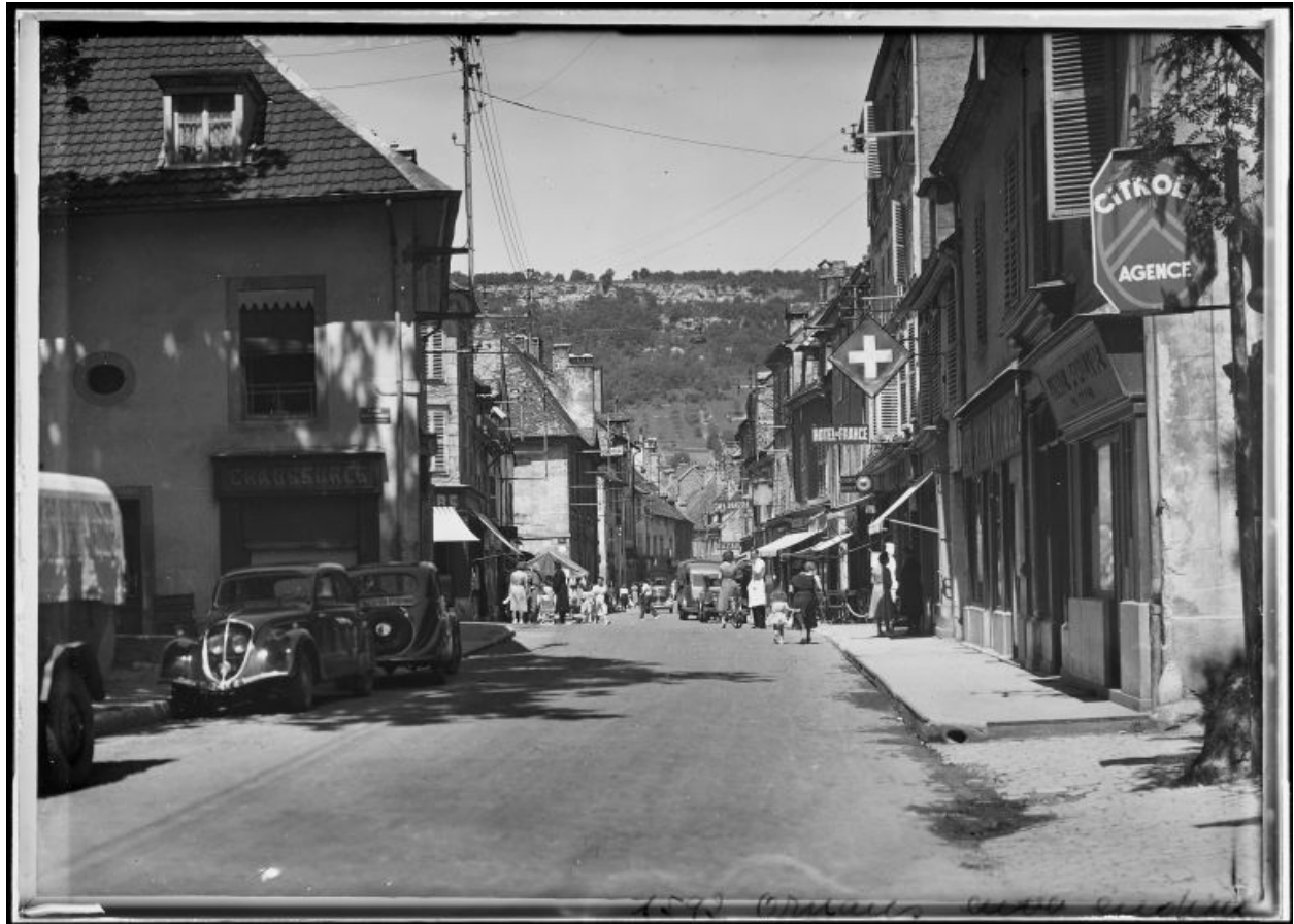
Rue Pierre Vernier : vue à hauteur du n° 65 [1re moitié 20e siècle].
