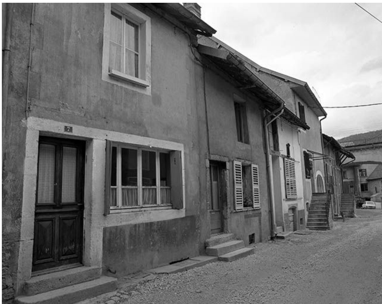
Maisons 7 à 13 rue des Martinets : vue générale.
