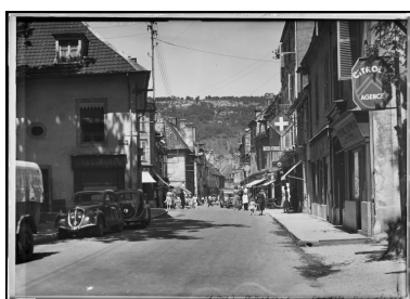
Rue Pierre Vernier : vue à hauteur du n° 65 [1re moitié 20e siècle].
