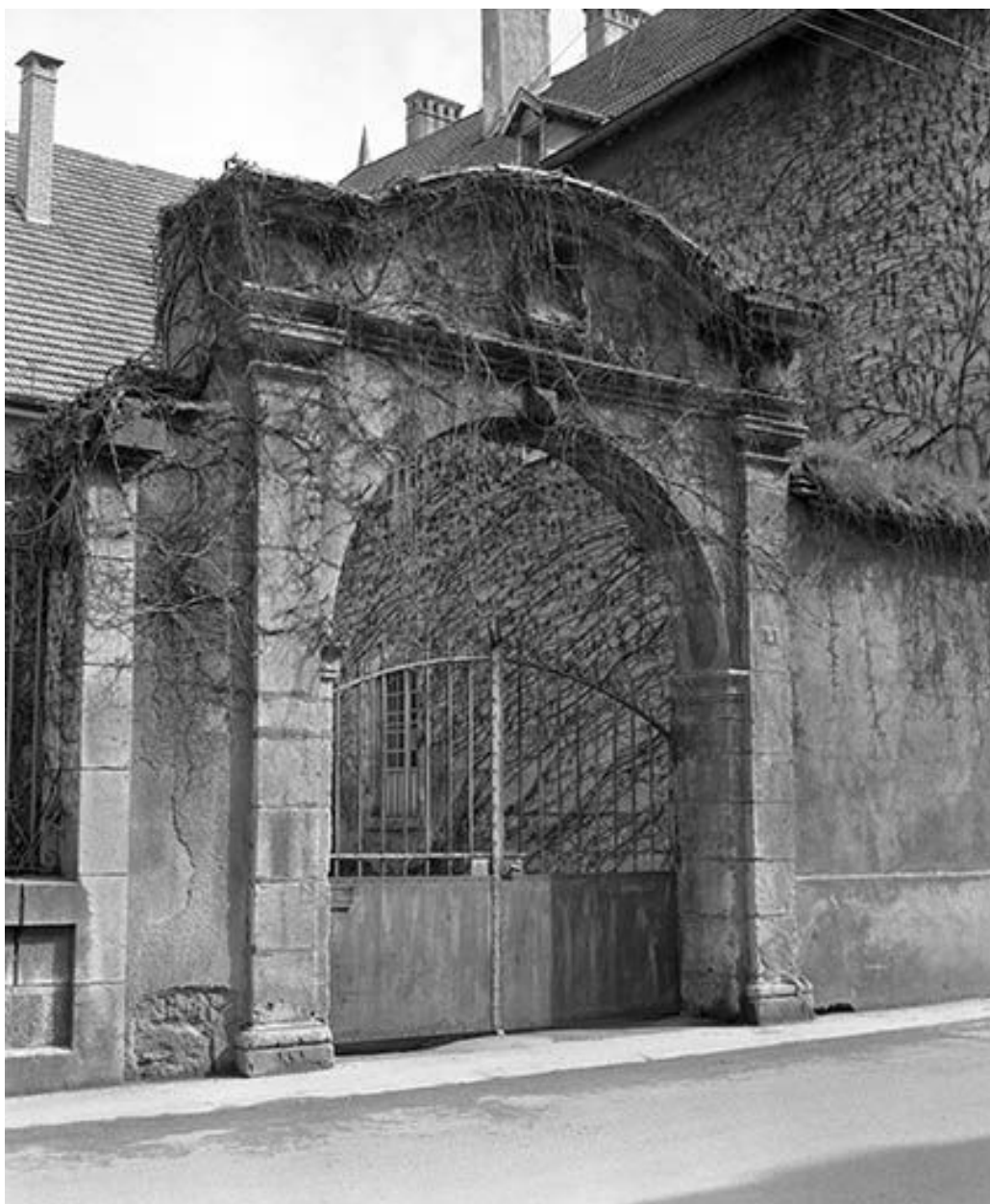
Maison (AE 104) 3 rue Pierre Vernier : le portail.
