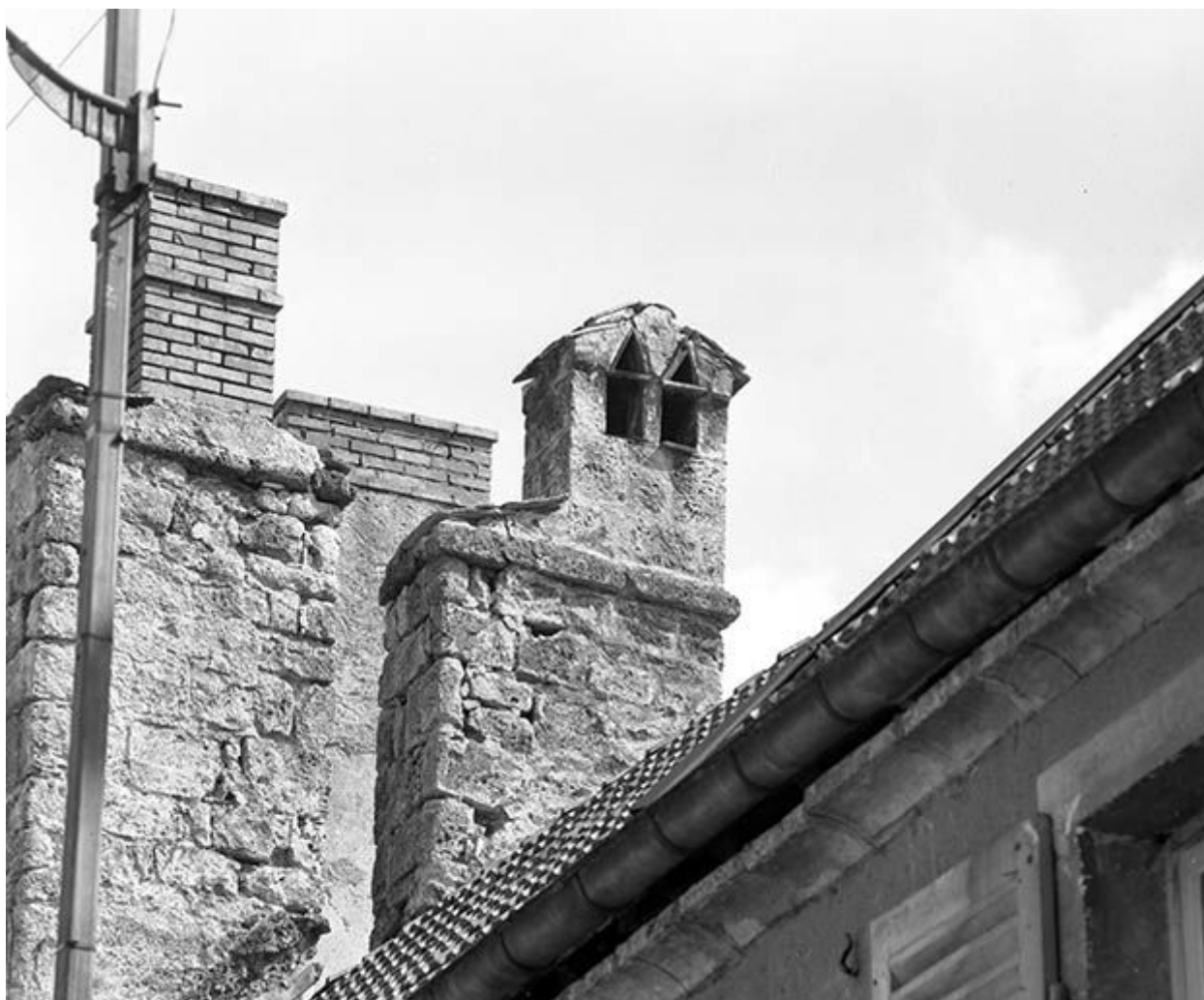
Détail d'une souche de cheminée.
