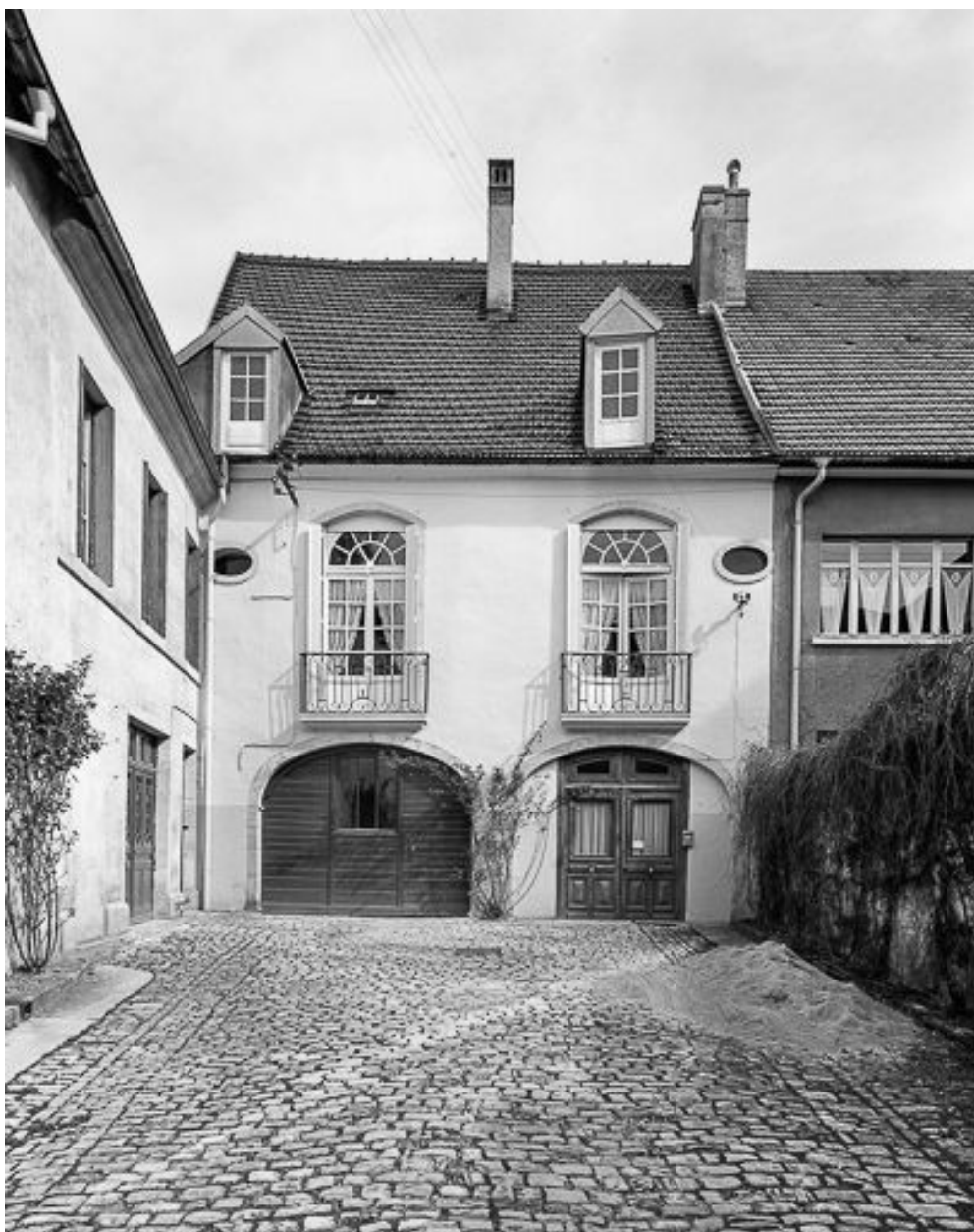
Maison (AE 105) 1 rue Pierre Vernier : vue générale.
