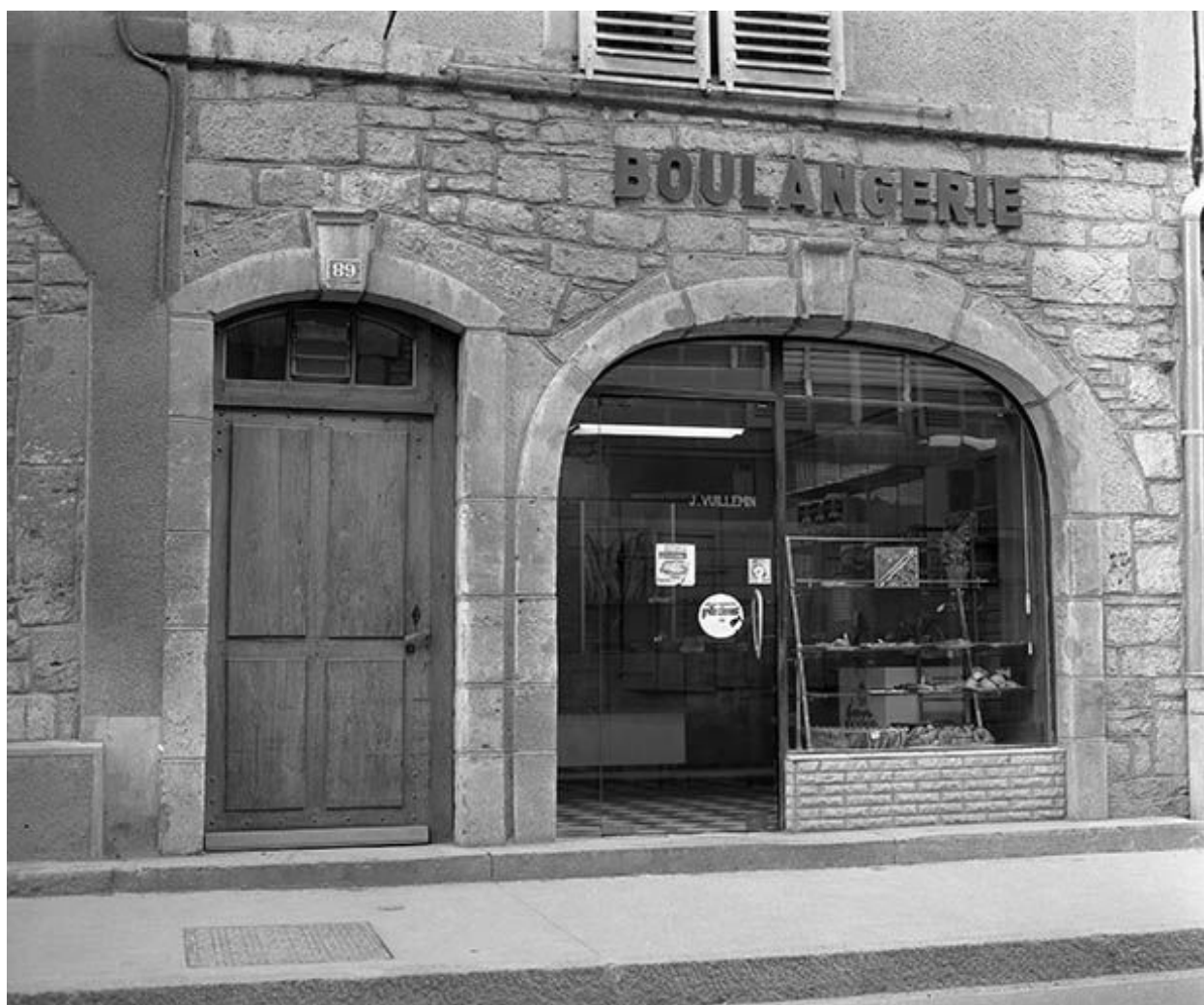
Maison (AE 36) 89 rue Pierre-Vernier : détail des baies du rez-de-chaussée.
