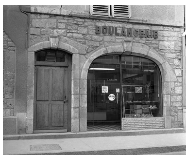
Maison (AE 36) 89 rue Pierre-Vernier : détail des baies du rez-de-chaussée. Phot. Yves Sancey IVR43_19772500030X
