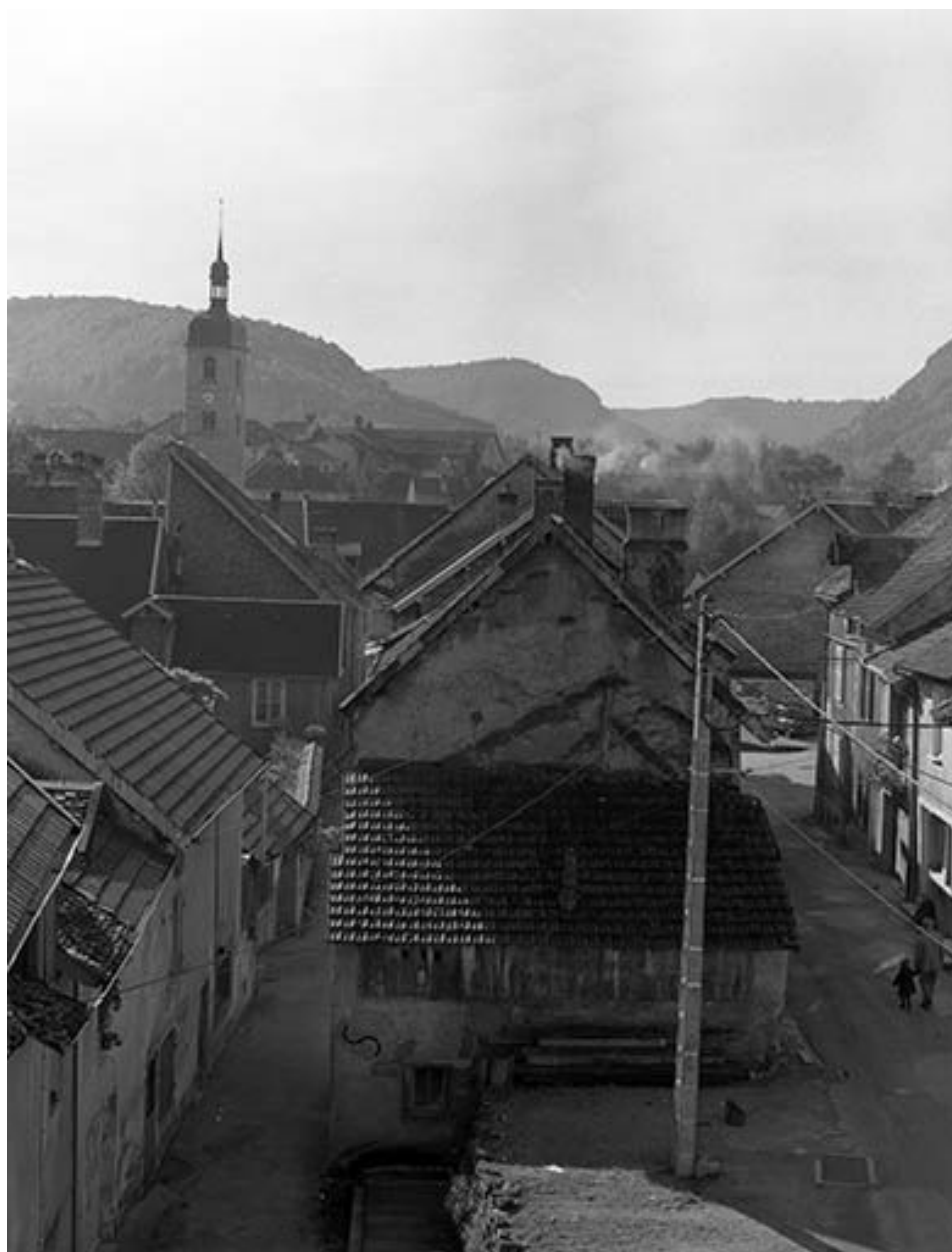
Vue générale de la rue des Martinets et de la rue du Stade depuis le pont de chemin de fer.
