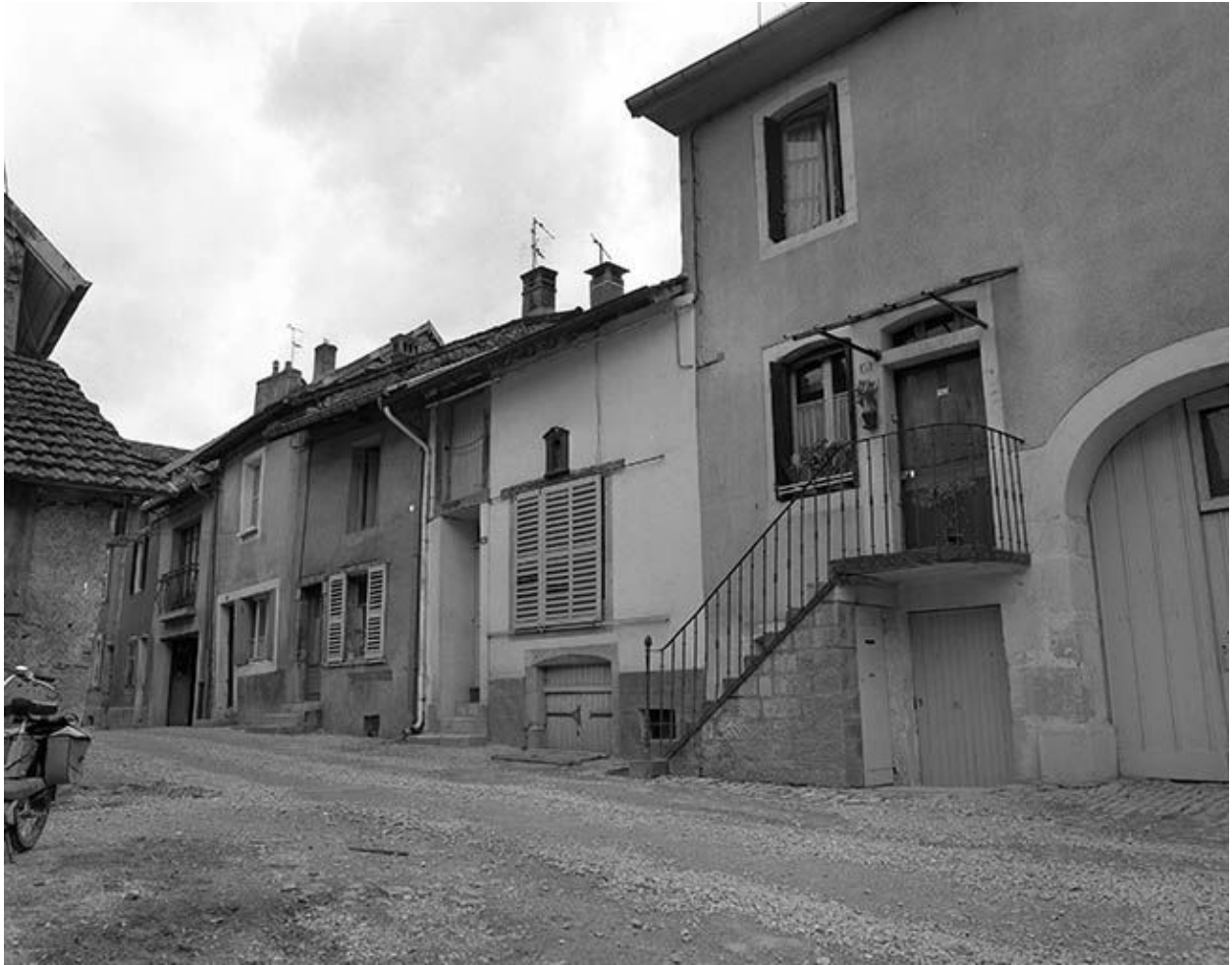
Maisons 11 à 13 rue des Martinets : vue générale.
