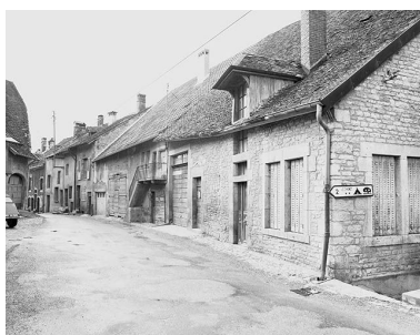
Maisons du côté pair de la rue du Champliman. Phot. Yves Sancey IVR43_19772500214X
