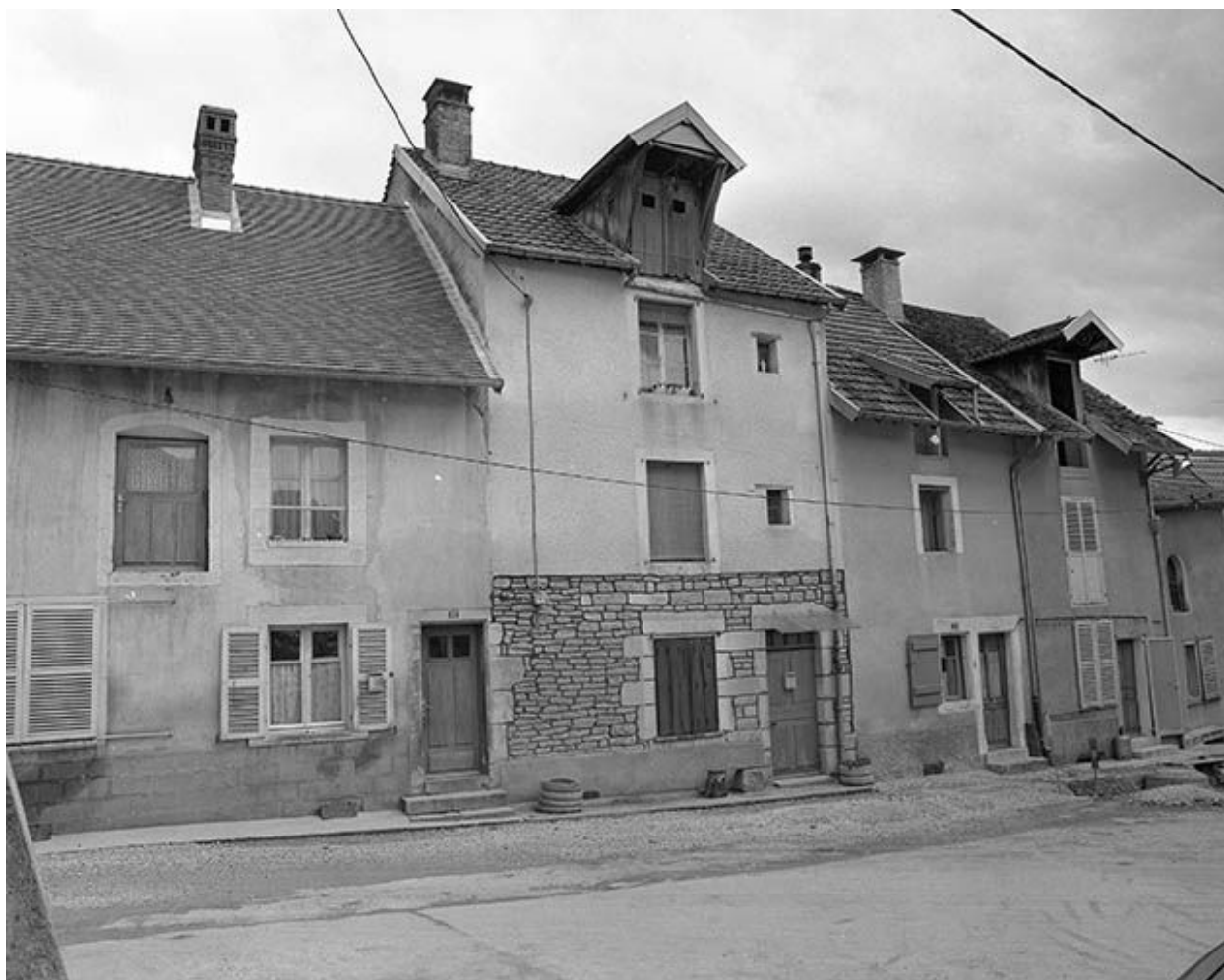
Maisons 6 à 12 rue des Martinets : vue générale.
