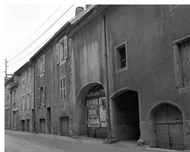
Maisons 28 et 30 rue Eugène-Cusenier. Phot. Yves Sancey IVR43_19772500033X
