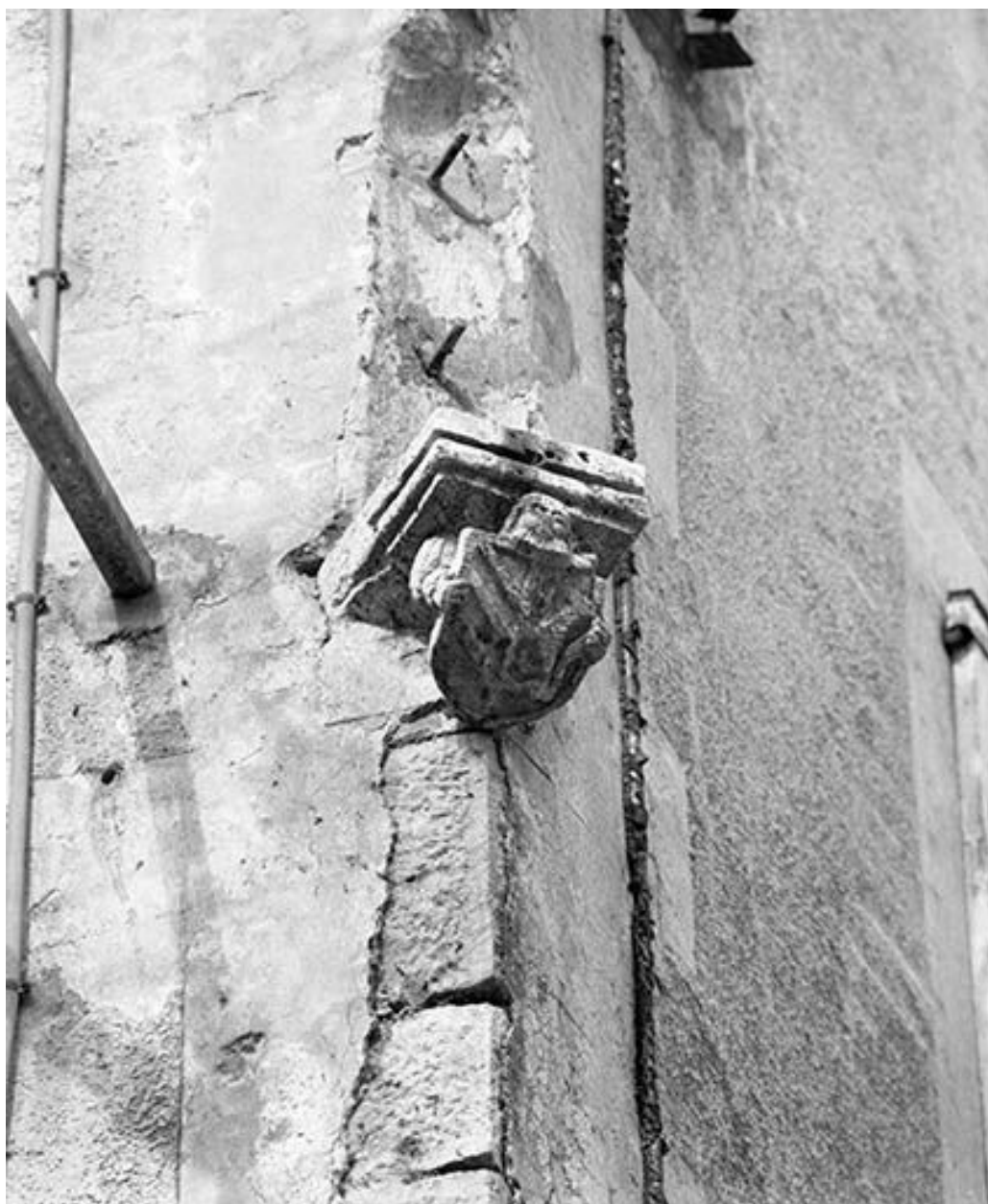
Maison 2 rue saint-Laurent : console à l'angle de la rue Saint-Laurent et de la place de la Fontaine.
