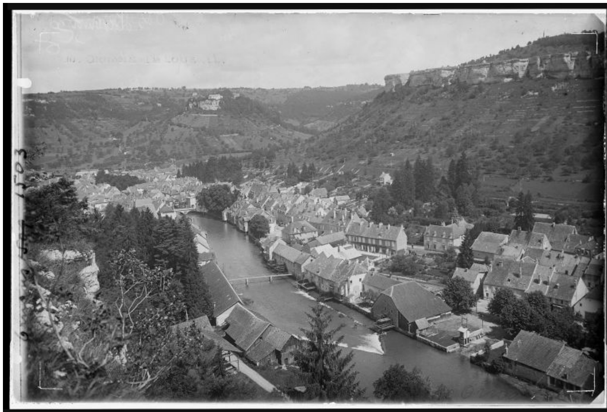
Vue d'ensemble [1re moitié 20e siècle].
