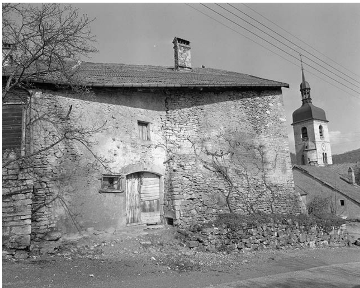
Maison 4 rue du Vieux-Seult : façade latérale gauche.
