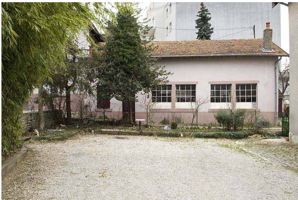
Façade ouest de l'atelier de fabrication.
