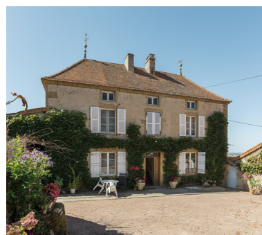
Façade antérieure de la maison Phot. Pierre-Marie Barbe-Richaud IVR26_20197100358NUC4AQ
