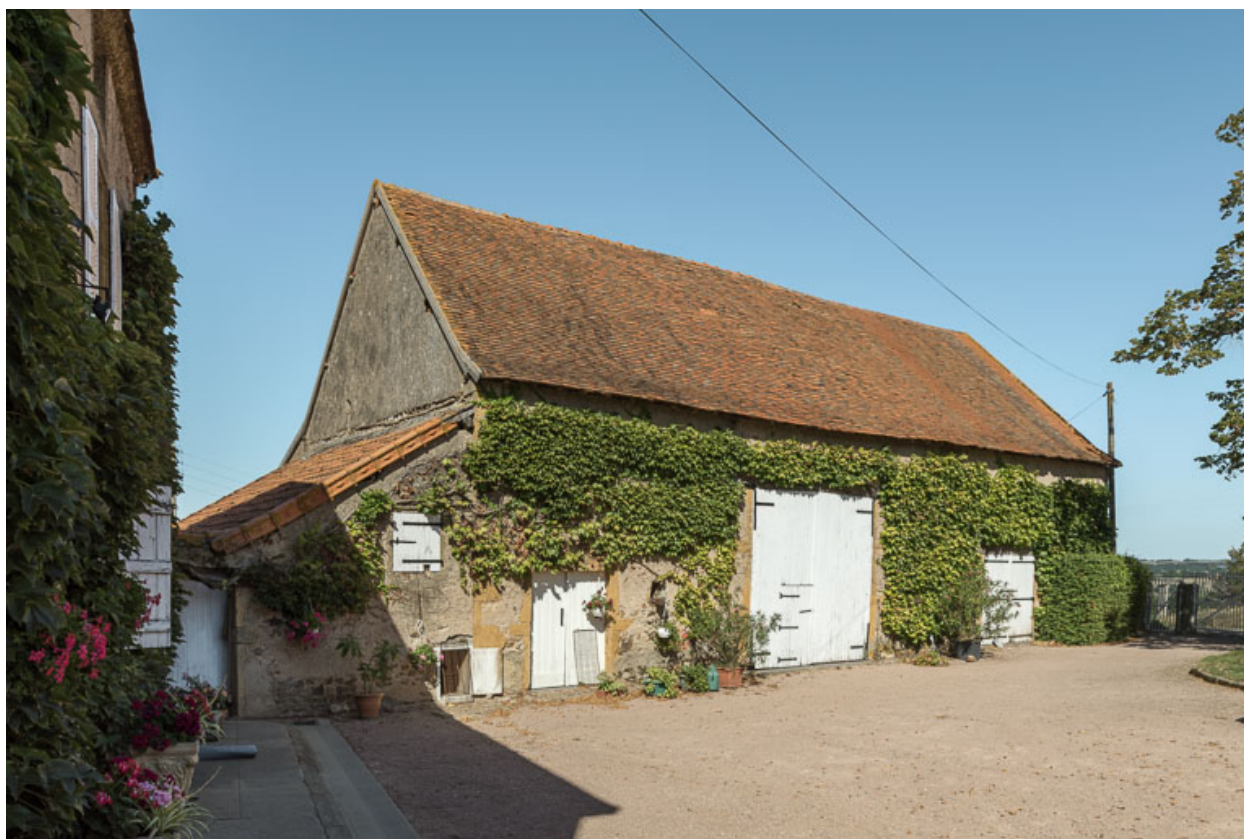
Façade antérieure de la grange
