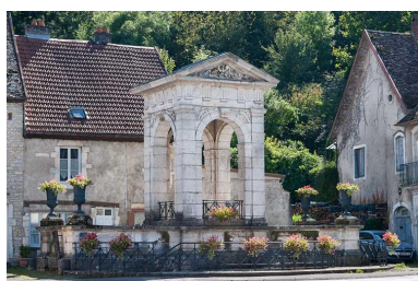
Vue générale nord Phot. Jérôme Mongreville IVR43_20137000416NUCA
