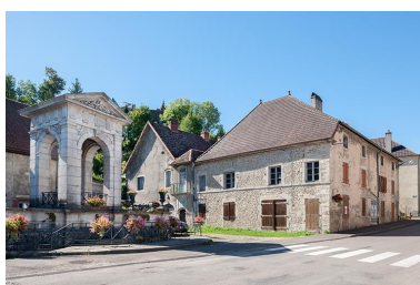
Vue d'ensemble nord-est Phot. Jérôme Mongreville IVR43_20137000255NUCA
