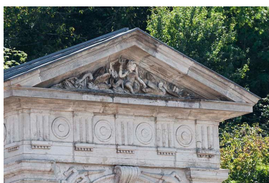
Détail du fronton triangulaire Phot. Jérôme Mongreville IVR43_20137000417NUCA
