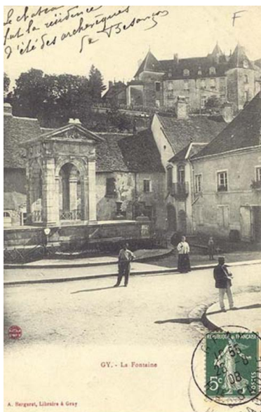
La fontaine sur une carte postale ancienne IVR43_20137000759NUC2A
