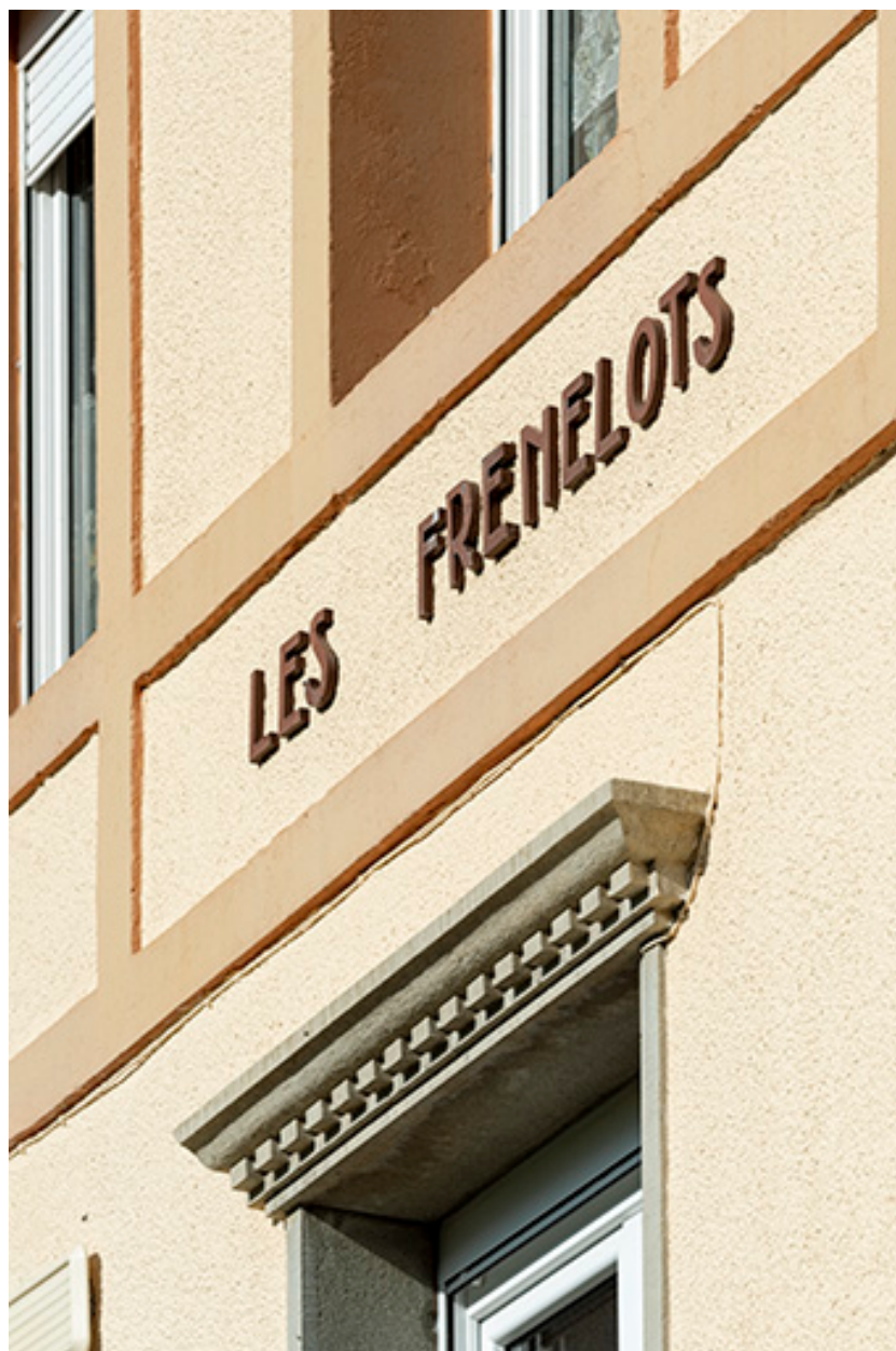
Façade antérieure : détail du décor.
