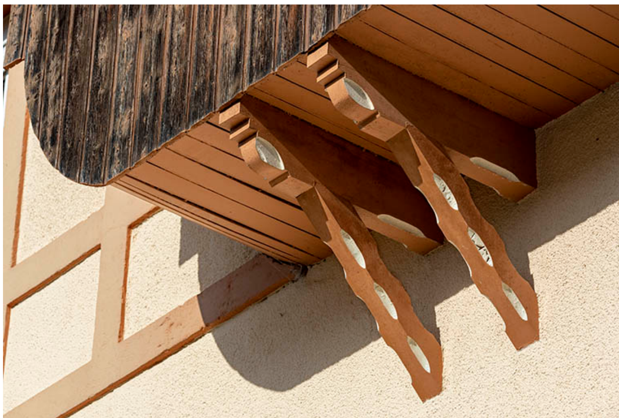
Façade antérieure : corbeaux en bois supportant le rang-pendu.
