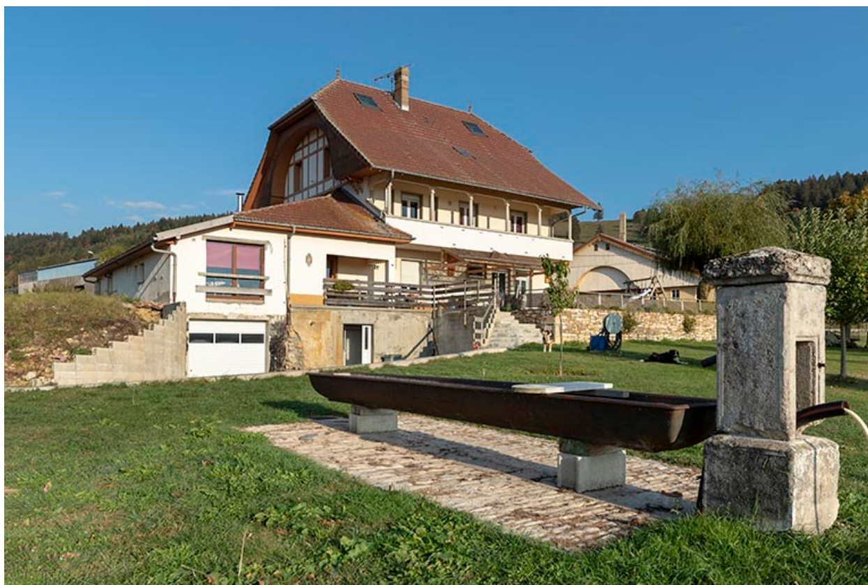
Façades postérieure et latérale gauche.
