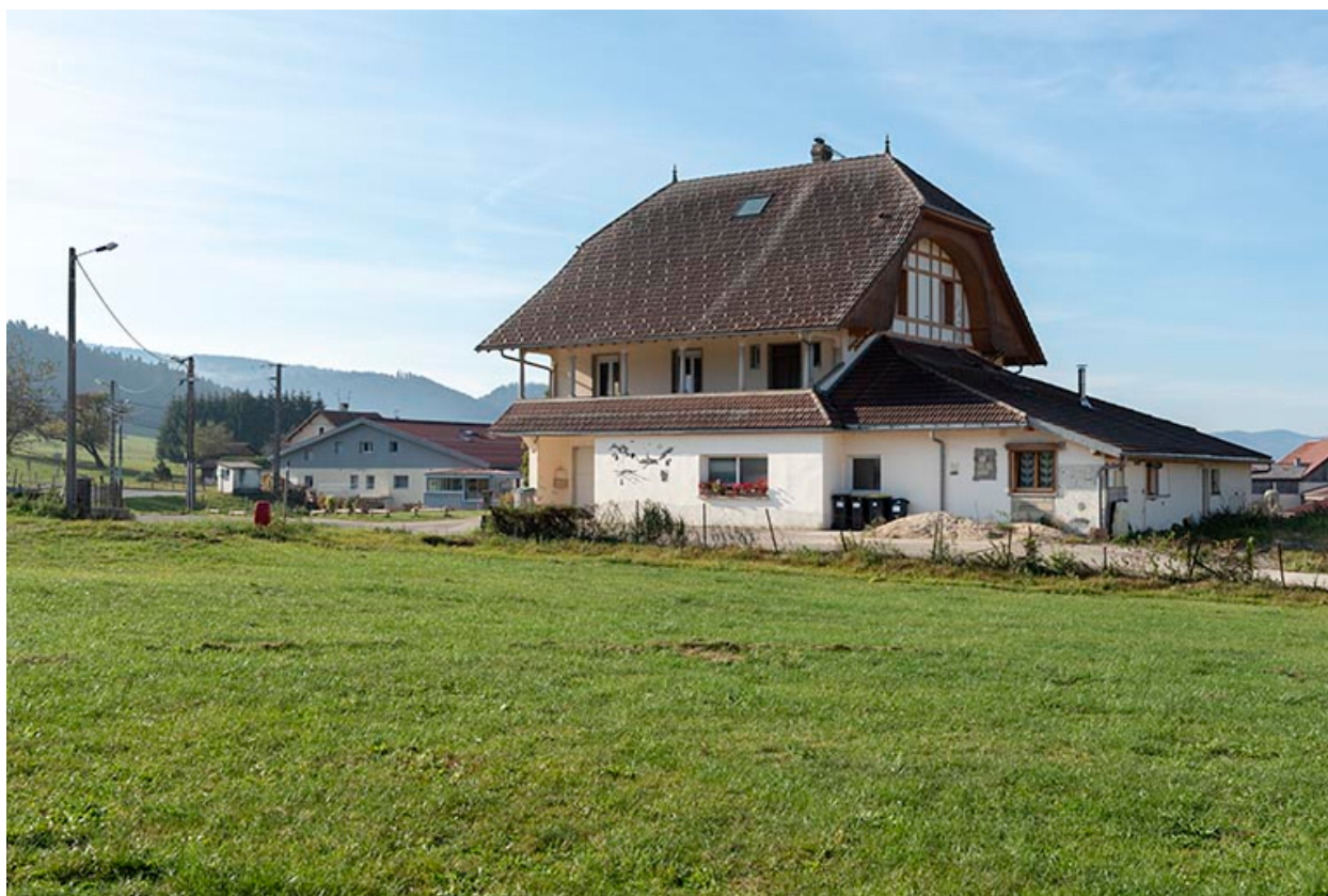
Façades postérieure et latérale droite.
