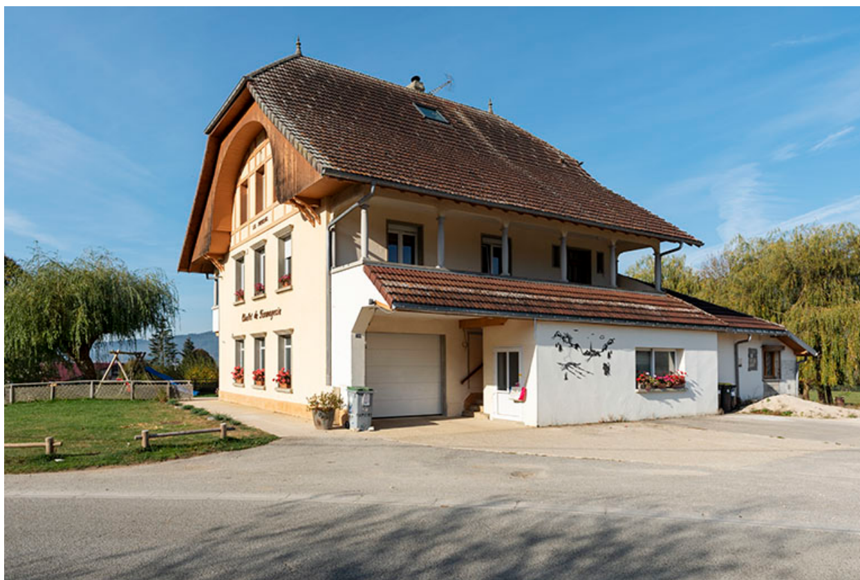
Façades antérieure et latérale droite.
