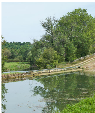
Vue du déversoir.
