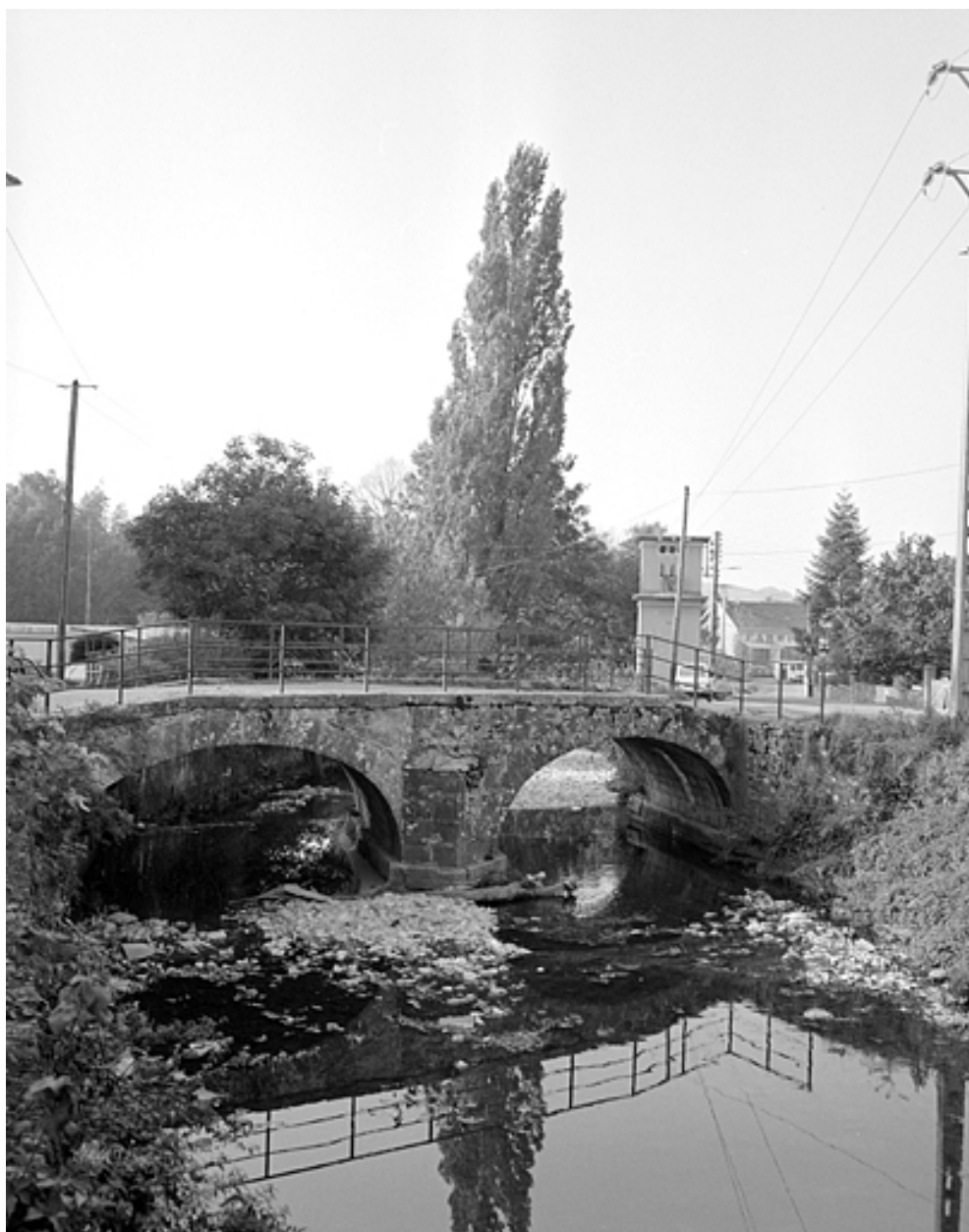
Vue du pont en amont.
