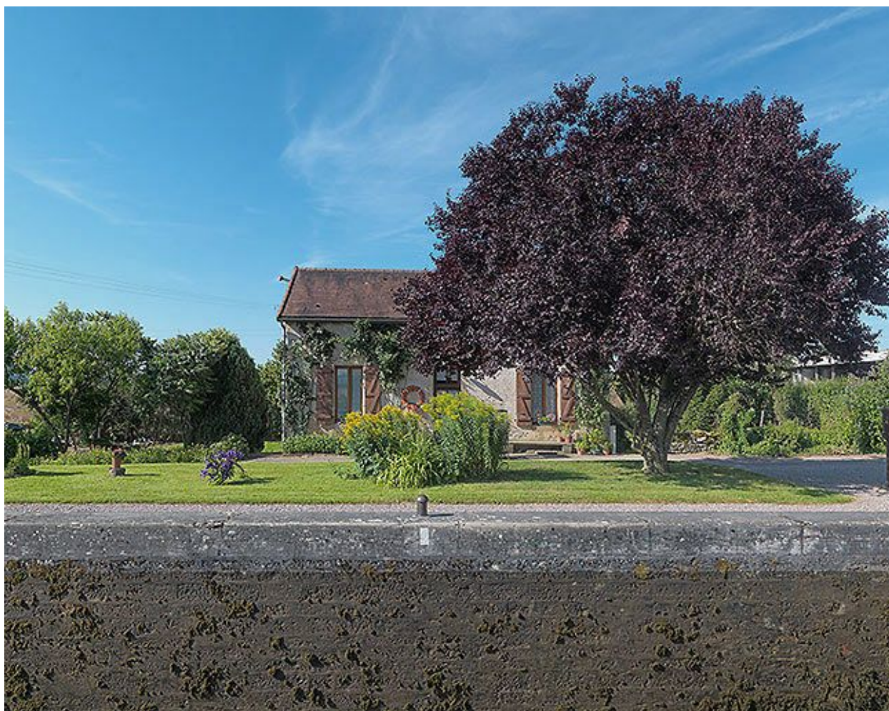
La maison éclusière de face.
