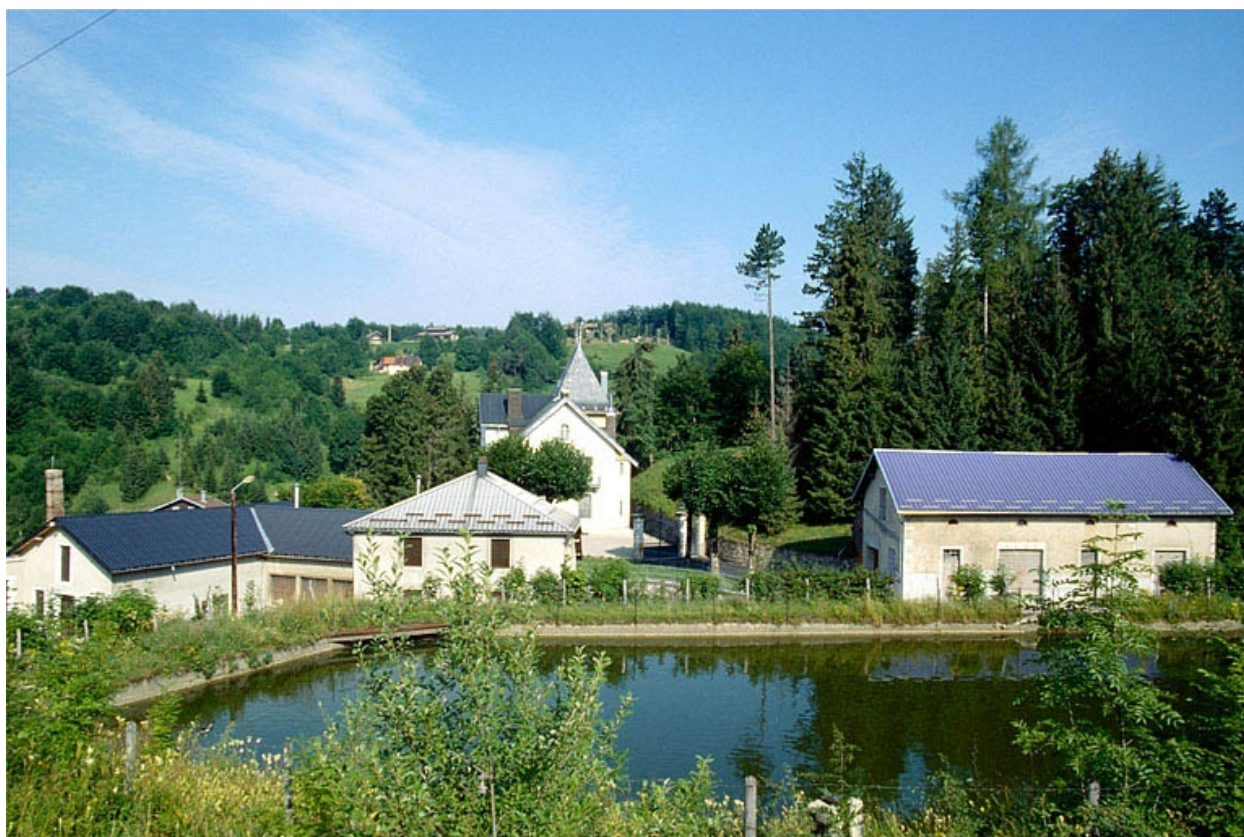
Bassin de retenue et façades sur rue.
