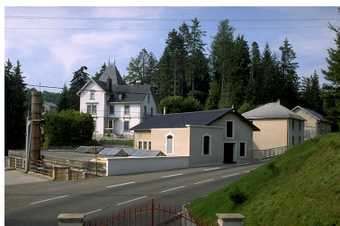
Façades sur rue de trois quarts gauche. Phot. Laurent Poupard IVR43_19913901586ZA
