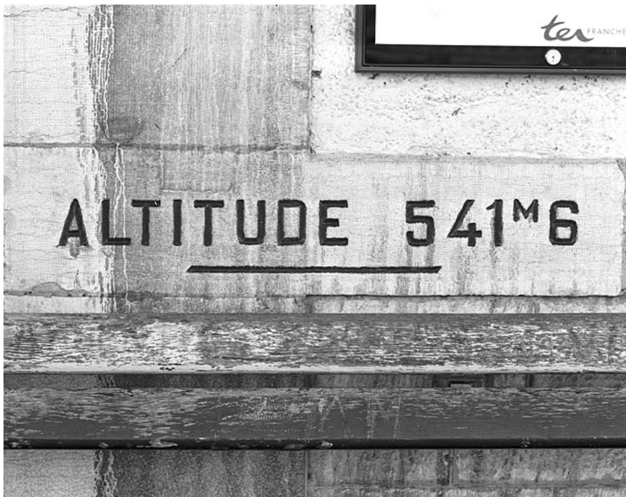
Bâtiment des voyageurs : inscription altimétrique.
