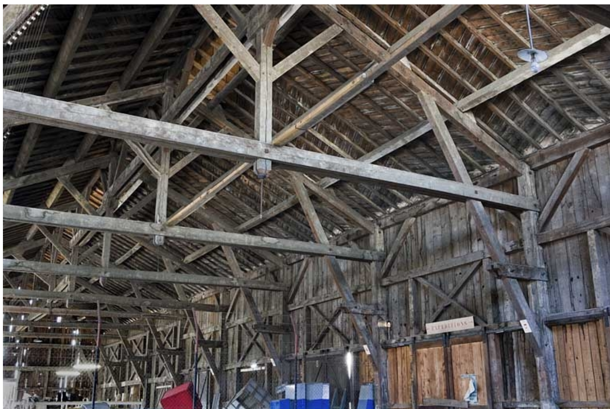
Entrepôt : mur sud et charpente.
