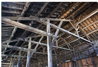
Entrepôt : charpente. Phot. Yves Sancey IVR43_20073900152NUCA
