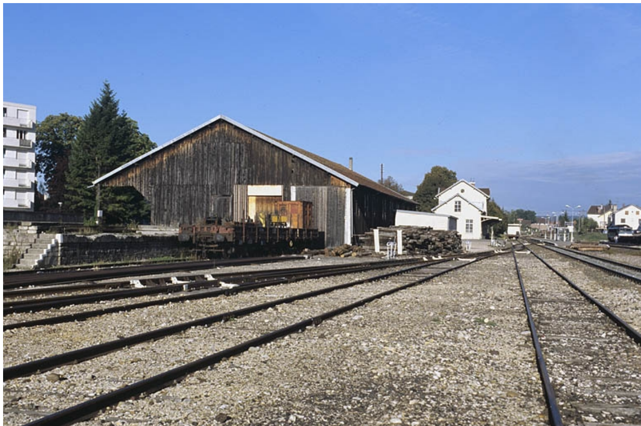
Entrepôt : vue d'ensemble, depuis le sud-est.
