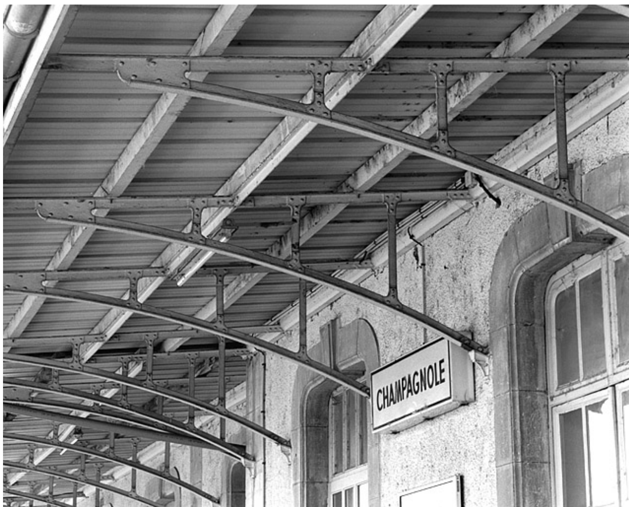
Bâtiment des voyageurs : consoles métalliques soutenant l'auvent.
