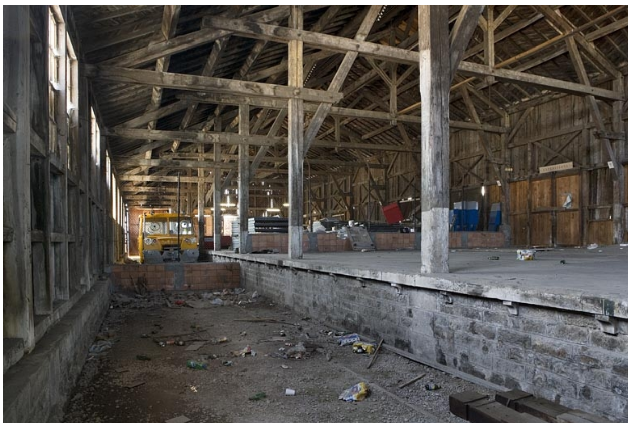
Entrepôt : intérieur, depuis l'angle nord-ouest.
