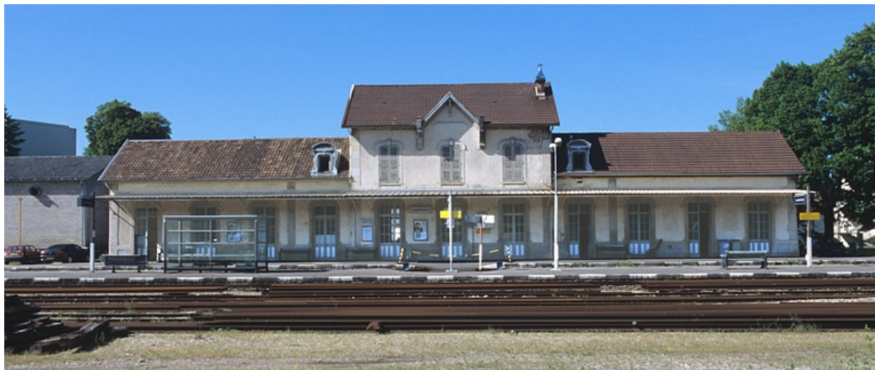
Bâtiment des voyageurs : façade postérieure.
