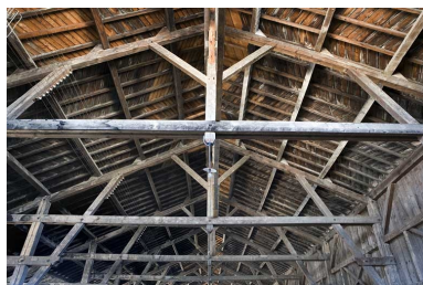
Entrepôt : charpente. Phot. Yves Sancey IVR43_20073900149NUCA
