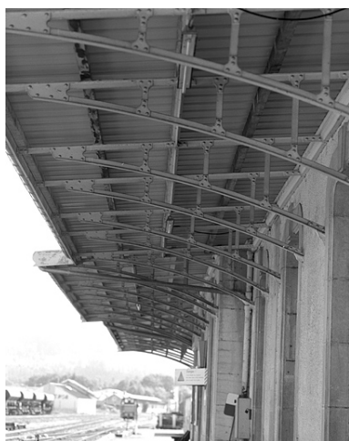
Bâtiment des voyageurs : vue d'ensemble des consoles métalliques soutenant l'auvent. Phot. Yves Sancey IVR43_20043900169X
