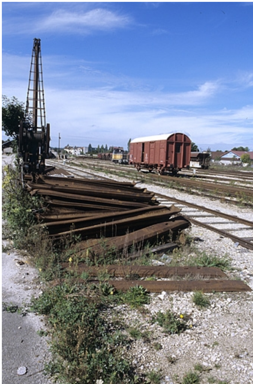
Grue, voies, wagon et traverses métalliques.
