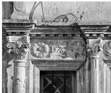
Linteau de fenêtre du rez-de-chaussée. Phot. Yves Sancey IVR43_19782500012X
