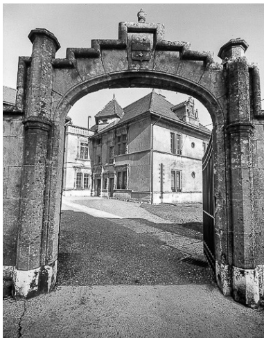
Vue d'ensemble avec le portail. Phot. Yves Sancey IVR43_19782500006V
