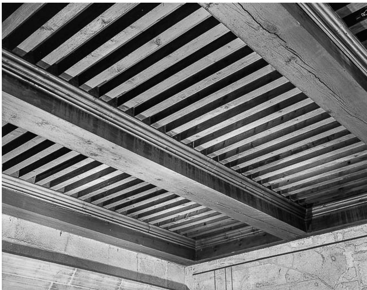
Vue du plafond.
