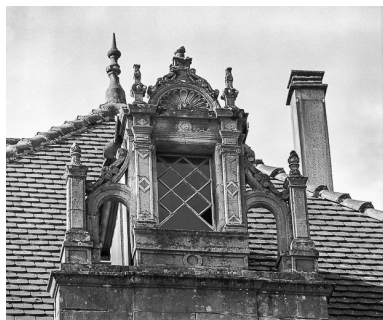
Façade latérale : lucarne. Phot. Yves Sancey IVR43_19782500021X
