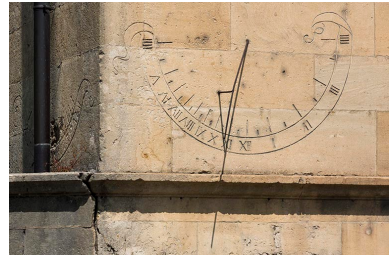
Façade sur rue : cadrans solaires. Phot. Sonia Dourlot IVR43_20182501253NUC4A
