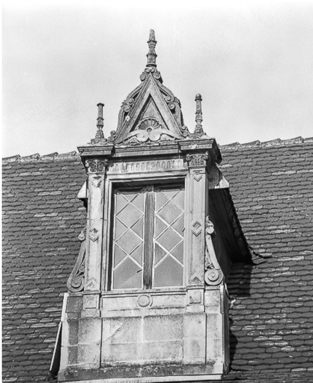
Façade sur rue, détail : lucarne.
