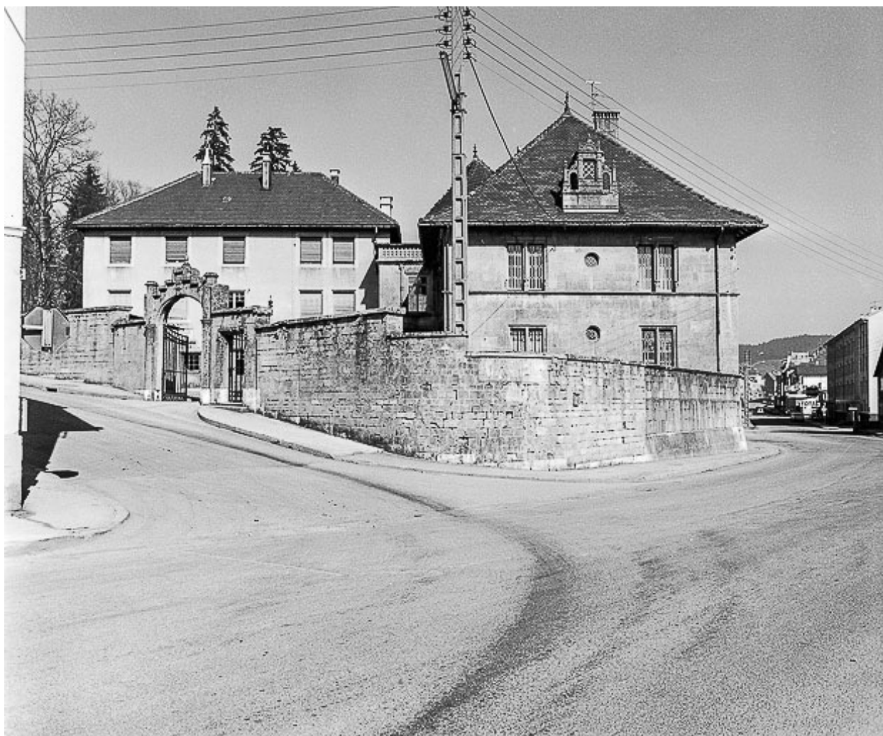
Vue d'ensemble depuis la rue, au sud-ouest.
