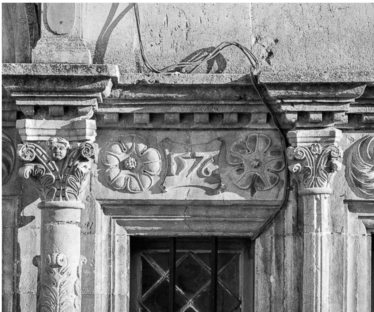
Linteau de fenêtre du rez-de-chaussée.
