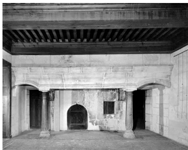
Intérieur : cheminée à manteau, le couvrement repose sur deux colonnes. Phot. Yves Sancey IVR43_19762500796V
