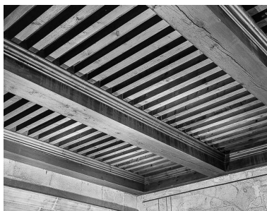
Vue du plafond. Phot. Yves Sancey IVR43_19762500798V
