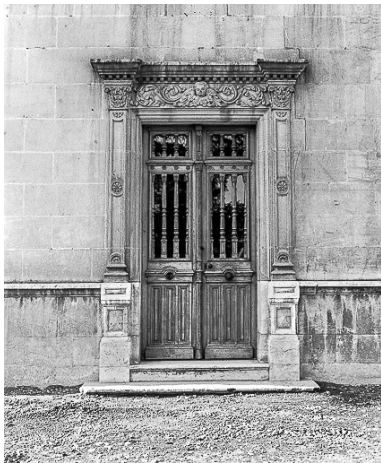
Détail : porte gauche. Phot. Yves Sancey IVR43_19782500022X
