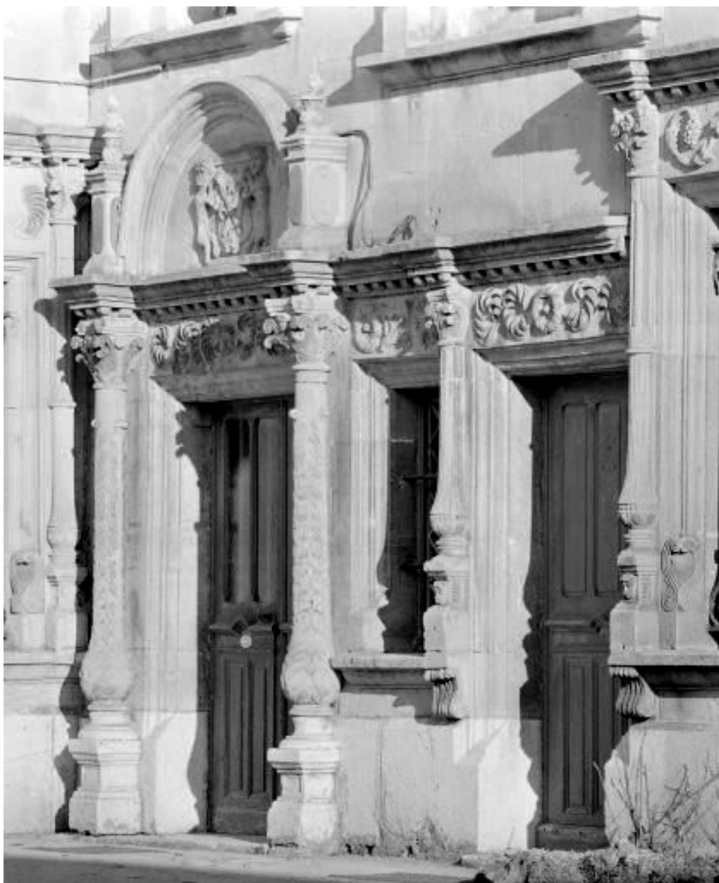
Détail de la porte d'entrée.
