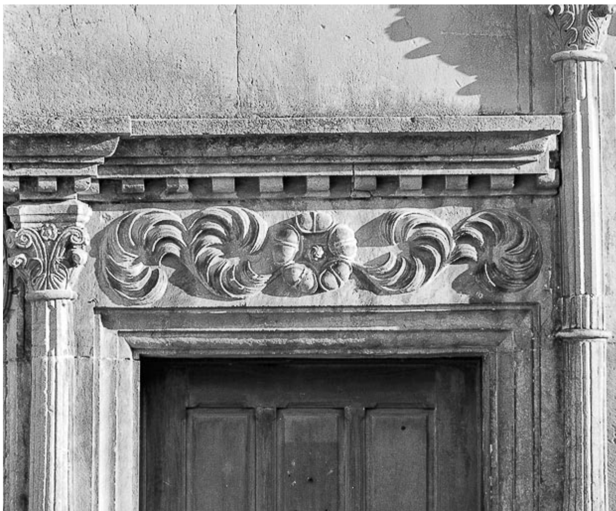
Linteau de fenêtre du rez-de-chaussée.
