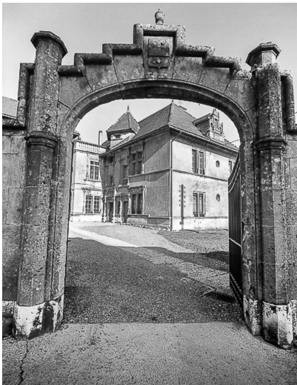
Vue d'ensemble avec le portail.
