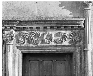
Linteau de fenêtre du rez-de-chaussée. Phot. Yves Sancey IVR43_19782500010X
