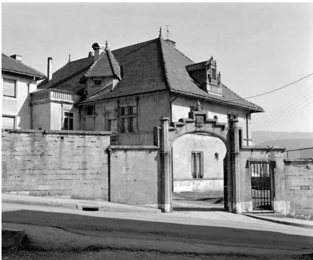
Portail d'entrée et façade sur cour.
