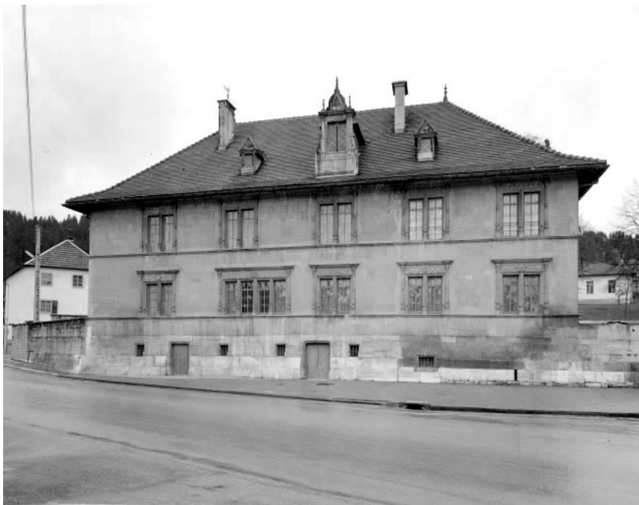
Façade sur rue : vue d'ensemble.
