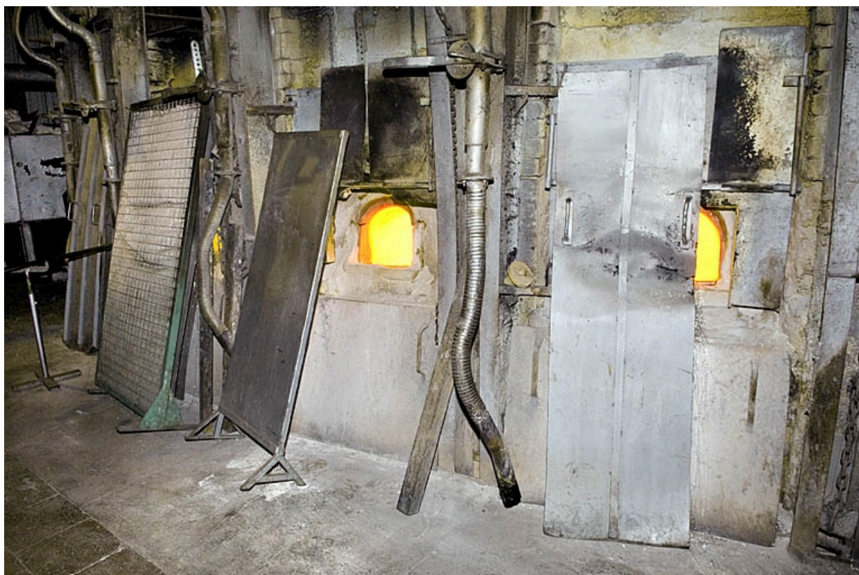
Atelier verrerie main. Four à pots.
