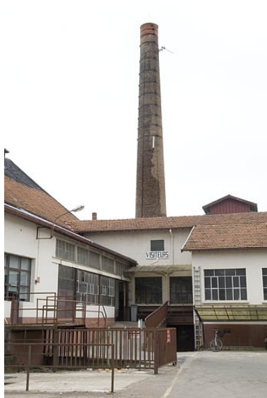
Atelier et cheminée. Phot. Jérôme Mongreville IVR43_20097000565NUC2A
