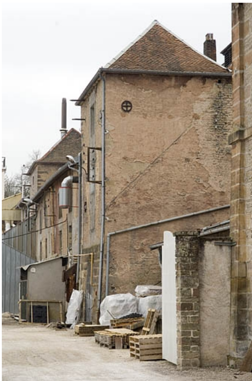
Façade postérieure de l'atelier des fours.
