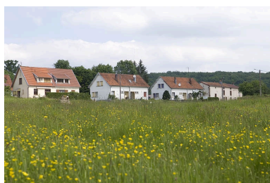
La cité ouvrière depuis le sud. Phot. Jérôme Mongreville IVR43_20097000576NUC2A
