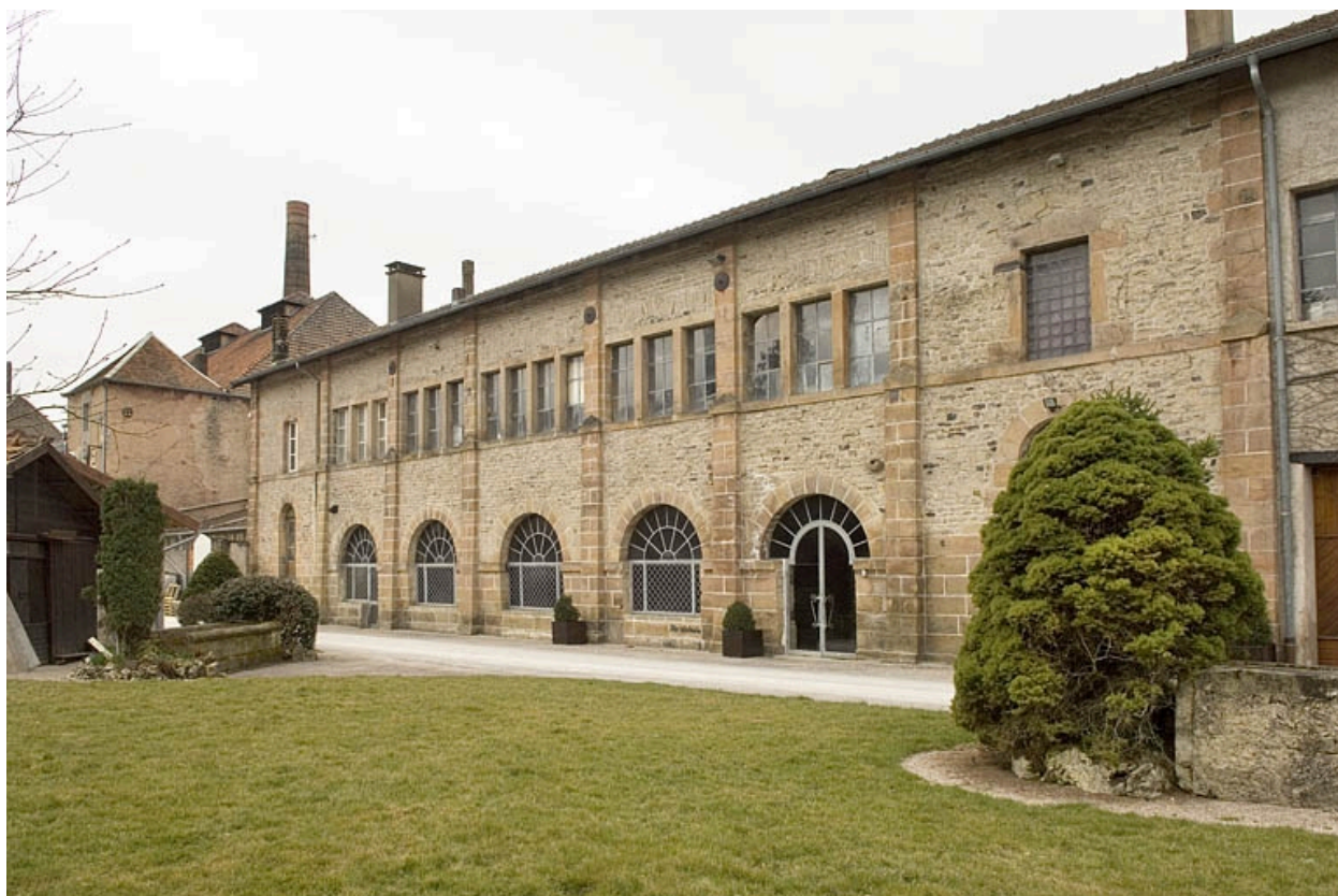
Façade est de l'ancien atelier de taillerie.
