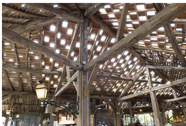
Ancien séchoir à bois. Détail de la charpente. Phot. Jérôme Mongreville IVR43_20097000783NUC2A
