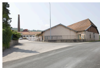
Magasins industriels à l'entrée du site. Phot. Jérôme Mongreville IVR43_20097000787NUC2A
