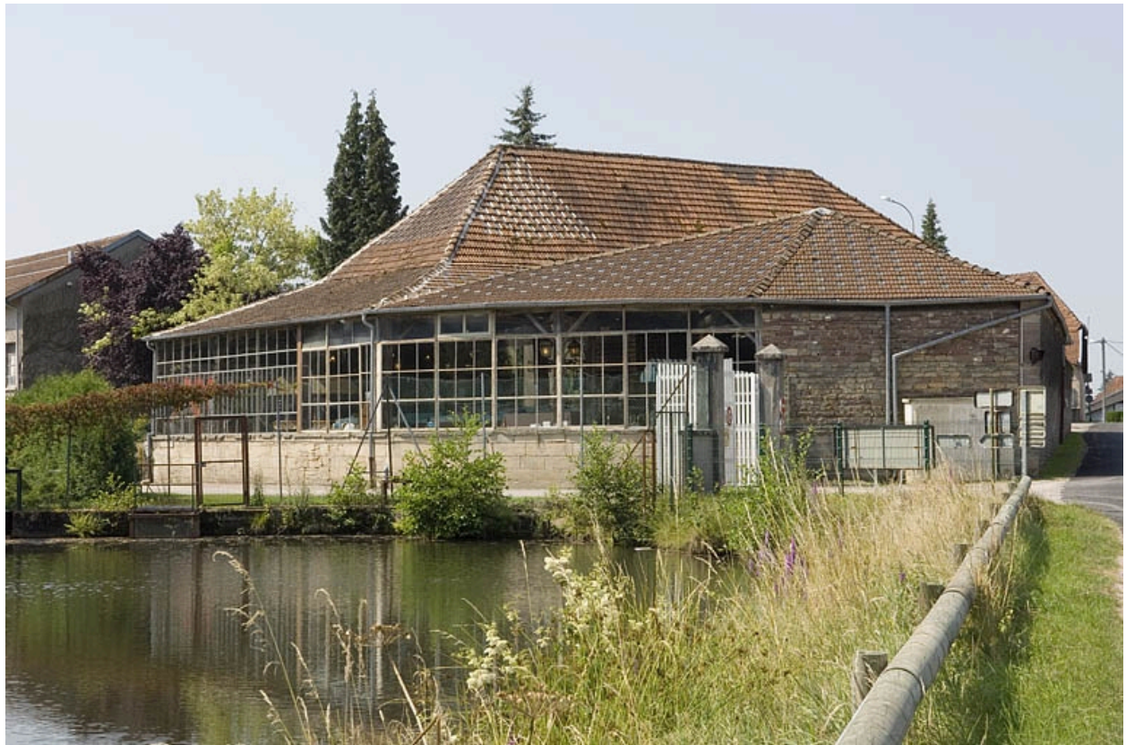
Ancien séchoir à bois depuis le nord-est.
