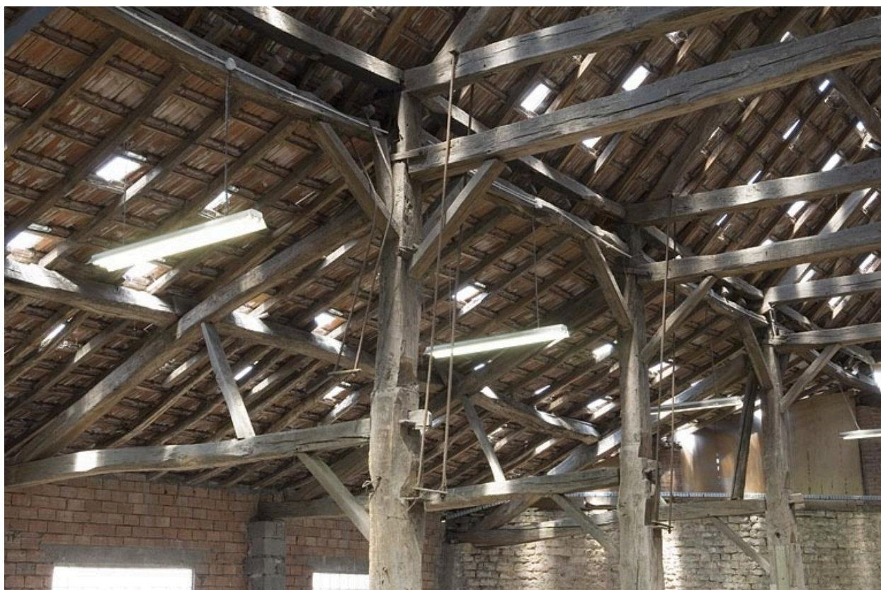
Magasin industriel. Détail de la charpente.
