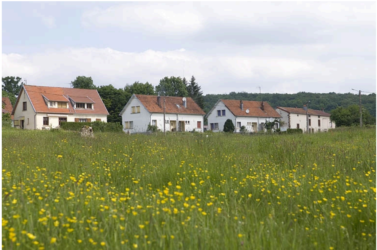
La cité ouvrière depuis le sud.
