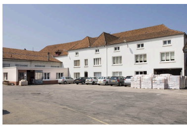
Les bureaux. Phot. Jérôme Mongreville IVR43_20097000776NUC2A
