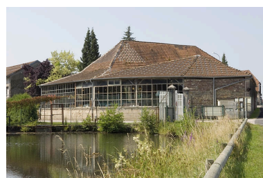
Ancien séchoir à bois depuis le nord-est. Phot. Jérôme Mongreville IVR43_20097000774NUC2A
