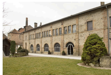
Façade est de l'ancien atelier de taillerie. Phot. Jérôme Mongreville IVR43_20097000560NUC2A
