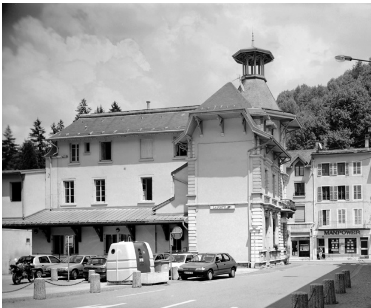
Façade postérieure, depuis la rue Lamartine (sud-ouest).
