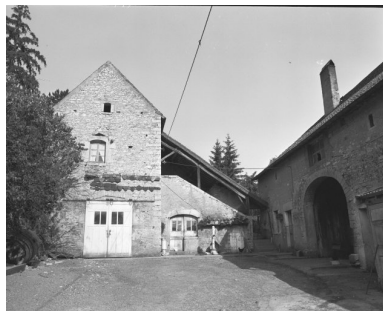
Ensemble des bâtiments : façades sur cour.
