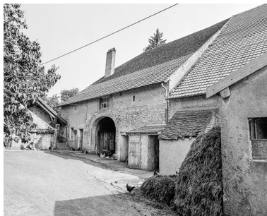
Bâtiment de droite : façade antérieure.
