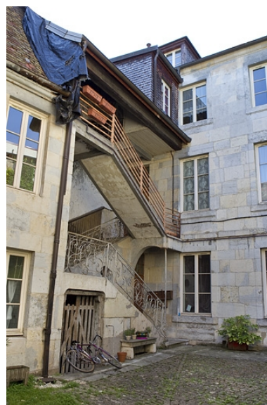
Vue d'ensemble de l'escalier à cage ouverte.
