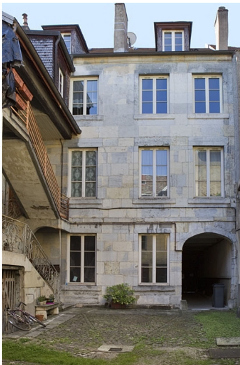
Façade postérieure du logis principal.
