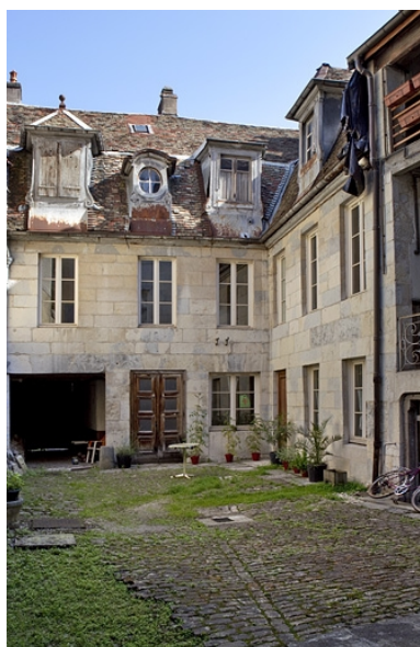
Façade antérieure du premier logis secondaire.
