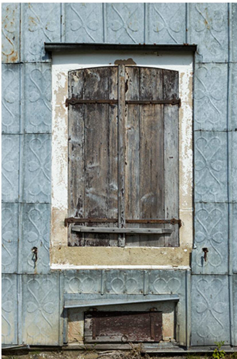
Maison d'éclusier de Corre : détail de deux baies de rez-de-chaussée et de l'essentage de tôle de la façade sud.
