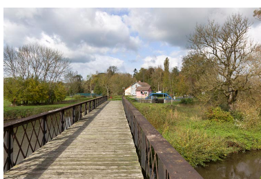
Détail de la passerelle enjambant le Coney.
