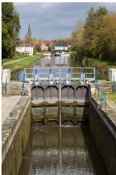
Vue de l'écluse vers l'amont. Phot. Sonia Dourlot IVR43_20157000133NUC2A
