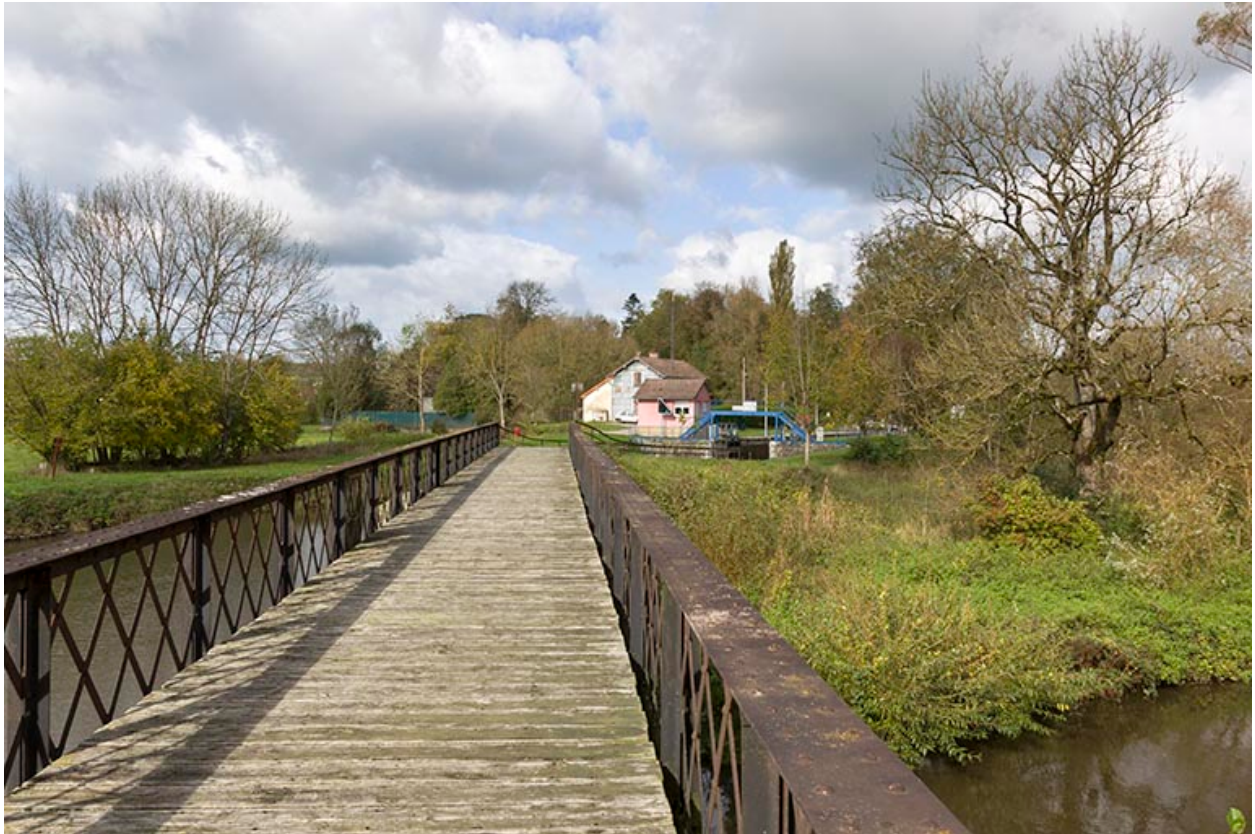
Détail de la passerelle enjambant le Coney.
