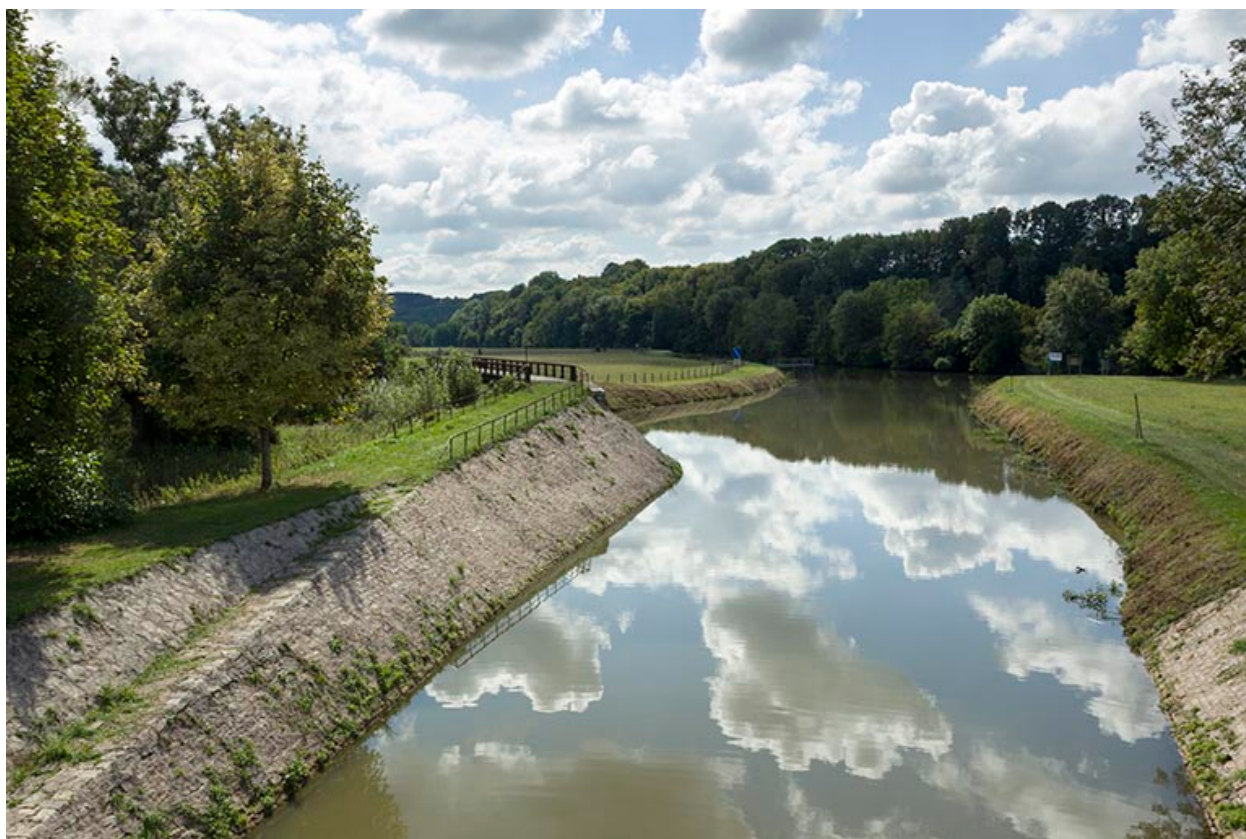
Depuis l'amont, vue de la confluence du Coney et du canal, en aval de Corre.
