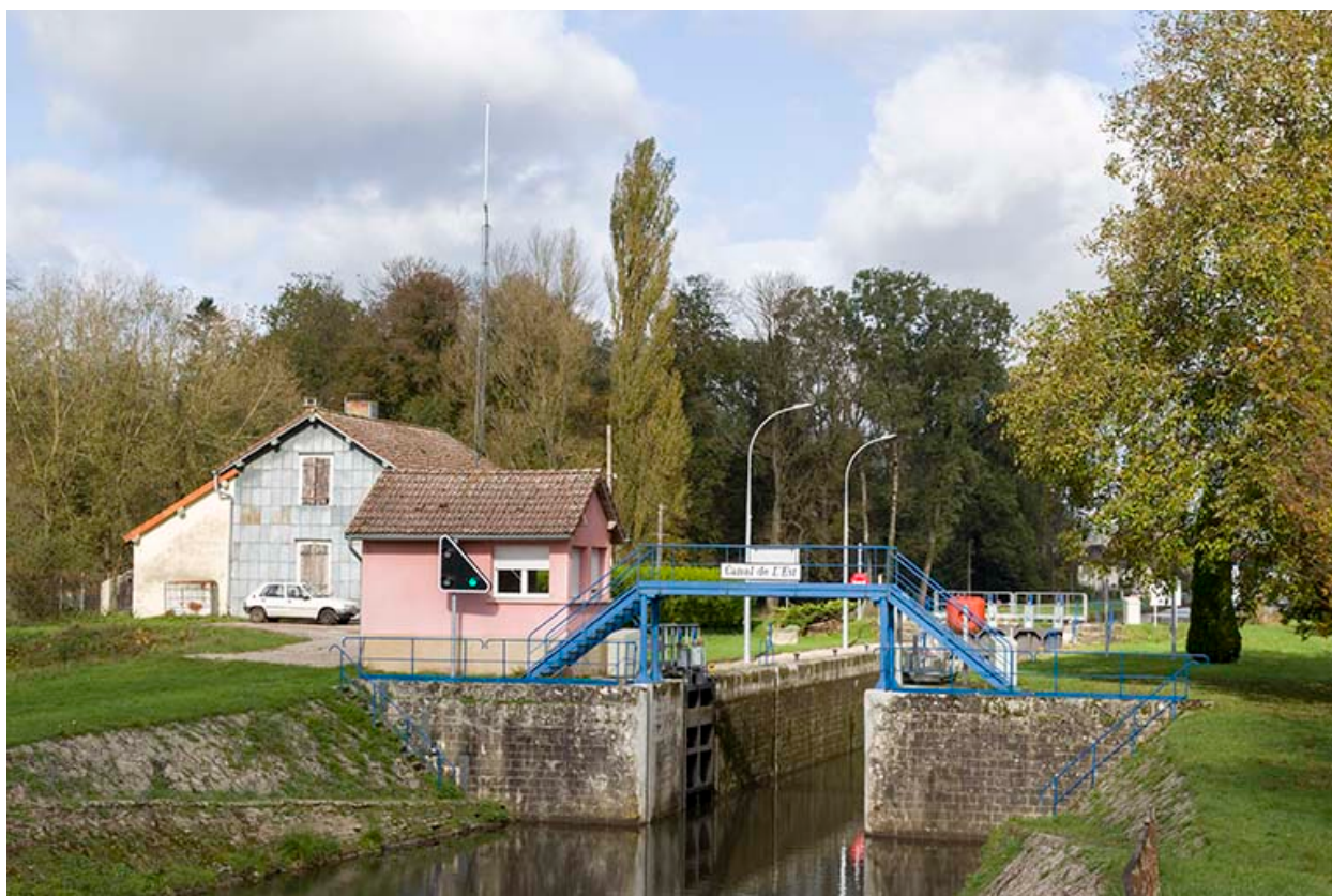
Vue du site d'écluse depuis l'aval.
