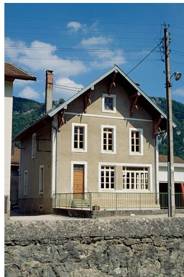
Façade antérieure. Phot. Laurent Poupard IVR43_19903900439ZA
