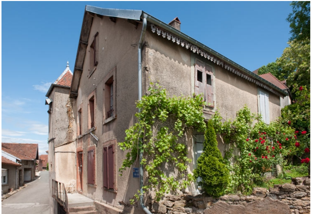
Façade antérieure et façade latérale droite.
