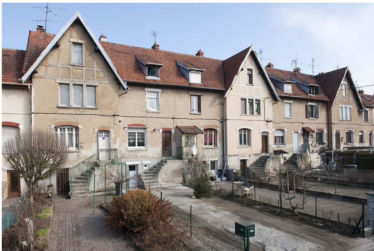
Cité du Maroc. Travées centrales.
