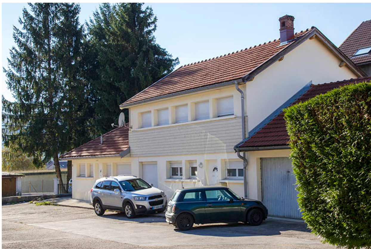
Bâtiment sur cour, de trois quarts droite.
