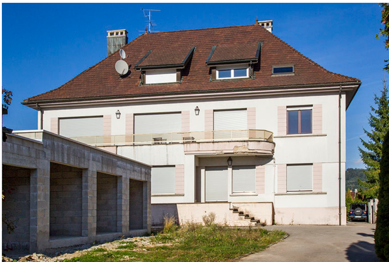
Maison : façade côté usine.
