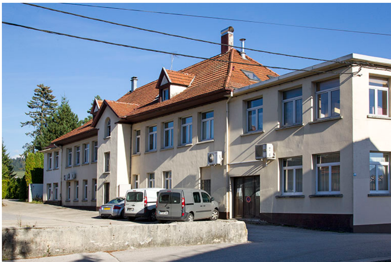
Usine : façade postérieure, de trois quarts droite.
