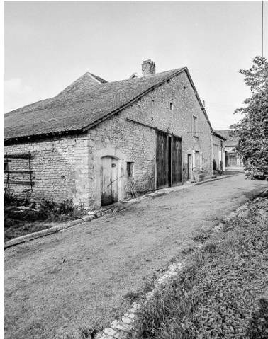
Façades antérieure et latérale gauche.
