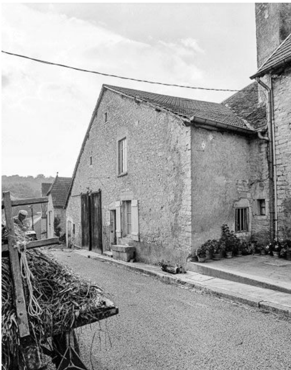
Façades antérieure et latérale droite.
