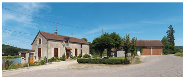
Vue d'ensemble de la maison de garde. Phot. Thierry Kuntz IVR26_20122102046NUC4AQ
