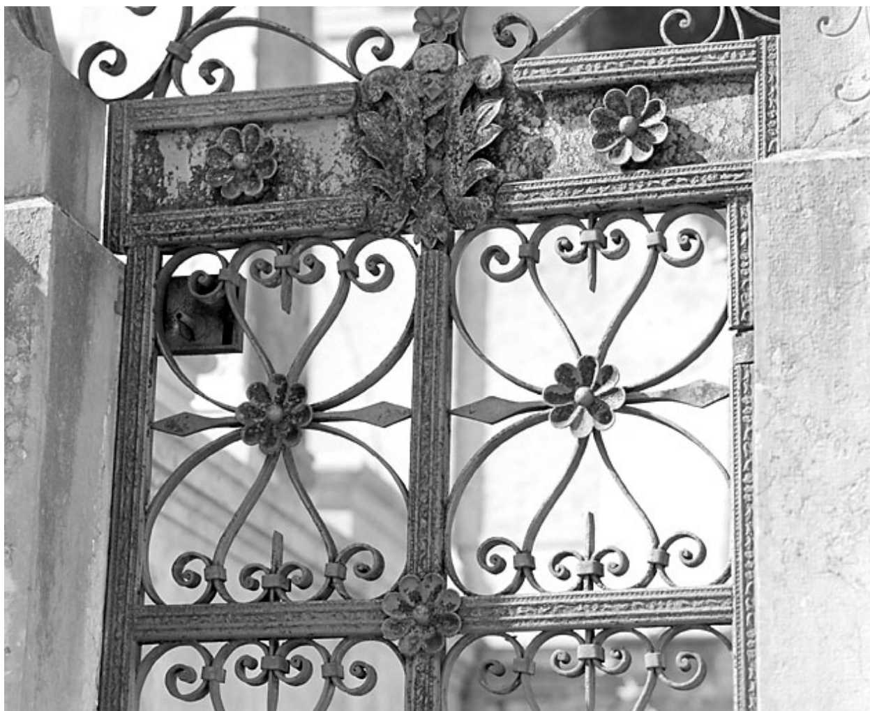
Grille : détail de la partie basse.
