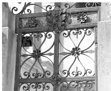
Grille : détail de la partie basse.
