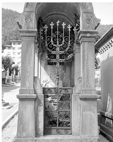
Façade antérieure : la grille.
