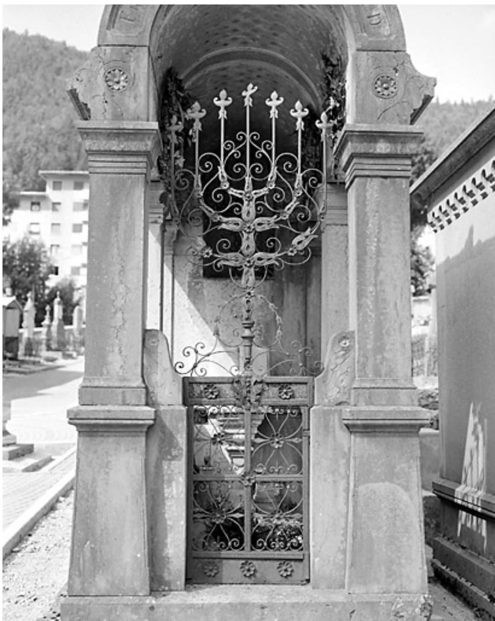
Façade antérieure : la grille.
