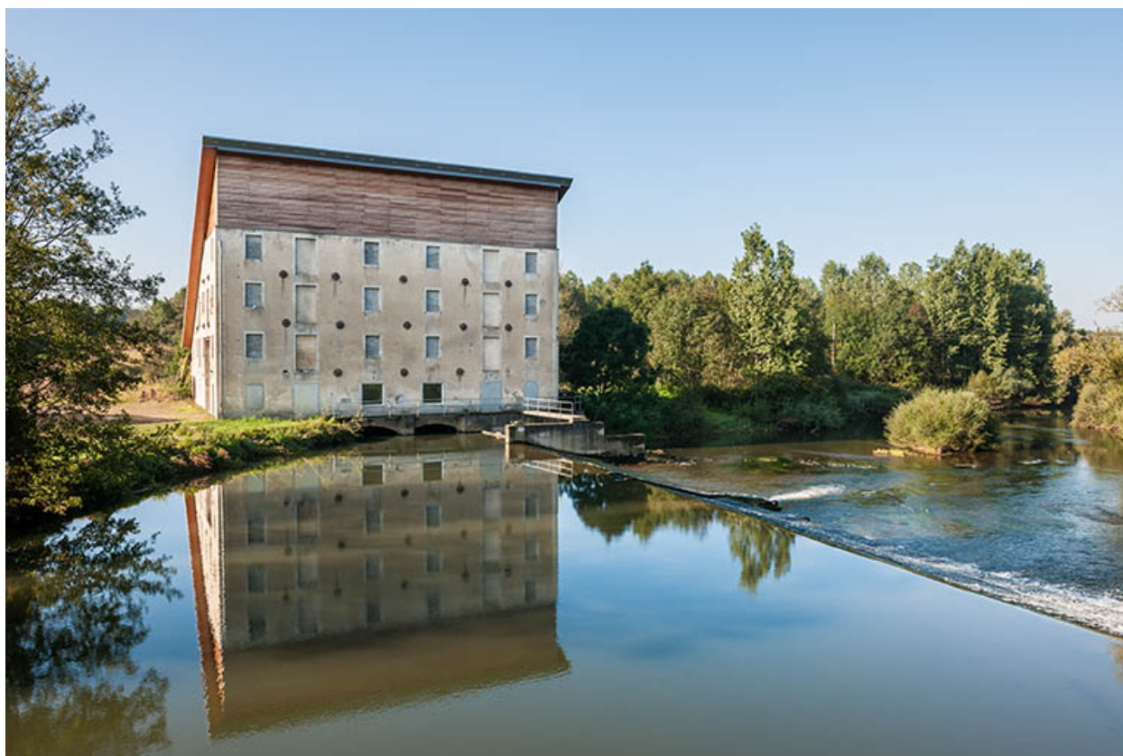
Vue d'ensemble depuis le pont.
