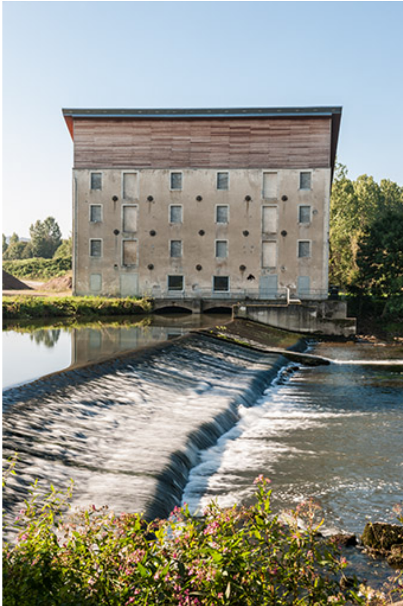
Façade nord depuis l'extrémité du barrage.
