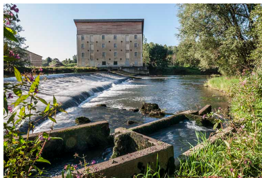
vue d'ensemble depuis le nord. Phot. Jérôme Mongreville IVR43_20142501099NUC4A
