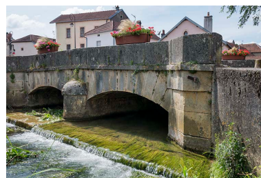
Face sud, vue depuis l'est.
