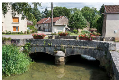
Face nord, vue depuis le nord.
