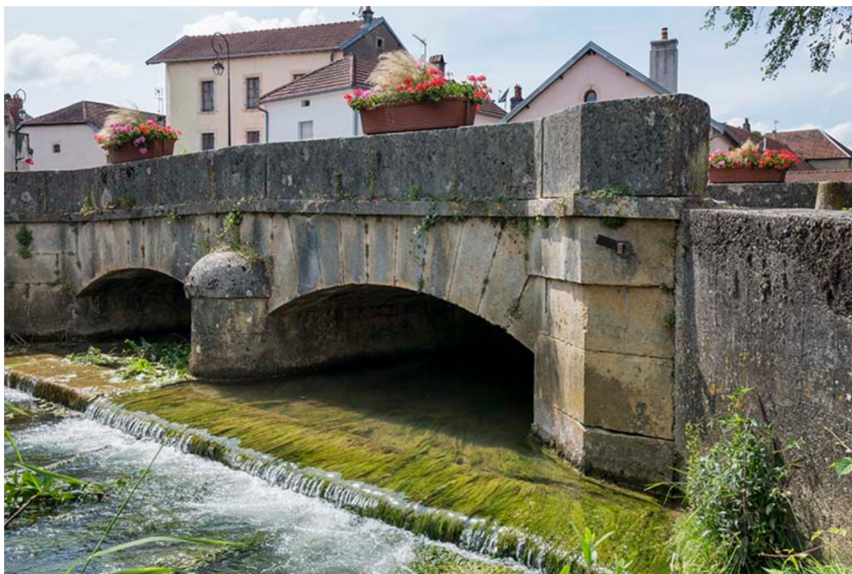
Face sud, vue depuis l'est.
