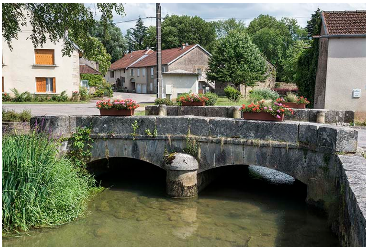
Face nord, vue depuis le nord.
