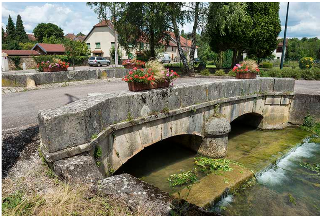
Face sud, vue depuis l'ouest.
