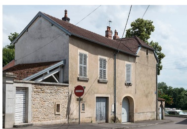
L'édifice depuis la rue Grande. Phot. Jérôme Mongreville IVR43_20187000291NUC4A
