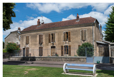
La façade antérieure. Phot. Jérôme Mongreville IVR43_20187000290NUC4A
