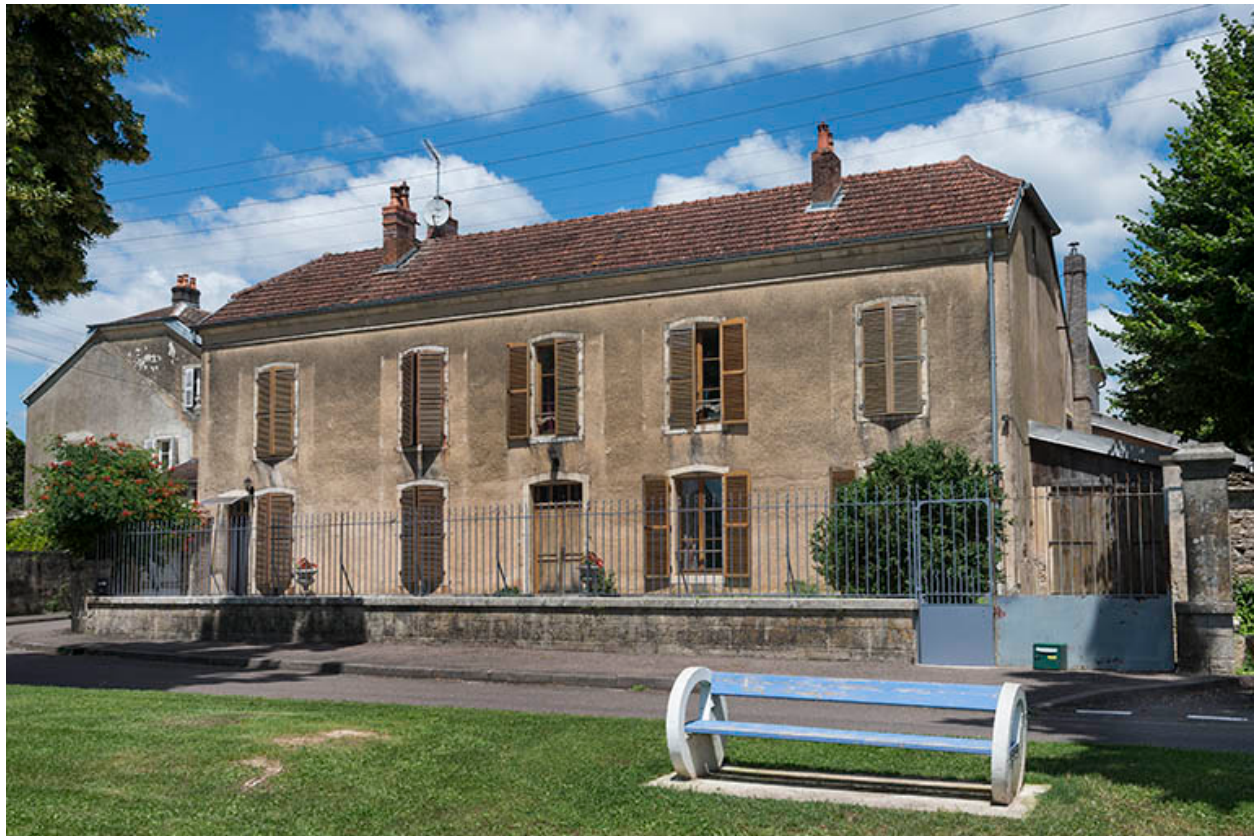
La façade antérieure.
