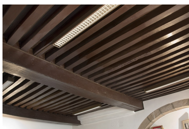
Intérieur, rez-de-chaussée : détail d'un plafond à la française. Phot. Yves Sancey
