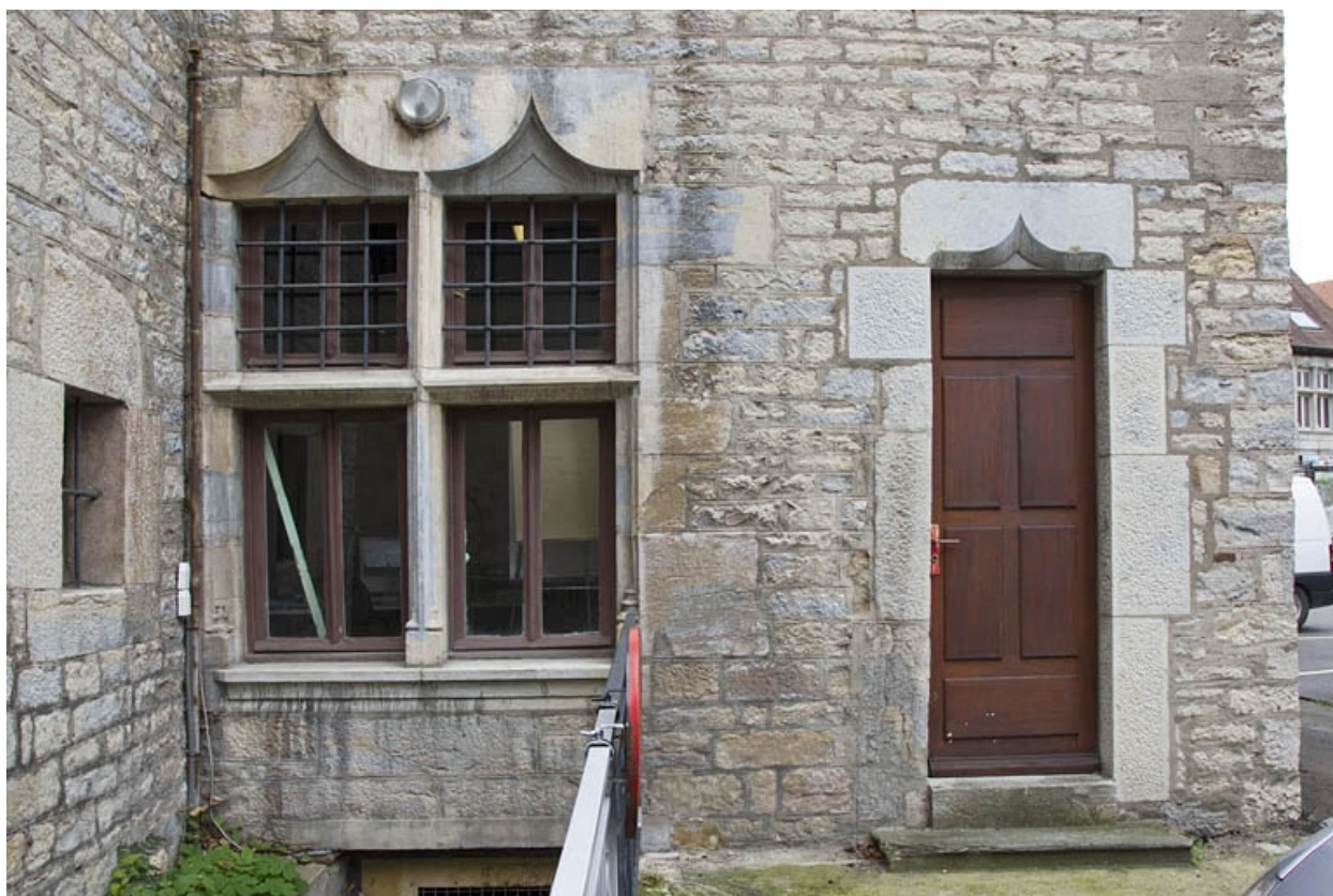
Façade postérieure : détail du rez-de-chaussée.
