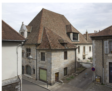
Façade rue Rivotte, de trois quarts droit.
