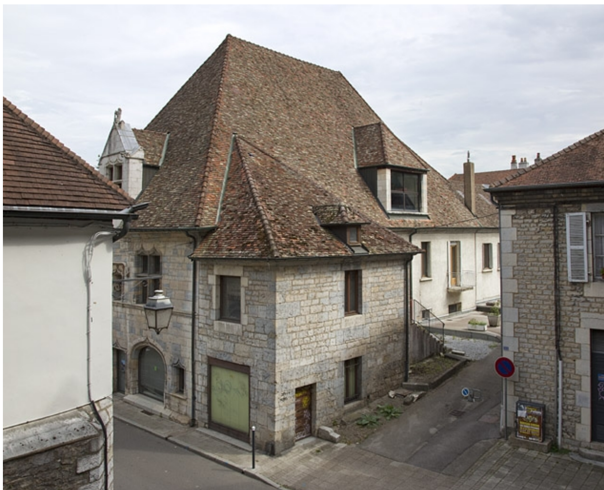
Façade rue Rivotte, de trois quarts droit.
