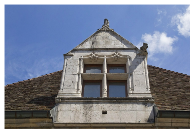
Façade antérieure, lucarne : vue d'ensemble.
