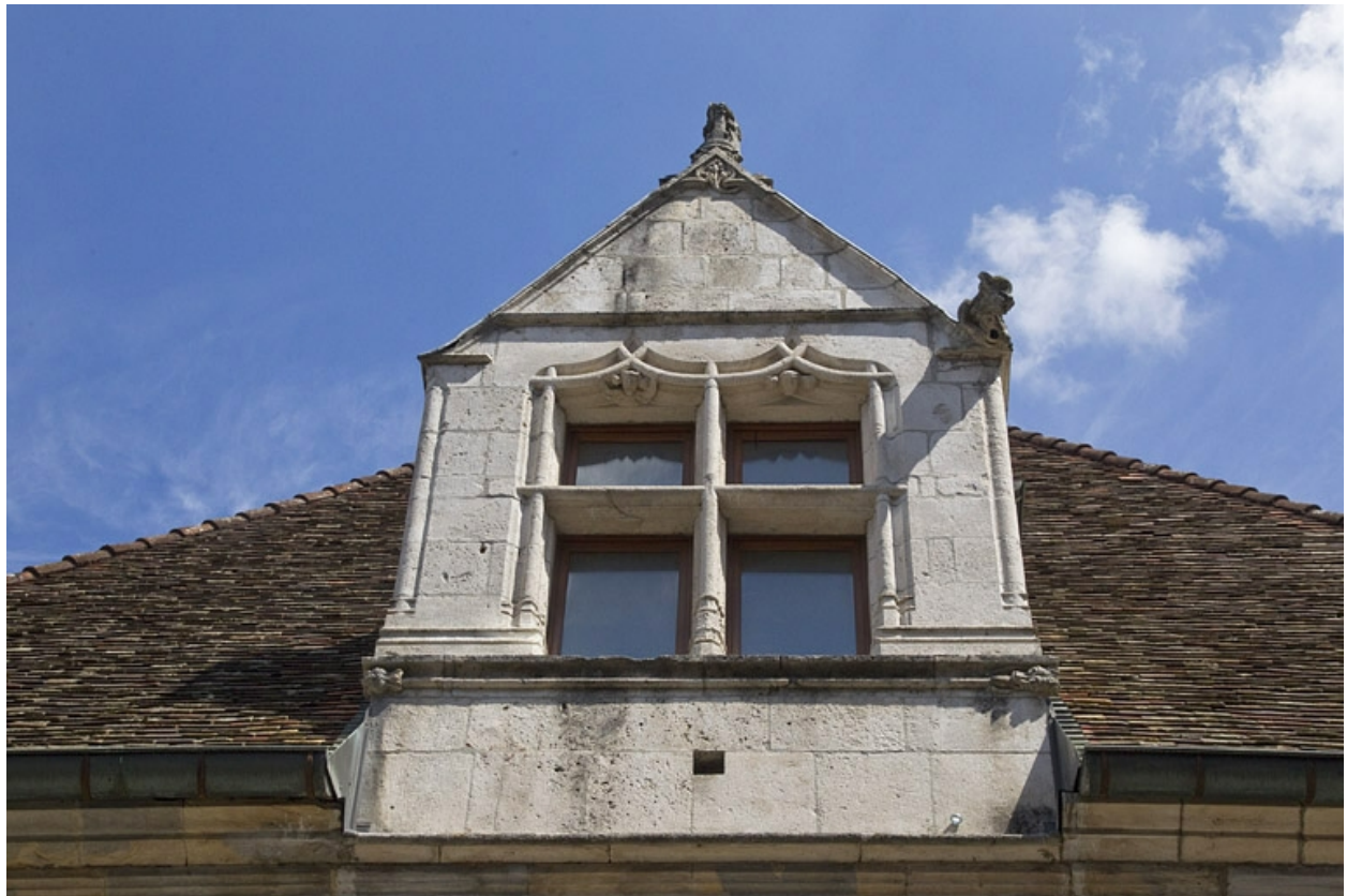
Façade antérieure, lucarne : vue d'ensemble.
