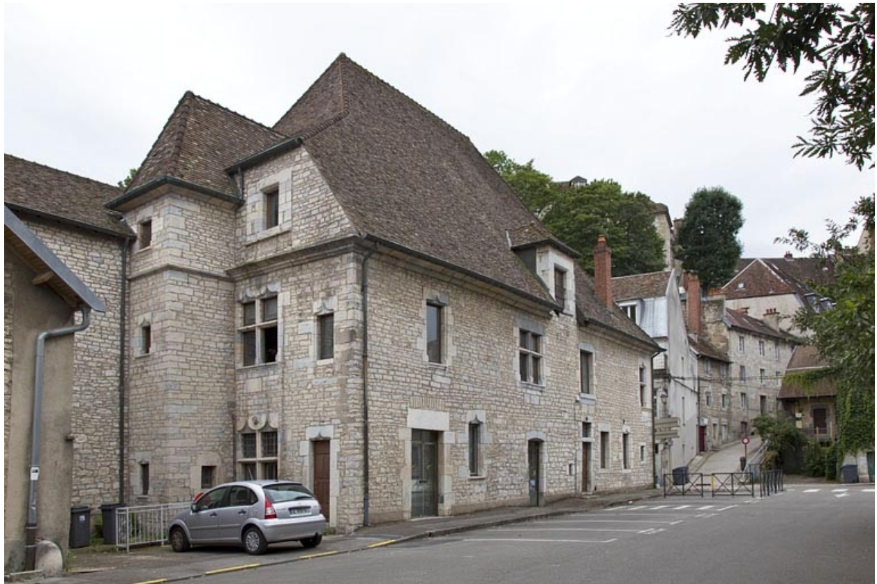
Façade latérale droite : de trois quarts gauche.
