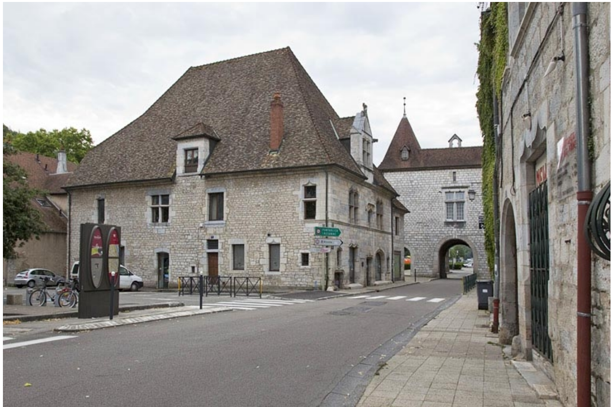
Vue d'ensemble éloignée, de trois quarts gauche.
