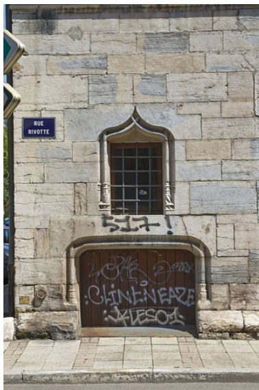
Façade antérieure, vue de l'entrée de cave.
