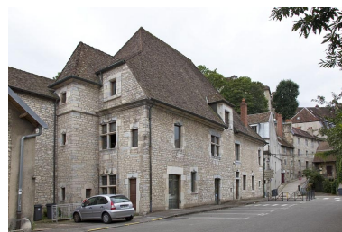
Façade latérale droite : de trois quarts gauche.
