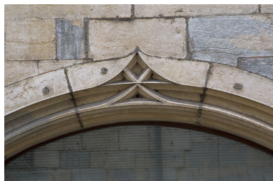
Façade antérieure : détail de l'arc en accolade de l'ancienne arcade boutiquière.
