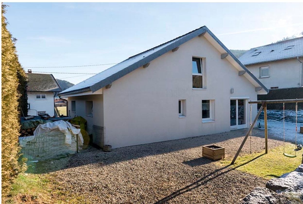
Façades postérieure et latérale droite.
