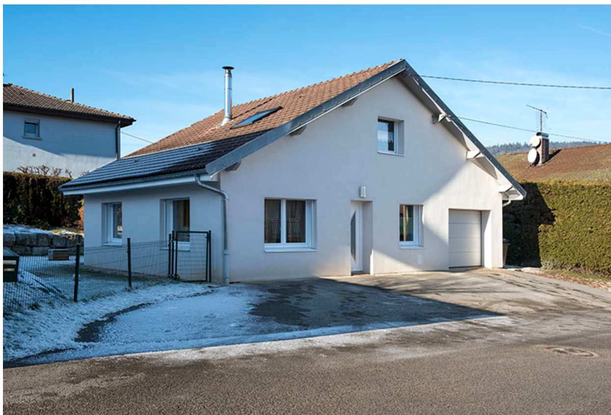
Façades antérieure et latérale gauche.
