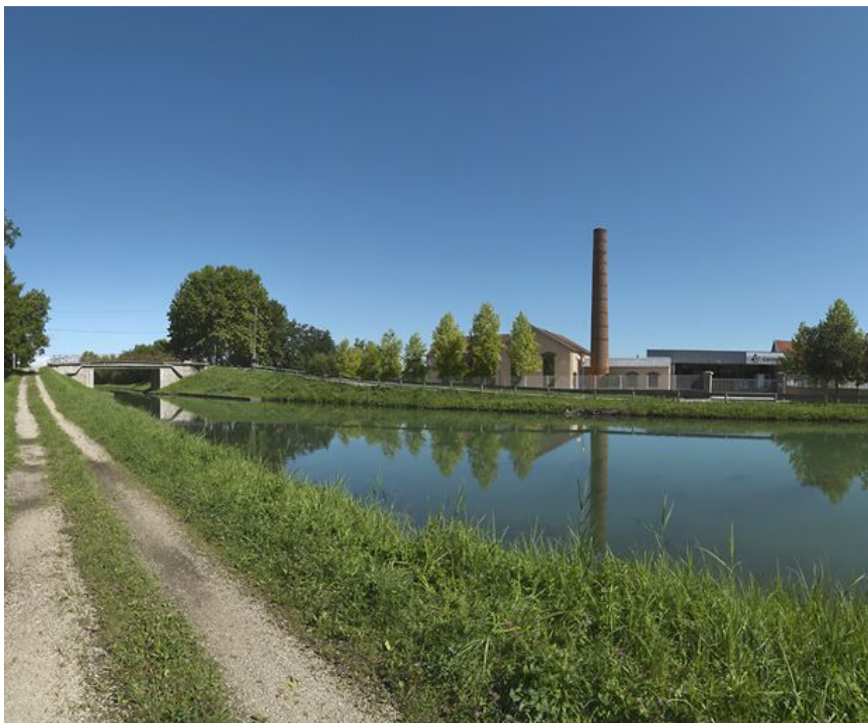
Vue d'ensemble du site industriel.
