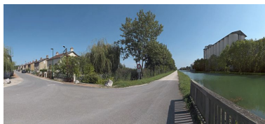
Détail des logements dépendants du site industriel. Phot. Thierry Kuntz IVR26_20112103290NUC4AQ
