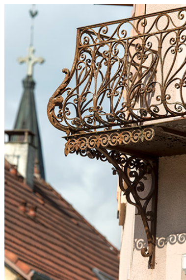
Balcon sur le pan coupé (détail). Phot. Sonia Dourlot IVR43_20152500750NUC2A
