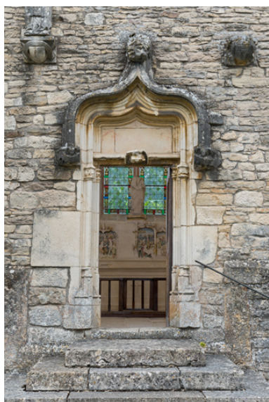
Porte en façade occidentale (vantail ouvert). Phot. Pierre-Marie Barbe-Richaud IVR26_20237100225NUC4A
