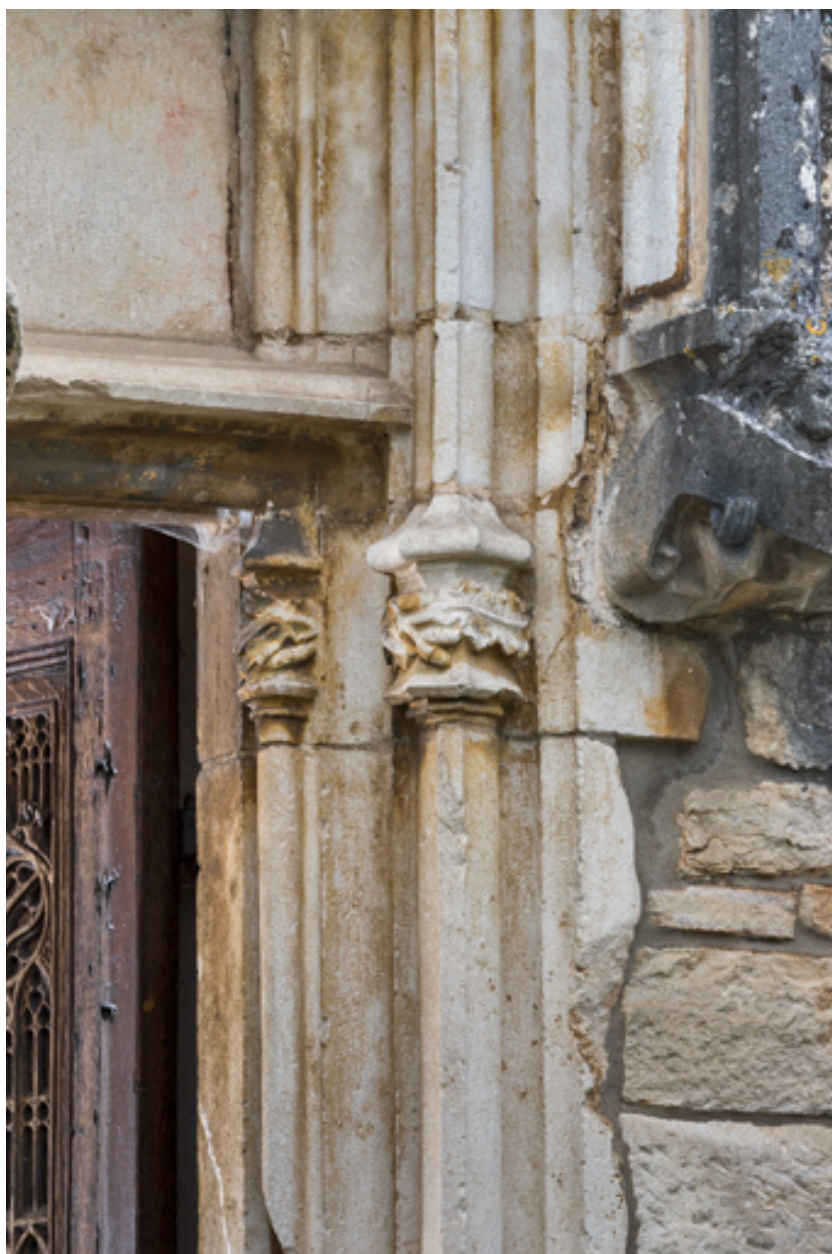
Piédroit, détail de la partie supérieure, droite.
