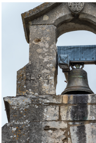
Clocher-mur, détail : date (1484). Phot. Pierre-Marie Barbe-Richaud IVR26_20237100237NUC4A
