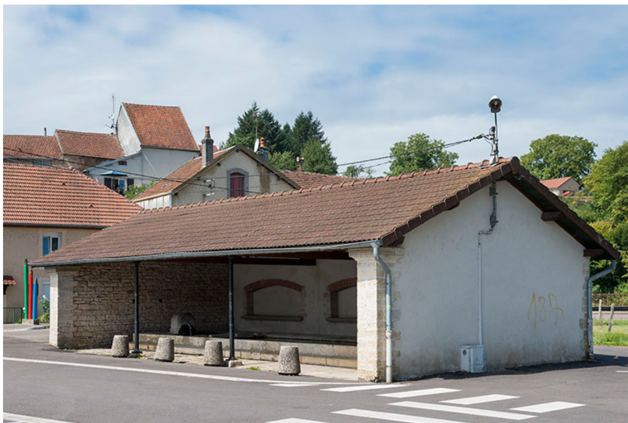
Le lavoir couvert, rue de Remaucourt.
