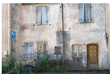
Logements ouvriers. Phot. Jérôme Mongreville IVR43_20177001080NUC4A
