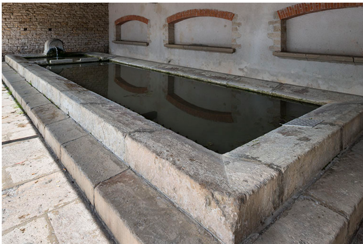
Bassin du lavoir.
