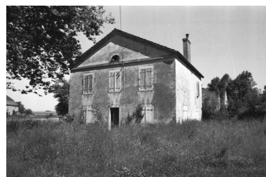
Logement patronal. Vue de trois quarts en 1981. Phot. Bernard Lardière IVR43_19817000171Z
