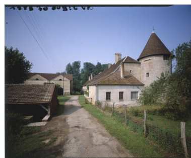
Vue d'ensemble depuis l'entrée en 1989.
