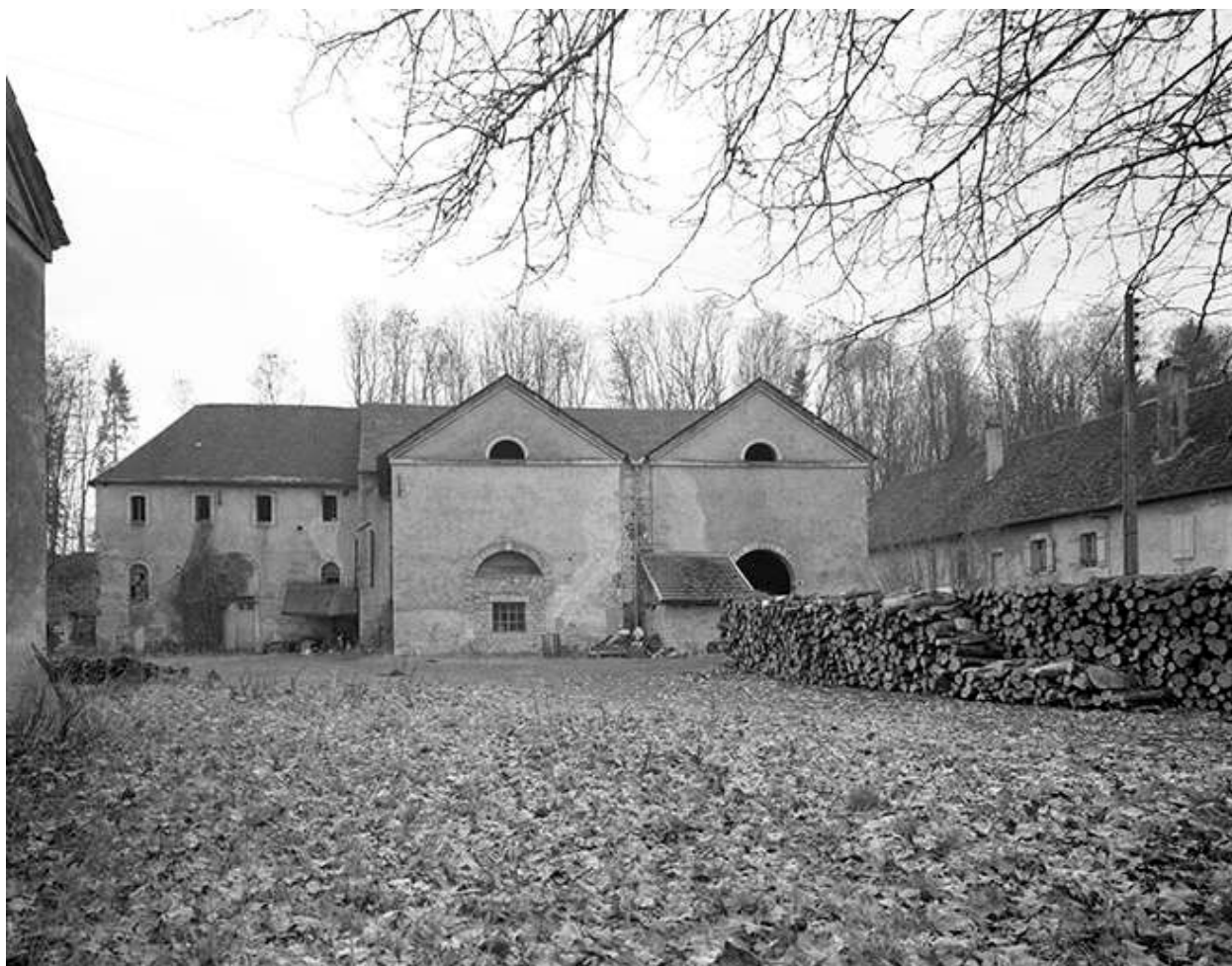
Le haut-fourneau vue de face en 1985.
