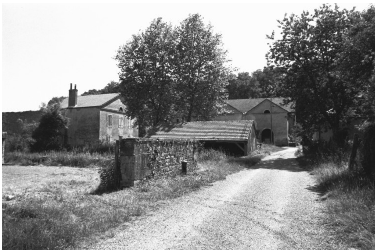
Vue d'ensemble depuis le chemin d'accès en 1981.
