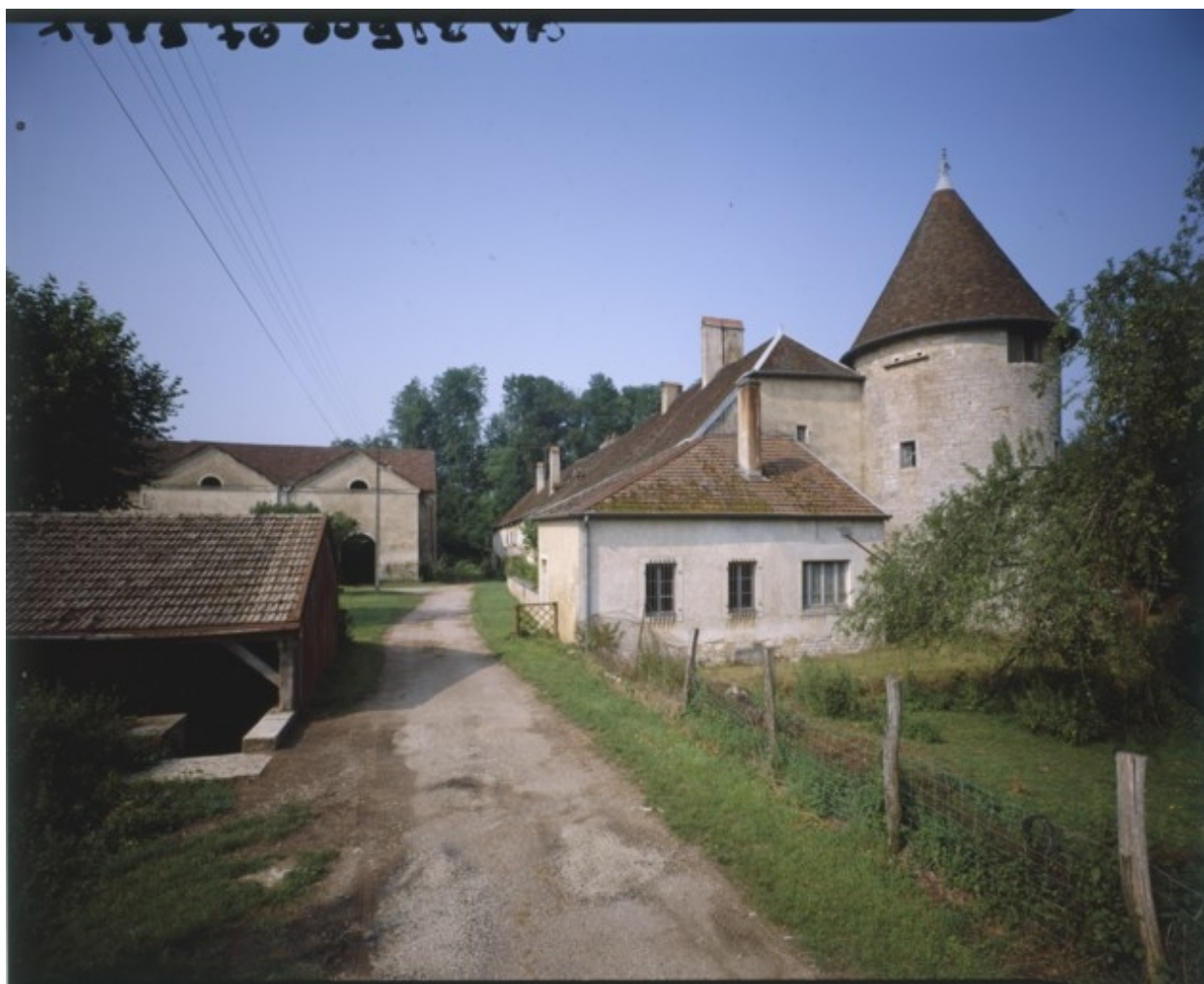
Vue d'ensemble depuis l'entrée en 1989.
