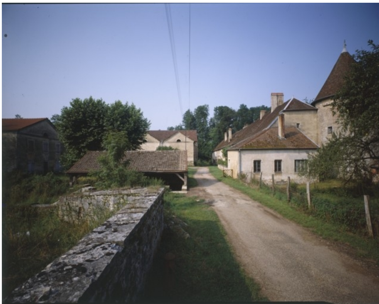
Vue d'ensemble depuis le chemin d'accès en 1989.
