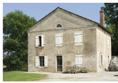
Logement patronal vu de face. Phot. Jérôme Mongreville IVR43_20087000910NUC2A
