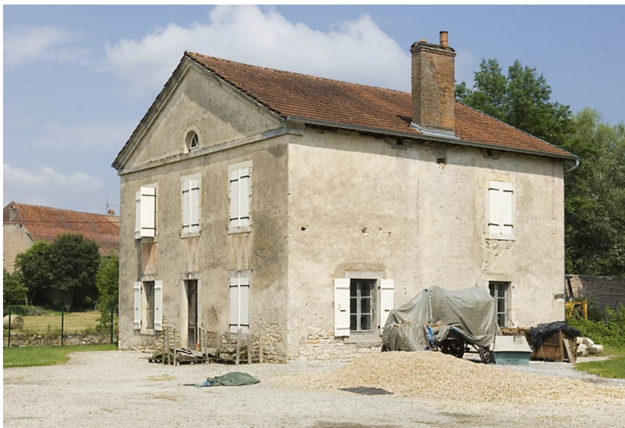
Logement patronal vu de trois quarts.
