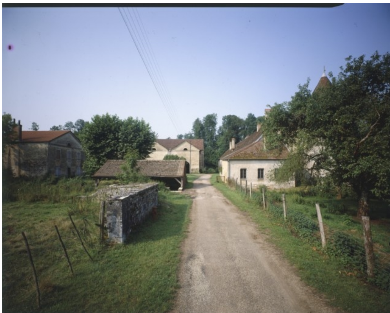
Vue d'ensemble depuis le chemin d'accès en 1989.
