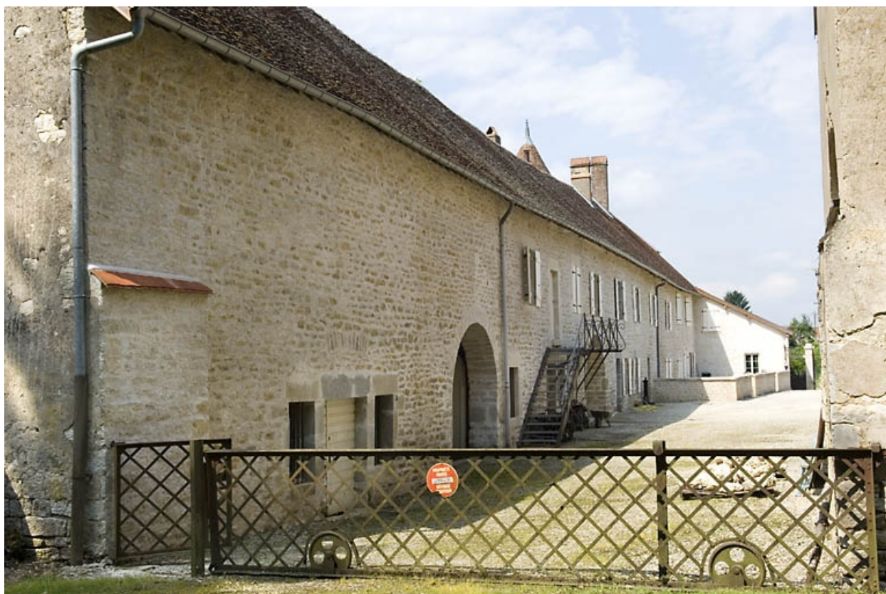
Logement ouvrier depuis le sud.
