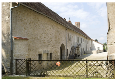
Logement ouvrier depuis le sud.
