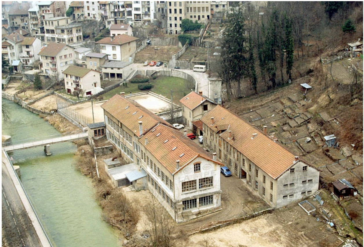
Usine de tabletterie dite usine de la coopérative La Pipe, Saint-Claude (23 rue Saint-Oyend).
