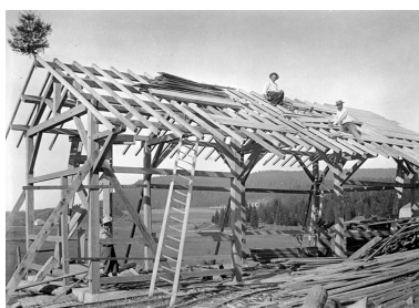
Scierie Paget puis Girardet, Saint-Laurent-en-Grandvaux (la Savine) : construction du bâtiment de la parqueteuse, 1904. Phot. Jérôme Mongreville, Phot. Luc Paget IVR43_19913900151X
