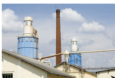
Scierie et menuiserie de la Compagnie Générale de Scierie et Menuiserie, Jussey. Phot. Jérôme Mongreville IVR43_20097000750NUC2A
