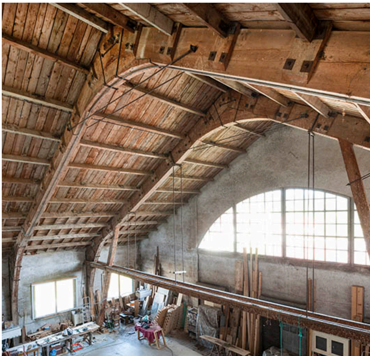
Scierie communale, Remoray-Boujeons : rare charpente en lamellée-boulonnée.
