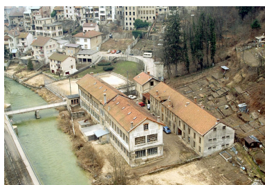
Usine de tabletterie dite usine de la coopérative La Pipe, Saint-Claude (23 rue Saint-Oyend).
