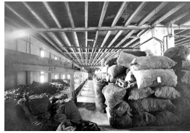
Usine de tabletterie (usine de pipes) Chapuis-Comoy, Saint-Claude (2-4 rue des Etapes) : [intérieur du séchoir à ébauchons (3e étage)], [1926]. Phot. Jérôme Mongreville, Autr. Adrien Comoy IVR43_19923900143X
