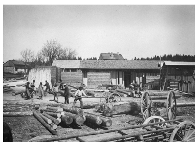
Scierie Paget puis Girardet, Saint-Laurent-en-Grandvaux (la Savine) : St Laurent. La scierie (chantier devant l'usine), 1898. Phot. Jérôme Mongreville, Phot. Luc Paget IVR43_19913900149X
