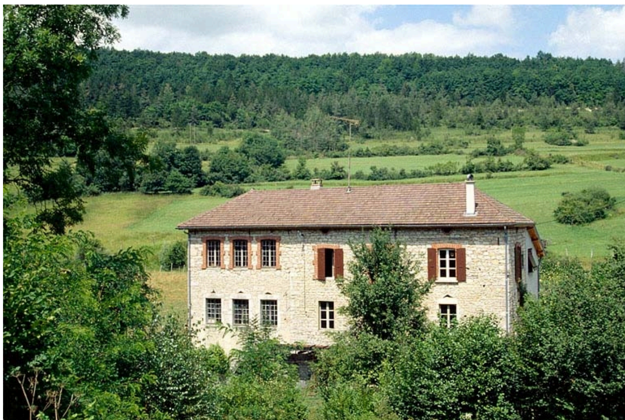
Usine de tabletterie (tournerie) Mathon, Fétigny.
