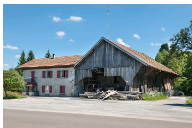
Scierie Thiébaud, Labergement-Sainte-Marie. Phot. Jérôme Mongreville IVR43_20162501169NUC4A
