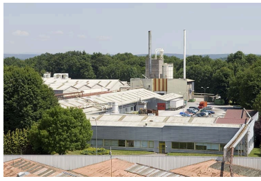
Usine liée au travail du bois (saboterie) et scierie, puis usine de meubles Parisot, Saint-Loup-sur-Semouse (15 avenue Jacques Parisot). Phot. Jérôme Mongreville IVR43_20097000464NUC2A
