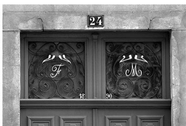
Usine de tabletterie (usine de pipes) Flavien Mandrillon et Cie, Saint-Claude (22-25 avenue de la Gare) : châssis de tympan de l'entrée du n° 24. Phot. Jérôme Mongreville IVR43_19923900720X
