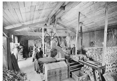
Usine de tabletterie (tournerie) de la coopérative la Tournerie ouvrière, Lavans-lès-Saint-Claude (8 rue de la Cueilie) : La Tournerie ouvrière (détaillage des bois), Société coopérative à Lavans-St-Claude, début des années 1920. Phot. Jérôme Mongreville IVR43_19923900277X
