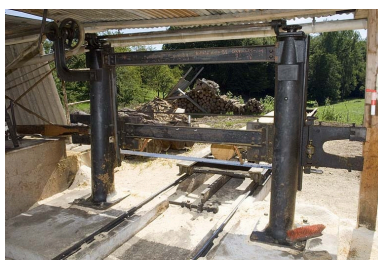
Moulin à farine puis scierie, Aillevillers-et-Lyaumont (hameau de la Louvière) : châssis de scie monolame horizontale. Phot. Jérôme Mongreville IVR43_20067000771NUCA
