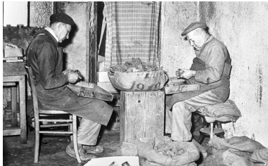
Usine de tabletterie (usine de pipes) Grappin Fils, Saint-Claude (3-5 passage de la Cheneau) : [triage des ébauchons], [3e quart 20e siècle, années 1960] Phot. Jérôme Mongreville IVR43_19923900097X
