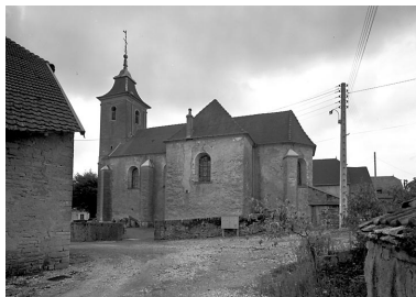
Façade latérale droite. Phot. Yves Sancey IVR43_19767000594V
