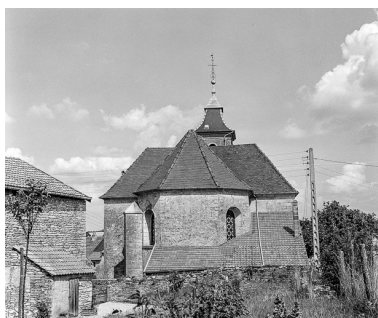
Choeur et toit de la sacristie. Phot. Yves Sancey IVR43_19767000596X
