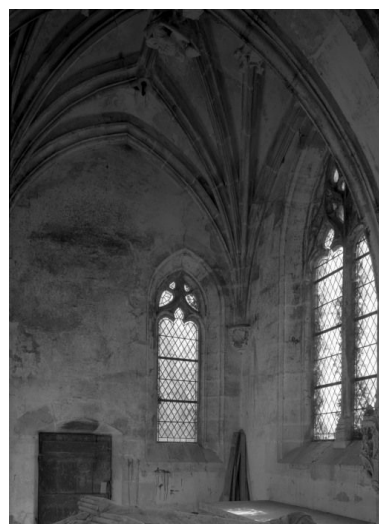
Chapelle de l'ancien château : chapelle gauche. Phot. Michel Thierry IVR26_19872100316V
