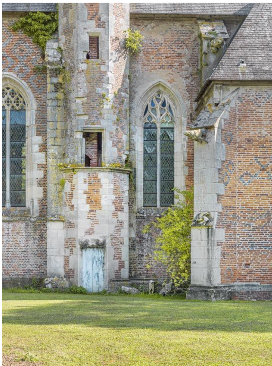
Porte de la tourelle d'escalier.
