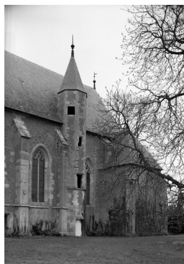
Chapelle de l'ancien château, élévation droite. Phot. Michel Thierry IVR26_19872100264V
