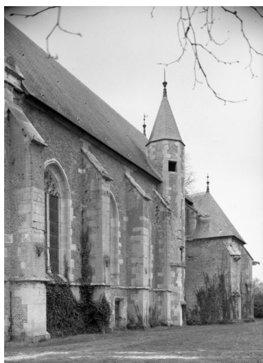
Chapelle de l'ancien château, élévation droite. Phot. Michel Thierry IVR26_19872100263V
