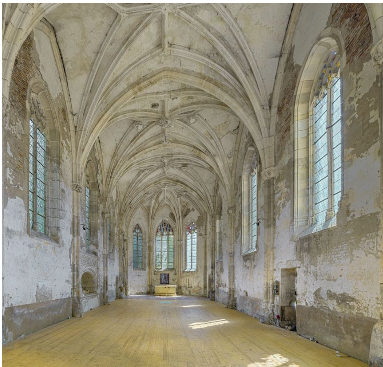
Intérieur de la chapelle, depuis l'entrée.
