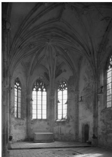
Chapelle de l'ancien château : choeur, vue de trois-quarts droit. Phot. Michel Thierry IVR26_19872100311V
