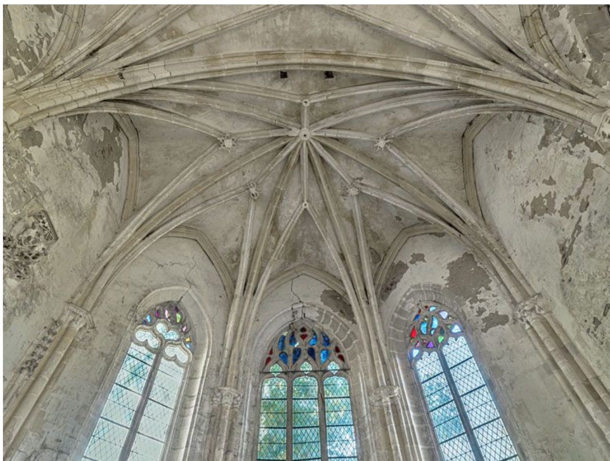
Intérieur de la chapelle : voûtes du choeur.
