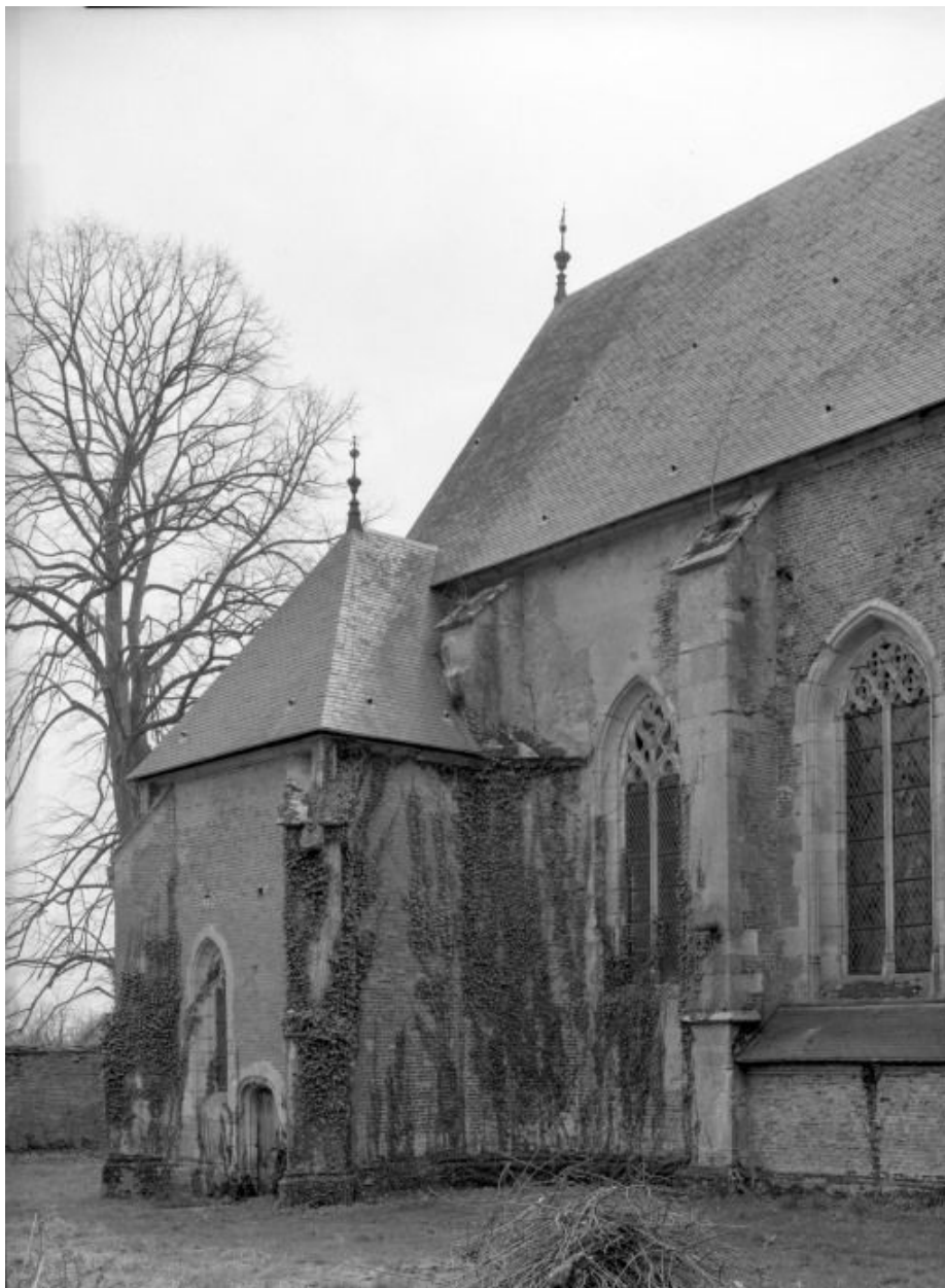
Chapelle de l'ancien château, élévation gauche.
