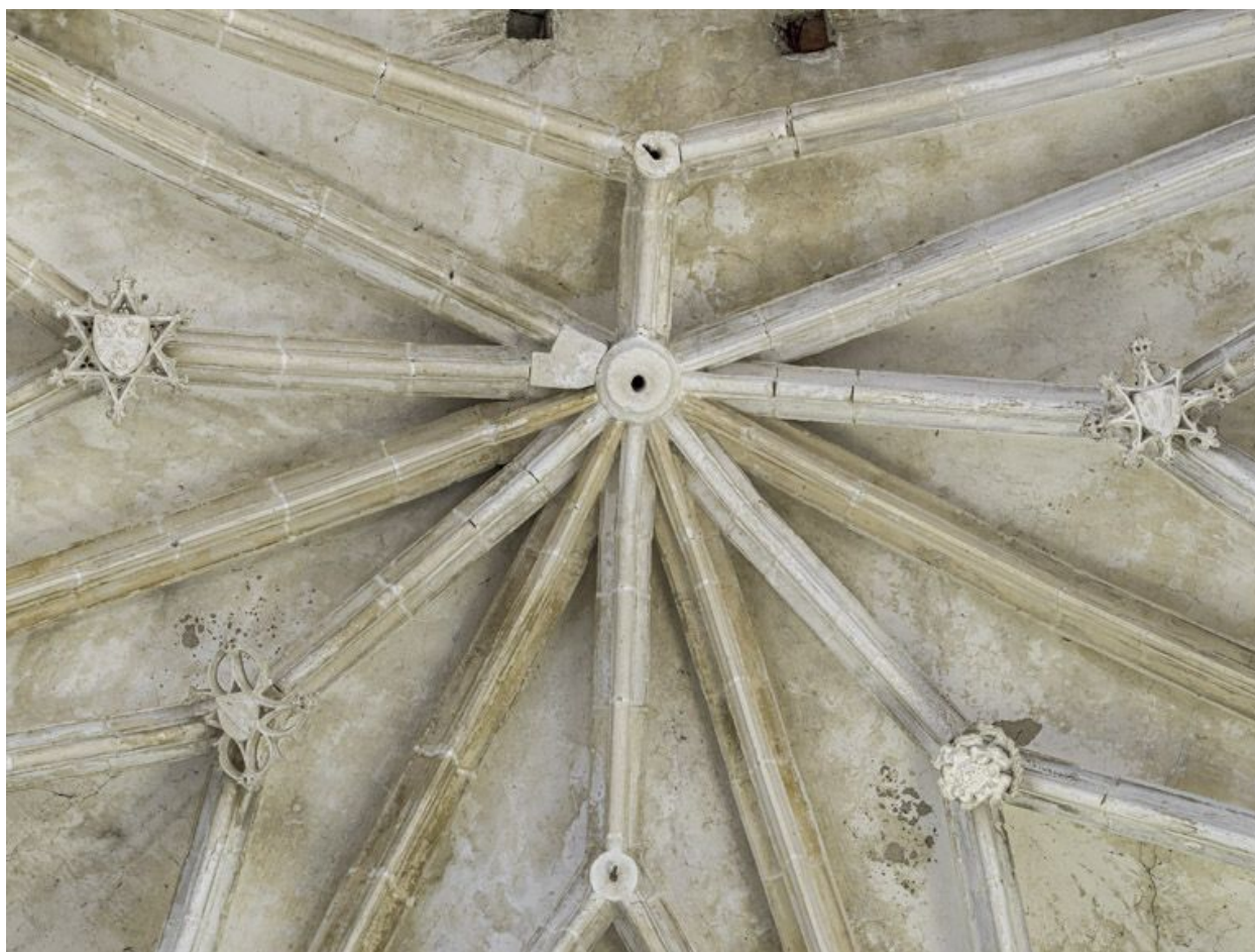
Intérieur de la chapelle : voûtes du chœur.
