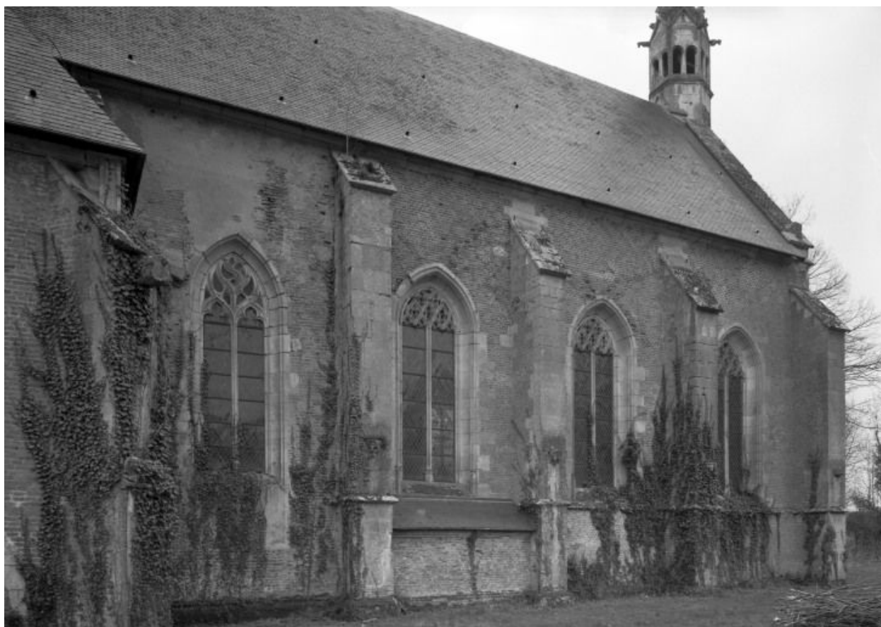
Chapelle de l'ancien château, élévation gauche.
