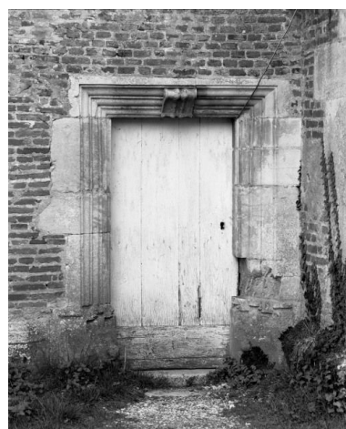
Chapelle de l'ancien château : porte latérale droite de la nef. Phot. Jean-Luc Duthu IVR26_19872100306X
