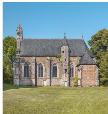
Elévation latérale droite de la chapelle. Phot. Thierry Kuntz IVR26_20182100284NUC4A
