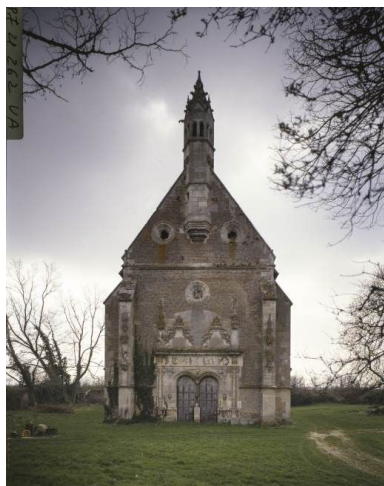
Chapelle de l'ancien château, façade. Phot. Michel Thierry IVR26_19872100262VA
