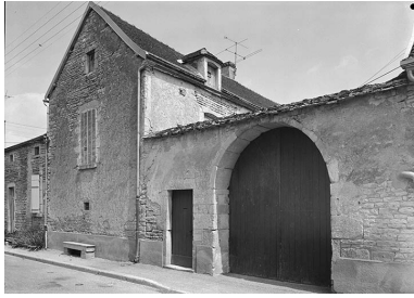
Mur-pignon et portail sur rue.
