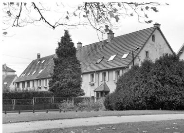
Logements ouvriers de l'usine métallurgique. Phot. Jérôme Mongreville IVR43_20019000746X
