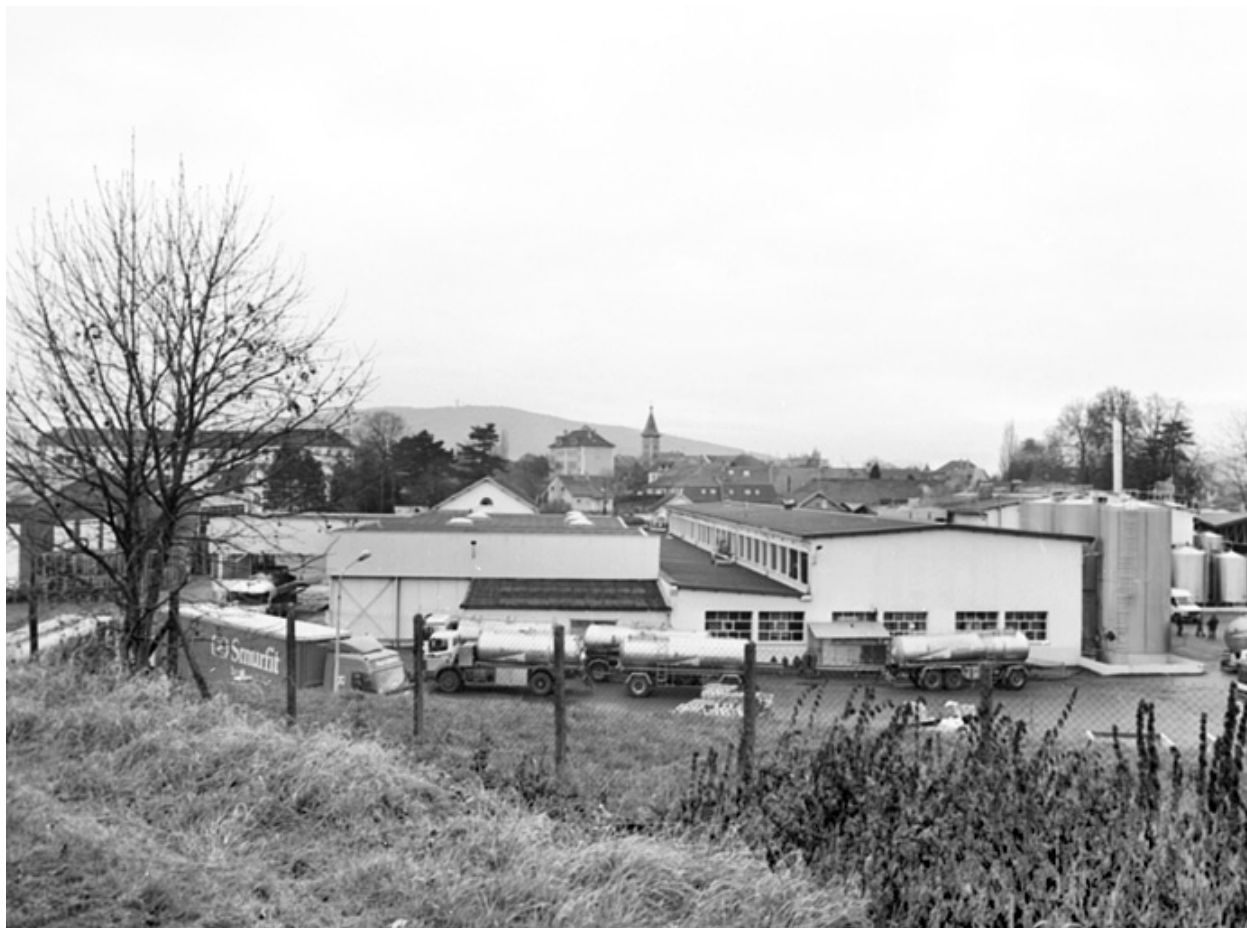
Vue plongeante sur les ateliers depuis l'est.
