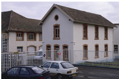
Anciens bureaux (?) de l'usine de teinturerie. Phot. Jérôme Mongreville IVR43_20019000745ZA
