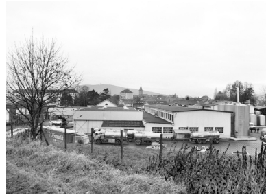
Vue plongeante sur les ateliers depuis l'est. Phot. Jérôme Mongreville IVR43_20019000753X
