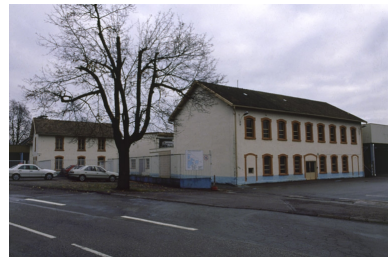
Bâtiments (bureaux ?) de l'usine de teinturerie. Phot. Jérôme Mongreville IVR43_20019000743ZA
