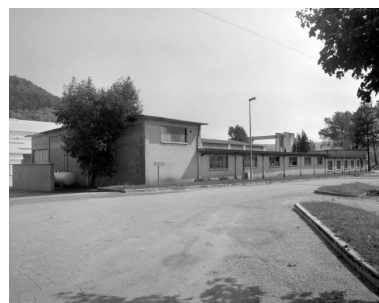
Façade ouest de l'atelier de réparation. Phot. Yves Sancey IVR43_19973901564X
