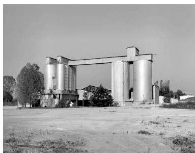
Magasin industriel et atelier de conditionnement. Phot. Yves Sancey IVR43_19973901547X
