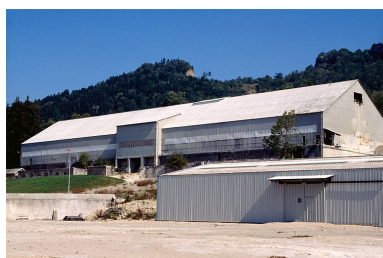
Hall de préhomogénéisation. Phot. Yves Sancey IVR43_19973901550ZA
