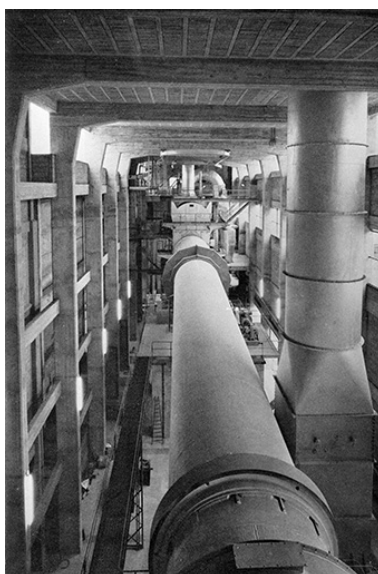
Vue d'ensemble du four rotatif. Phot. Jérôme Mongreville IVR43_19973900961X
