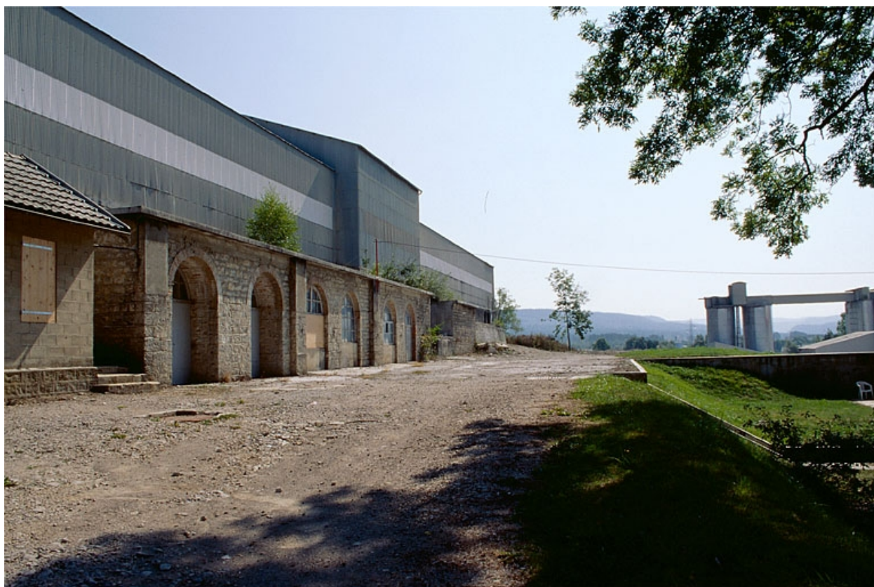
Vestiges des chambres d'extinction et hall de préhomogénéisation.
