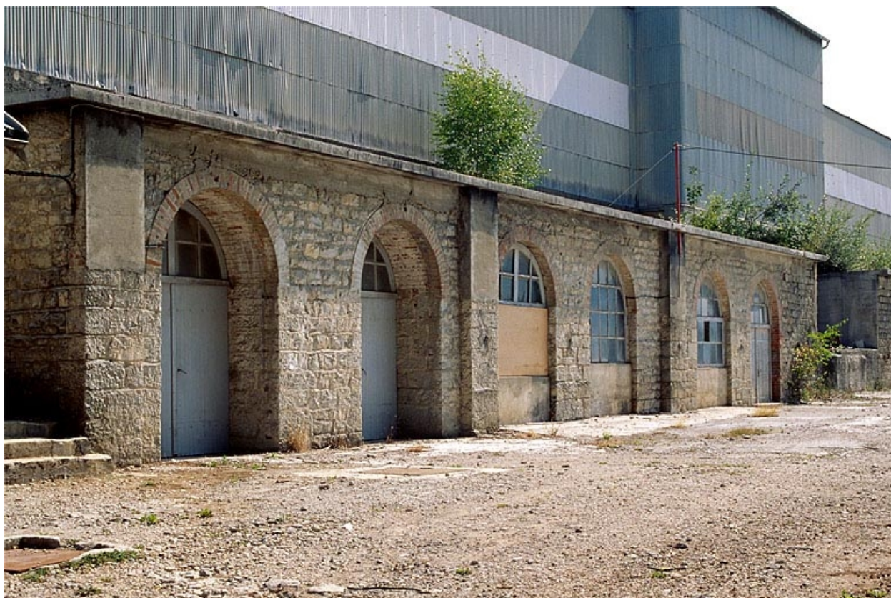
Baies cintrées des chambres d'extinction.
