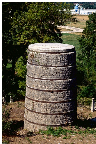
Vue plongeante sur le four à chaux. Phot. Yves Sancey IVR43_19973901558ZA
