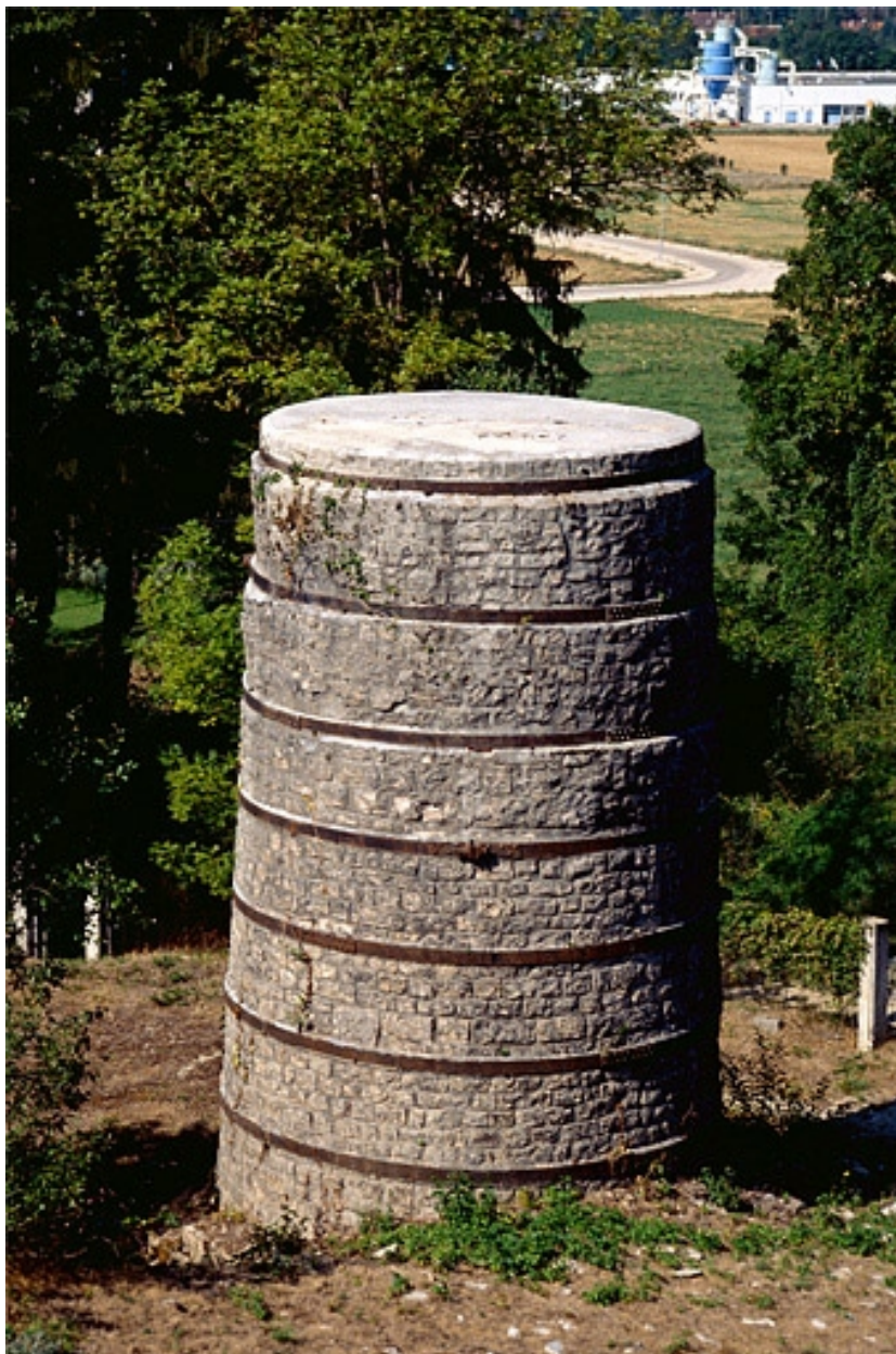
Vue plongeante sur le four à chaux.
