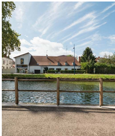
Vue actuelle de l'ancien emplacement de l'aqueduc. Phot. Pierre-Marie Barbe-Richaud IVR26_20177100254NUC2A
