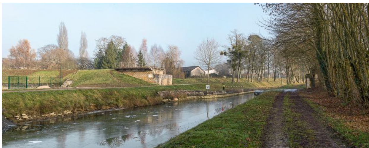
Vue d'aval des culées.
