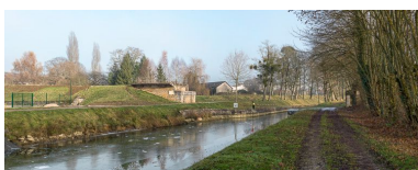
Vue d'aval des culées.
