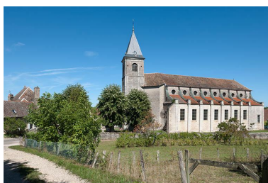
Vue sud Phot. Jérôme Mongreville IVR43_20137000226NUCA
