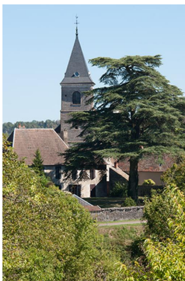
Vue ouest Phot. Jérôme Mongreville IVR43_20137000238NUCA
