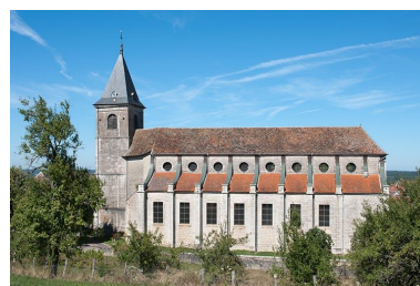
Vue sud Phot. Jérôme Mongreville IVR43_20137000229NUCA
