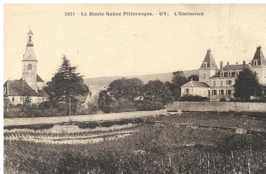
L'église sur une carte postale ancienne IVR43_20137000781NUC2A
