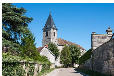
Vue ouest Phot. Jérôme Mongreville IVR43_20137000240NUCA
