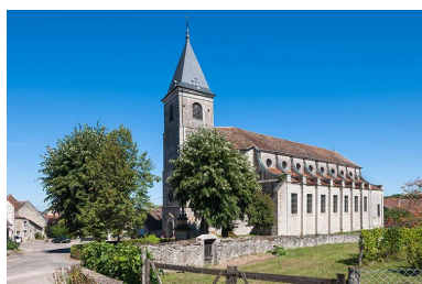
Vue générale sud-ouest Phot. Jérôme Mongreville IVR43_20137000222NUCA
