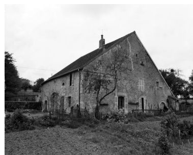
Ferme située rue du Quart d'Avaud : vue d'ensemble. Phot. Yves Sancey IVR43 19813900154X
