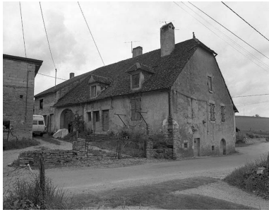
Ferme située rue des Louvarets : vue d'ensemble. Phot. Yves Sancey IVR43_19813900151X
