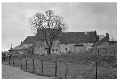
Maison, fin XVIIIe siècle : vue depuis le chemin Phot. Guy Forestier IVR43_19743900416Z
