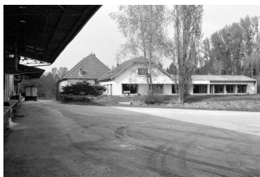
Façade postérieure du bureau.
