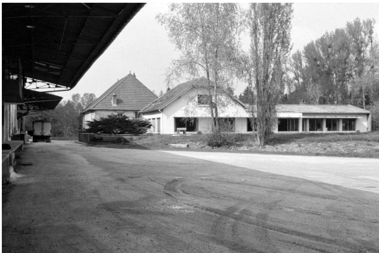
Façade postérieure du bureau.
