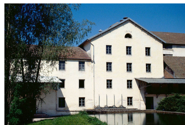
Façade antérieure de l'atelier de fabrication (L).
