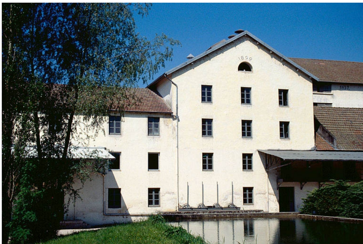
Façade antérieure de l'atelier de fabrication (L).
