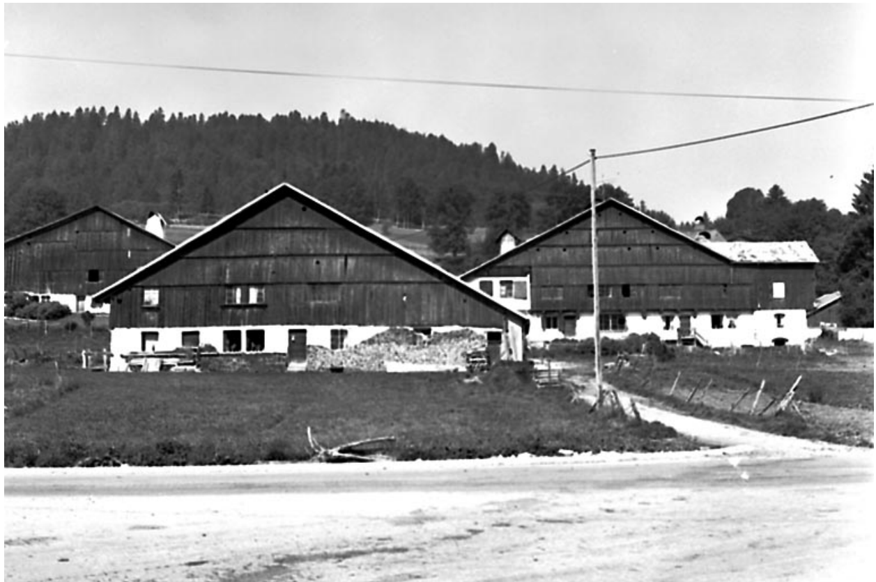
hameau des Cordiers : façades antérieures des fermes.
