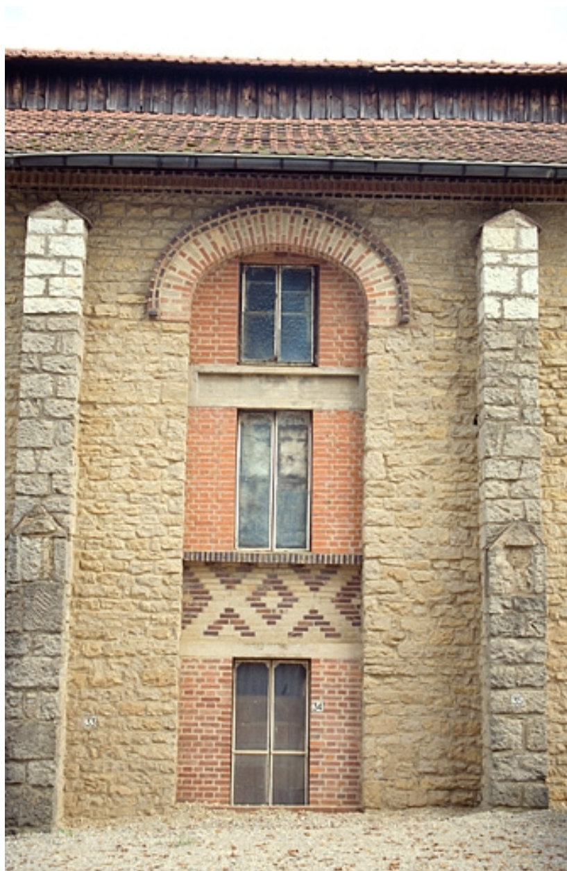
Atelier (A) : détail d'une travée étroite.
