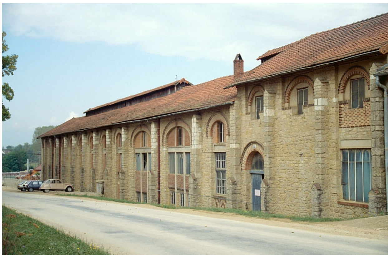
Atelier (A) : façade sur route.
