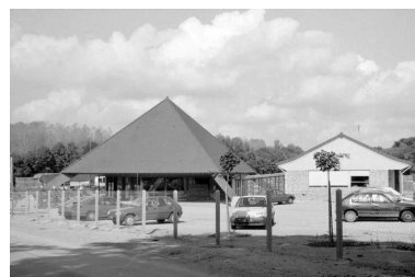
Bureau (N) et salle de réunion (N'). Phot. Laurent Poupard IVR43_19893900049Z
