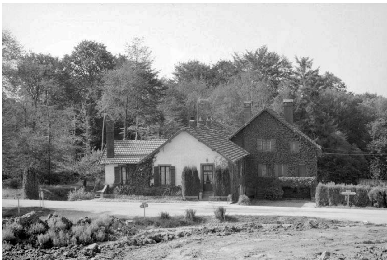
Logement d'ouvriers (Q, Q'), vu de l'est.
