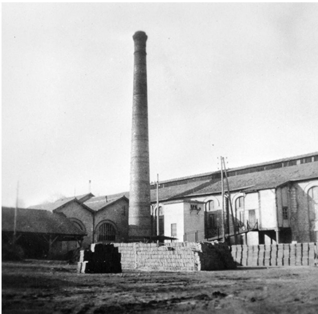
Ateliers et cheminée vus du nord.
