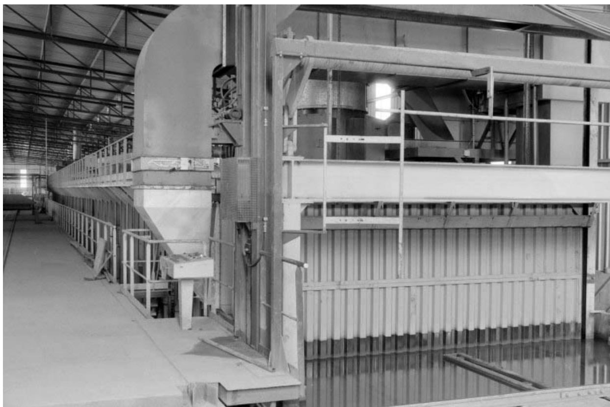
Atelier (M) : four à bassin.
