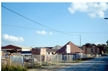
Vue d'ensemble depuis l'ouest. Phot. Laurent Poupard IVR43_19893900042ZA
