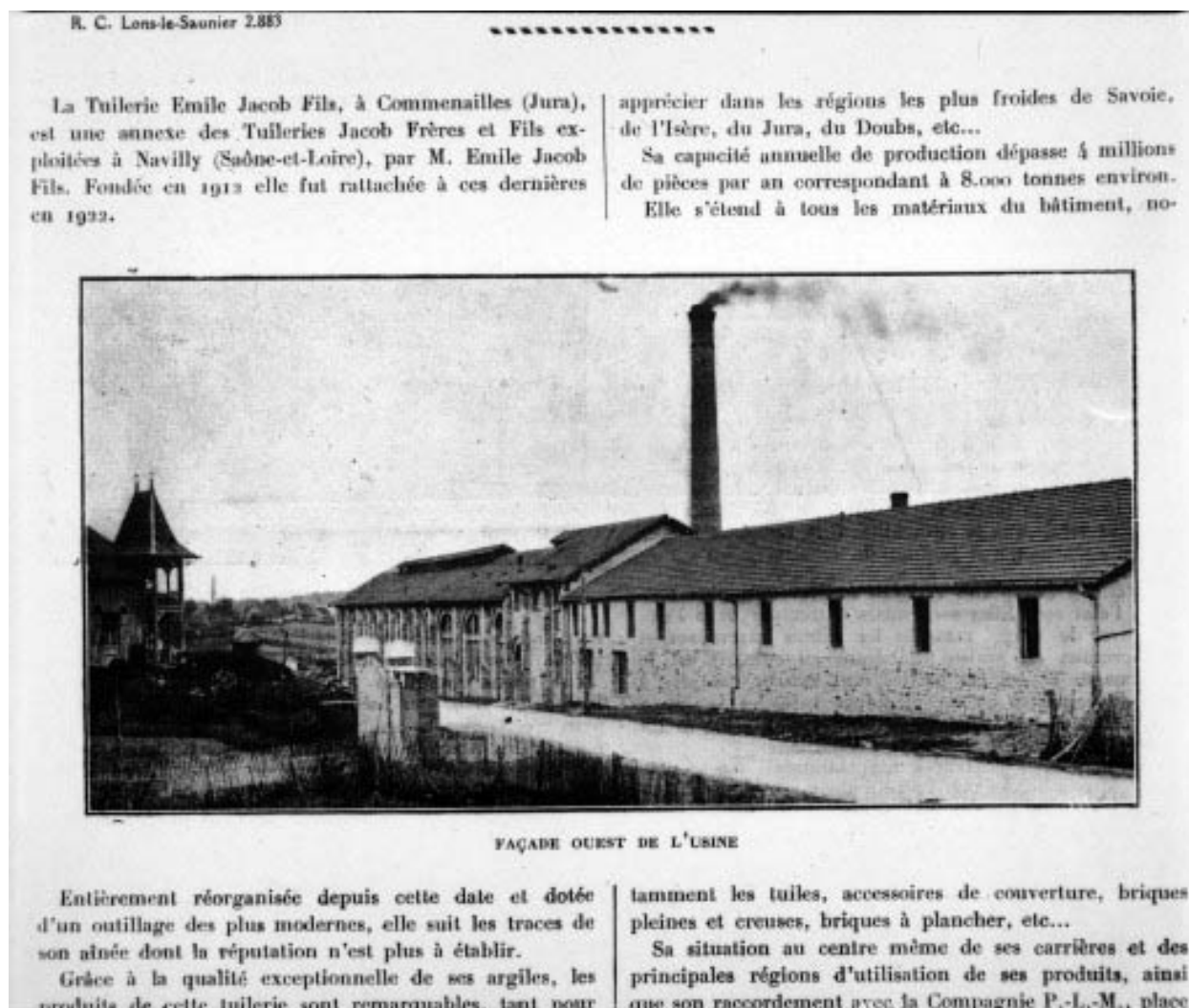
Façade ouest de l'usine, milieu des années 1920.
