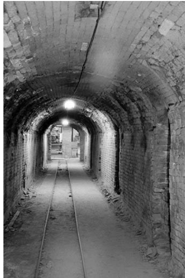
Atelier (A) : intérieur de l'ancien four Hoffmann. Phot. Laurent Poupard IVR43_19893900053Z
