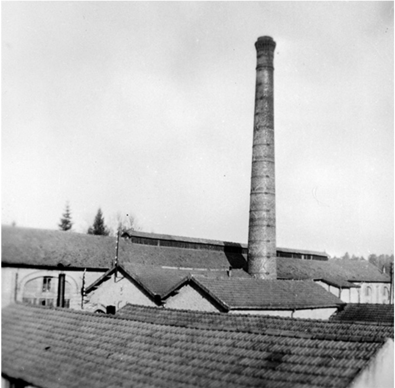
Ateliers et cheminée vus de l'est.
