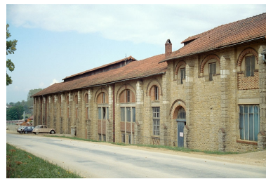
Atelier (A) : façade sur route. Phot. Laurent Poupard IVR43_19893900045ZA
