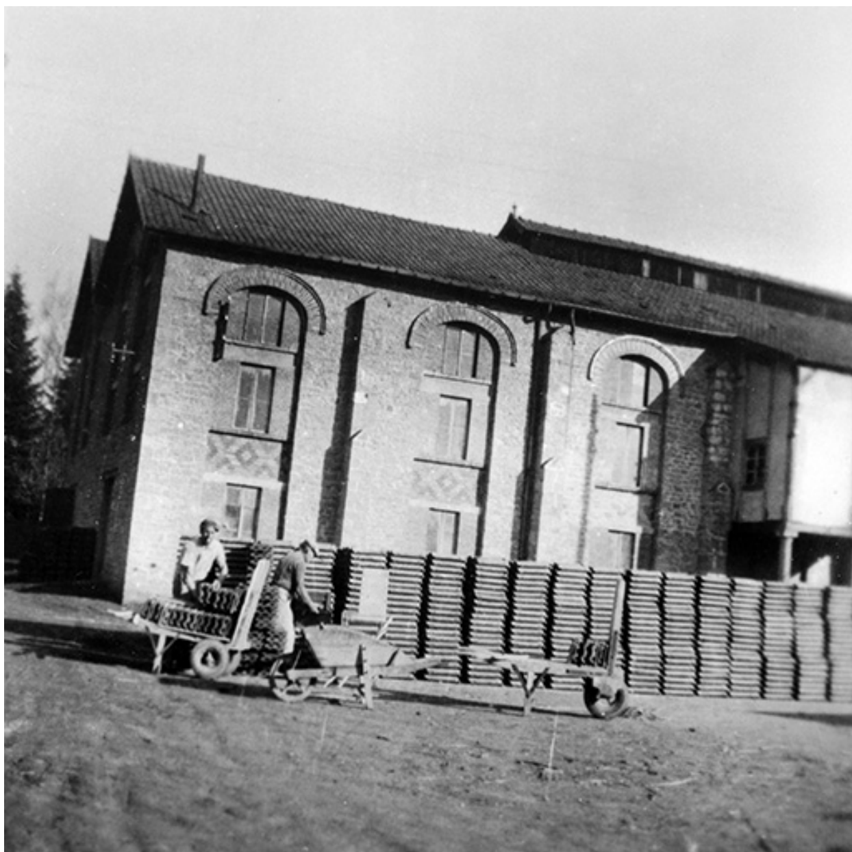
Stockage des tuiles cuites en plein air.
