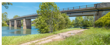
Vue d'ensemble du pont, de la rive droite. Phot. Thierry Kuntz IVR26_20172100212NUC4A
