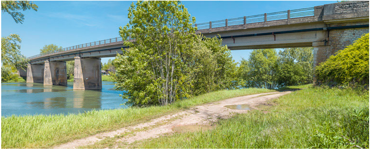
Vue d'ensemble du pont, de la rive droite.
