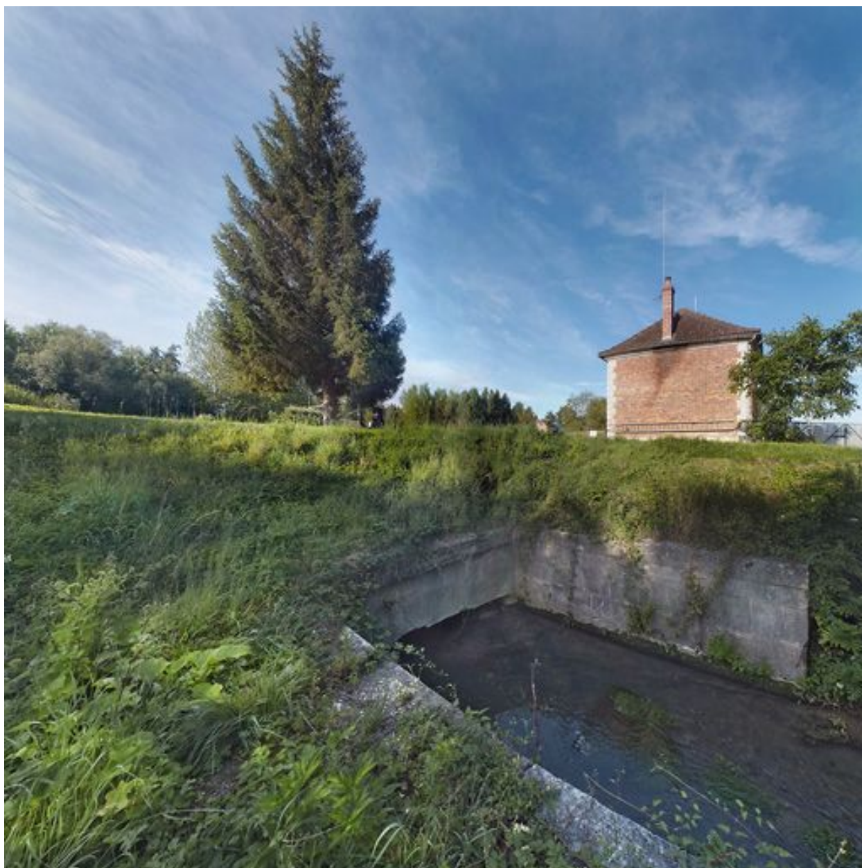
Entrée de l'aqueduc.
