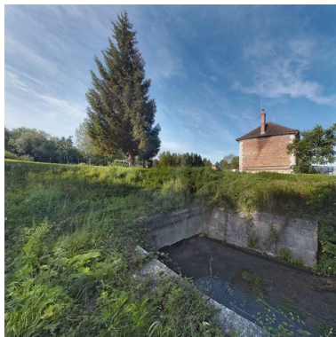
Entrée de l'aqueduc. Phot. Thierry Kuntz IVR26_20118900197NUC4A
