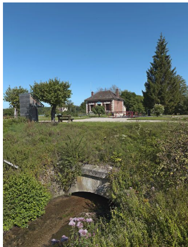
Sortie de l'aqueduc. Phot. Thierry Kuntz IVR26_20118900203NUC4A
