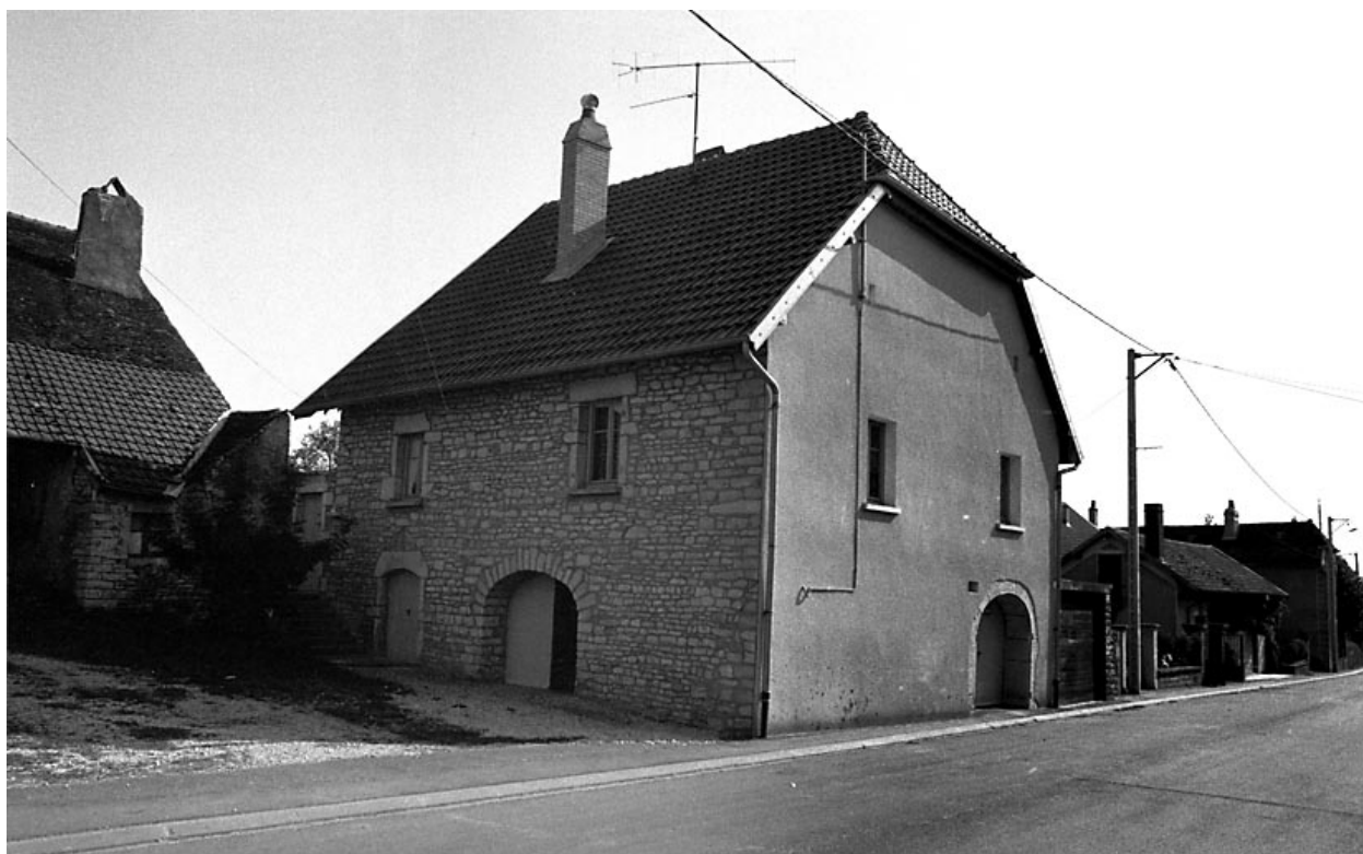
Brussey : maison de vigneron située Grande Rue.
