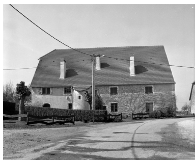
Bonboillon : ferme située place de la Mairie. Phot. Yves Sancey IVR43_19827000475X
