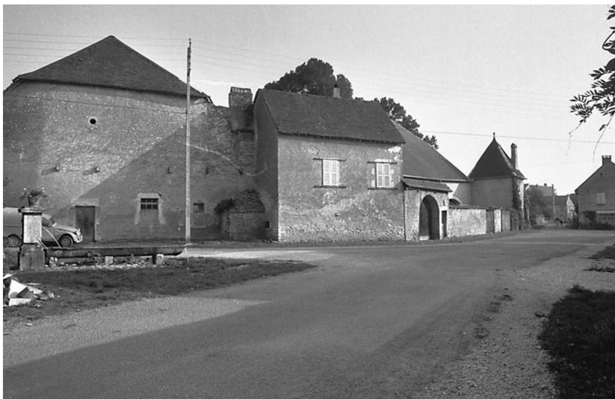
Sornay : maison située rue Basse.
