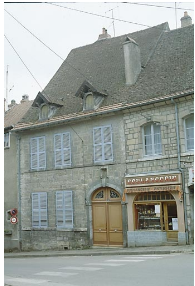
Marnay : maison située Grande Rue. Phot. Yves Sancey IVR43_19827000522XA
