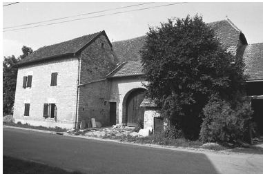
Vregille : ferme située chemin rural du Pré Simon. Phot. Bernard Lardière IVR43_19797000324Z
